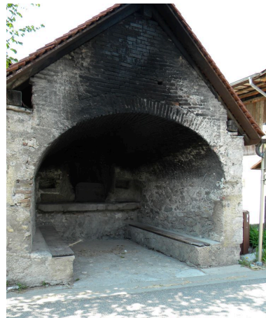
Vue du fournil. Phot. Jérôme Daviet IVR82_20107402658NUCA
