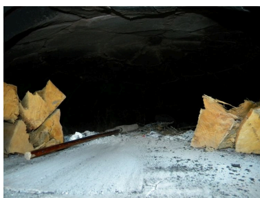
Vue de la voute de cuisson. Phot. Jérôme Daviet IVR82_20107402660NUCA
