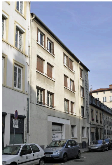
Elévation sur rue, vue générale Phot. Magali Delavenne IVR84_20166902204NUCA
