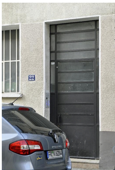
Vue de la porte d'entrée Phot. Magali Delavenne IVR84_20166902206NUCA
