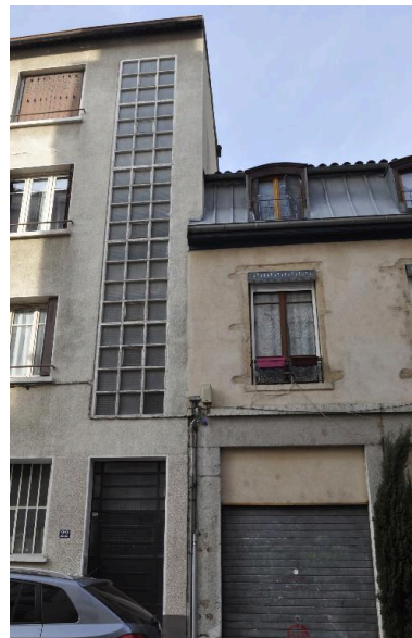
Elévation sur rue, vitrage éclairant l'escalier latéral en revers de façade Phot. Magali Delavenne IVR84_20166902205NUCA
