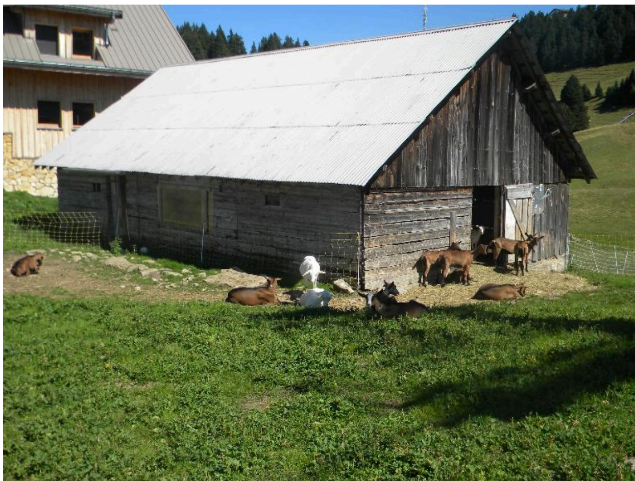
Vue de trois-quarts sud-ouest de la porcherie et étable à chèvres.
