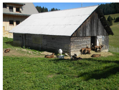
Vue de trois-quarts sud-ouest de la porcherie et étable à chèvres. Phot. Thierry Monnet IVR82_20157402294NUCA
