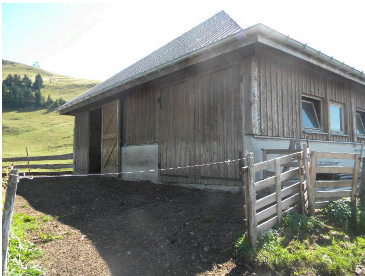
Vue du pignon nord de l'étable.
