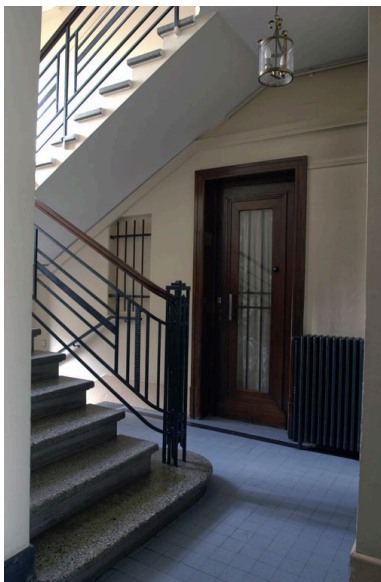
Départ de l'escalier et porte de la loge de concierge Phot. Maryannick Chalabi IVR82_20116904185NUCA
