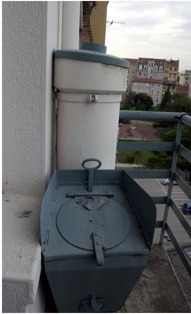
Un vide-ordures Phot. Maryannick Chalabi IVR82_20126902465NUC
