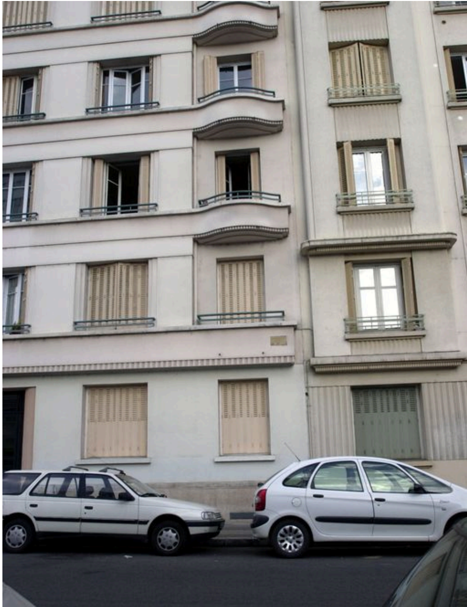
Elévation antérieure, détail
