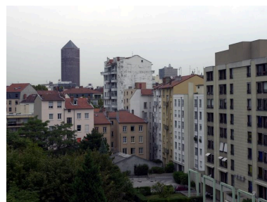
Vue générale des élévations postérieures des immeubles 338,340 et 342 rue André-Philip Phot. Maryannick Chalabi IVR82_20116904193NUCA
