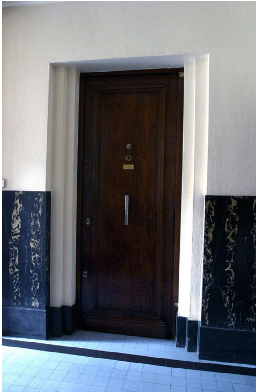
Rez-de-chaussée, porte palière
