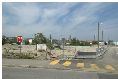
Vue sud du terrain nu Phot. Nadine Halitim-Dubois IVR82_20086900461NUCA
