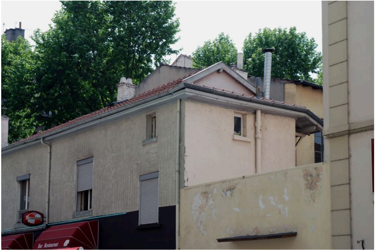
Elévation postérieure, détail.
