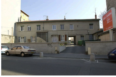
Elévation antérieure Phot. Bernard Ducouret IVR82_20036903186NUCA
