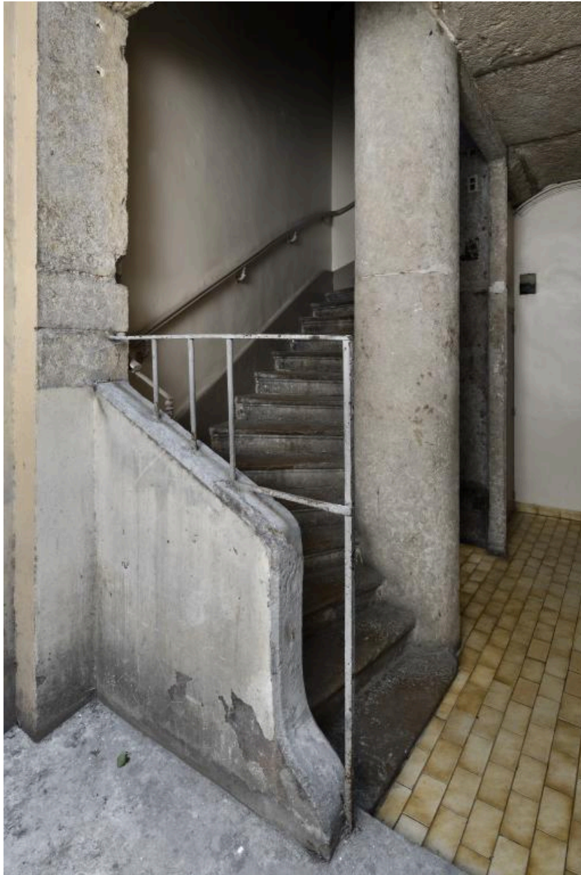
Le départ d'escalier depuis la cour
