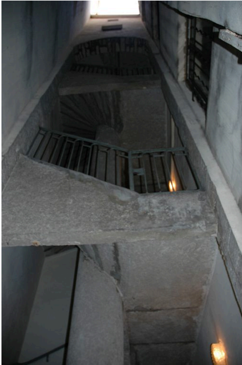
La cage d'escalier depuis la cour
