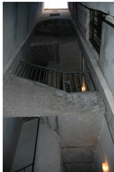
La cage d'escalier depuis la cour Phot. Véronique Belle IVR82_20066902541NUCA
