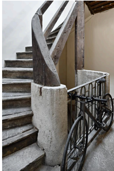
L'escalier : dernière volée, en bois Phot. Thierry Leroy IVR84_20196900483NUCAQ
