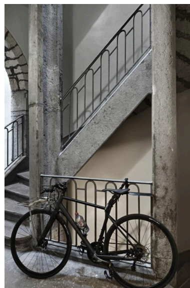
L'escalier : noyaux, limon et garde-corps Phot. Thierry Leroy IVR84_20196900493NUCAQ
