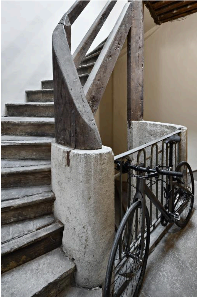
L'escalier : dernière volée, en bois
