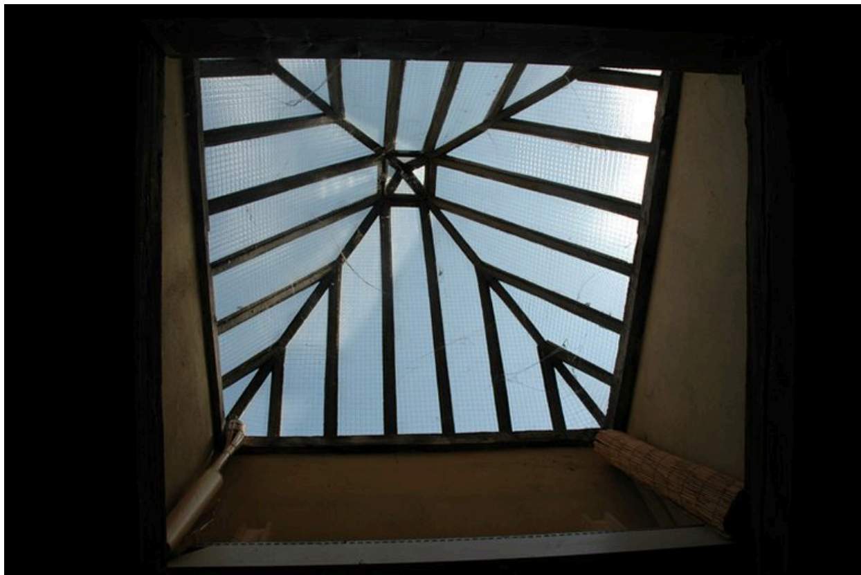
La cage d'escalier : éclairage zénithal par un ciel ouvert
