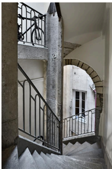
L'escalier : volée, noyau et garde-corps Phot. Thierry Leroy IVR84_20196900480NUCAQ
