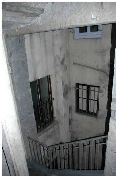
La cour depuis la cage d'escalier ouverte Phot. Véronique Belle IVR82_20066902546NUCA
