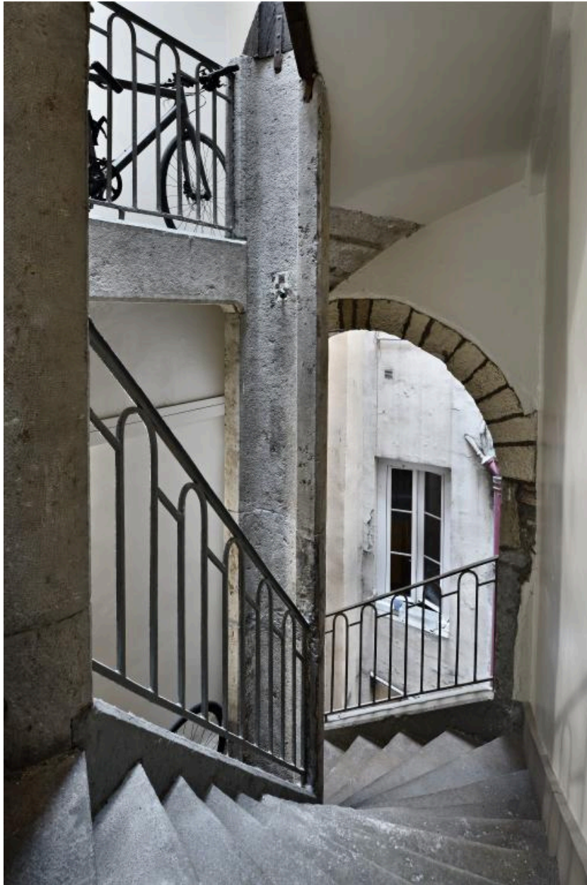
L'escalier : volée, noyau et garde-corps
