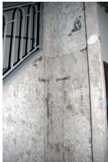
L'escalier : détail d'assemblage Phot. Véronique Belle IVR82_20066902547NUCA
