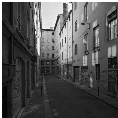
Elévation antérieure : il s'agit du deuxième immeuble à partir de la droite Phot. Eric Dessert IVR82_20066900461NUC
