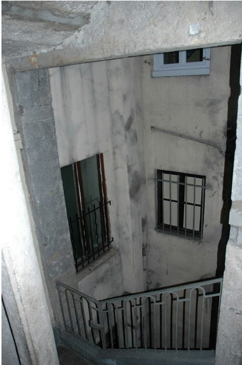
La cour depuis la cage d'escalier ouverte
