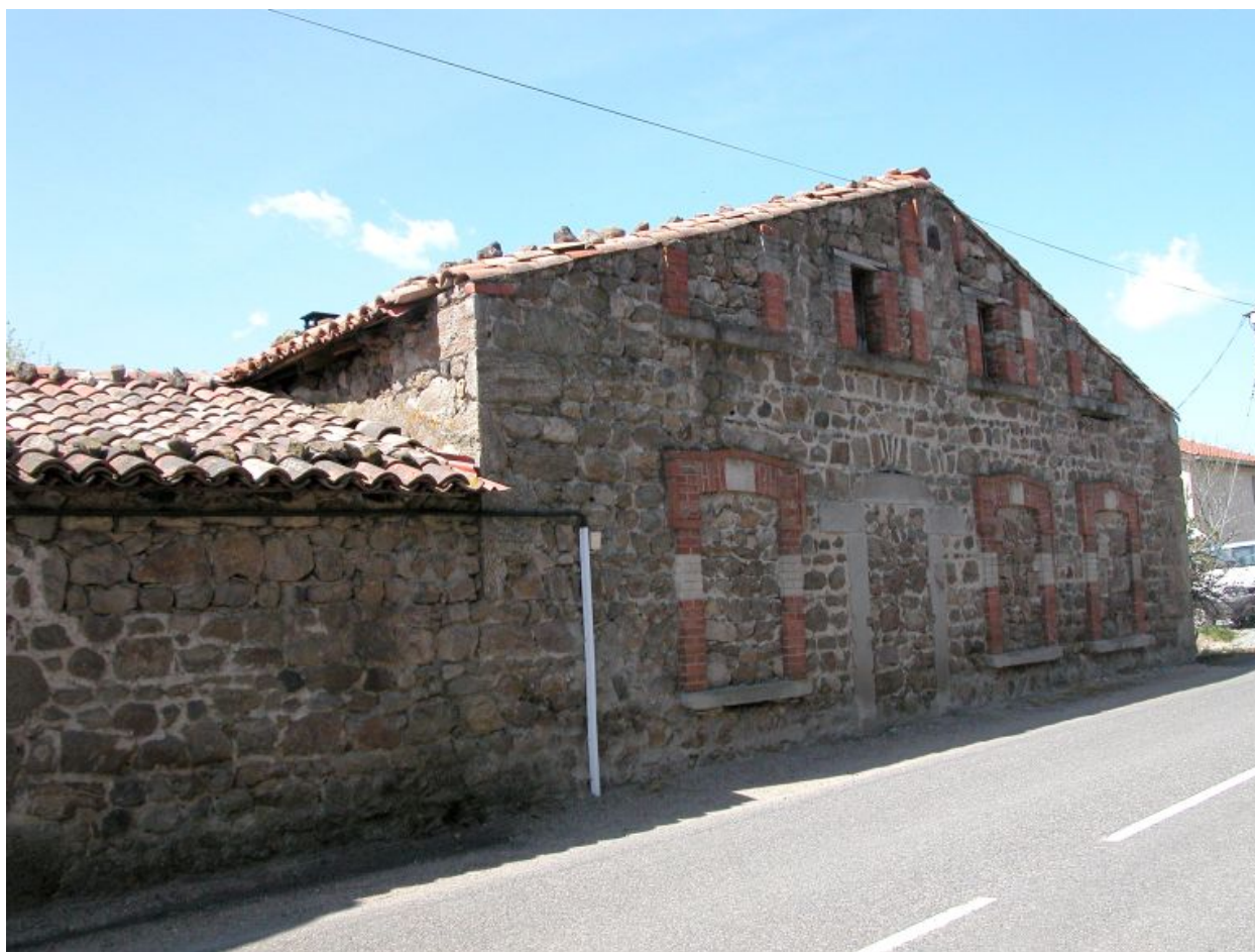
Vue d'ensemble de l'élévation latérale droite de la ferme sur rue.
