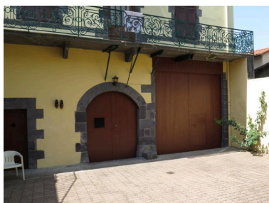
Entrées du cuveau et de la cave Phot. Bruno Decrock IVR84_20206300120NUCA
