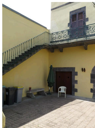
Vue partielle de l'escalier et du balcon Phot. Bruno Decrock IVR84_20206300121NUCA
