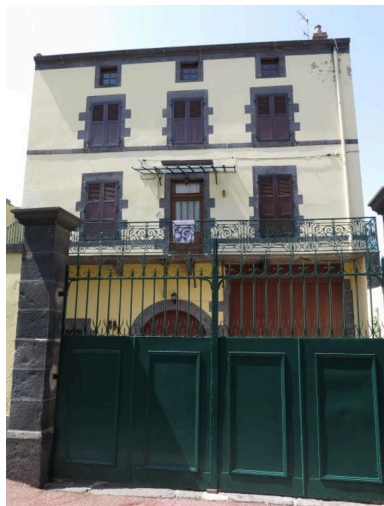
Vue générale de la façade principale Phot. Bruno Decrock IVR84_20206300116NUCA
