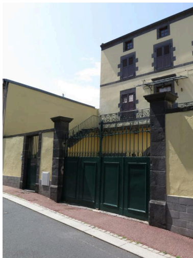
Portails d'entrée Phot. Bruno Decrock IVR84_20206300117NUCA
