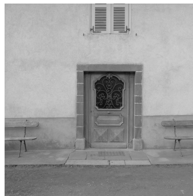
Porte d'entrée du logis. Phot. Eric Dessert IVR82_20034200953X
