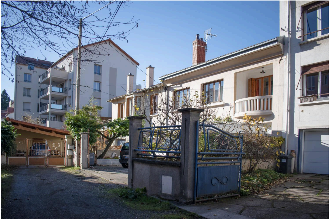
Façades sur la voie de desserte
