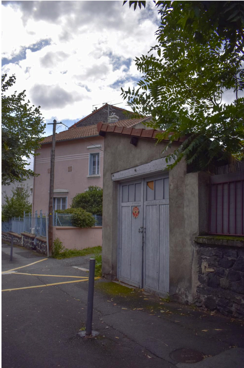
Maison et garage automobile de part et d'autre de l'impasse desservant le lotissement Loradoux
