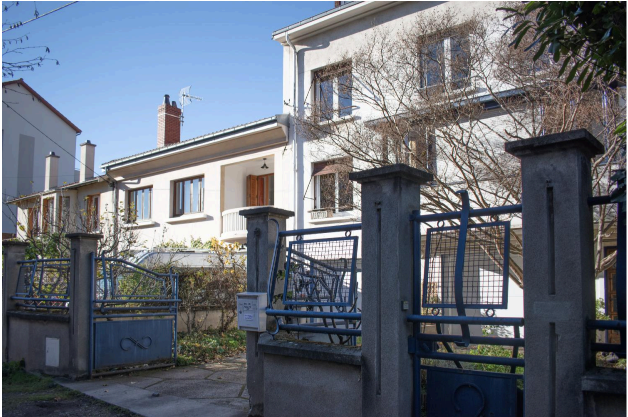
Façades sur la voie de desserte
