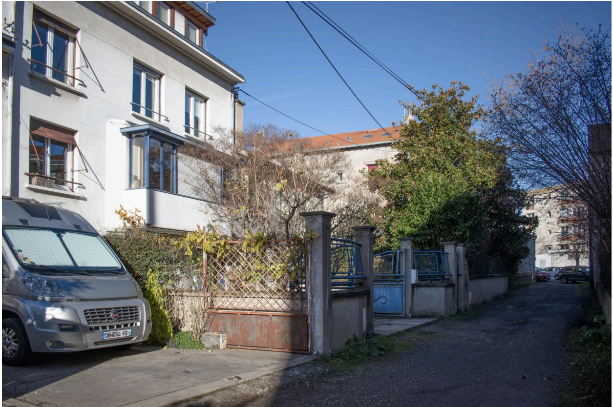
Façade sur la voie de desserte
