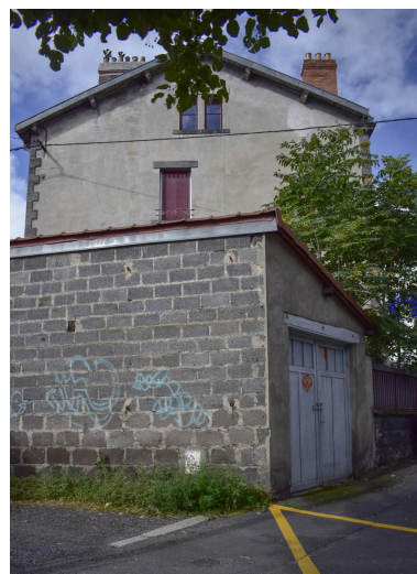
Garage automobile à l'entrée du lotissement Loradoux. A l'arrière-plan, pignon de l'immeuble au 83 boulevard Jean-Jaurès Phot. Félicie Fougère IVR84_20256302186NUCA
