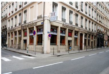
Détail du rez-de-chaussée (boutique de pianos Hanlet) Phot. Catherine Guégan IVR82_20126902673NUCA
