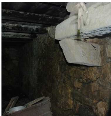
Vue intérieure de l'habitation : cheminée en pierre. Phot. Caroline Guibaud IVR84_20167304799NUCA
