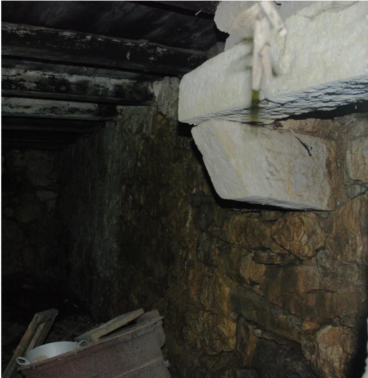
Vue intérieure de l'habitation : cheminée en pierre.
