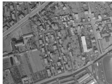
Vue aérienne de la cité, 19/05/1953. Phot. Brigitte Ceroni IVR84_20236300851NUC
