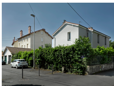
Au premier plan, maison double à petit avant-corps, à l'angle de l'avenue de la République et de l'allée des Acacias ; à l'arrière, l'un des immeubles collectifs pour ingénieurs. Phot. Christian Parisey IVR84_20206300905NUC4A
