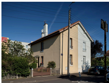
Maisons doubles de la rue Antoine-Bellet. Phot. Christian Parisey IVR84_20246301352NUC4A
