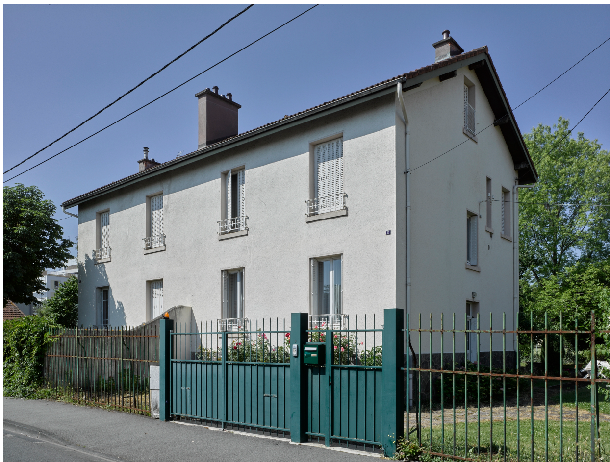
Maison double d'ingénieurs à rez-de-chaussée surélevé, un étage et étage de comble, du côté ouest de l'allée des Marronniers.
