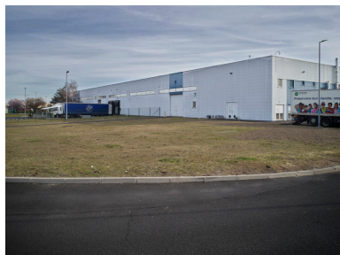
Le bâtiment 01, au sud du site, destiné à la préparation de produits et au stockage. Phot. Christian Parisey IVR84_20226300387NUCA
