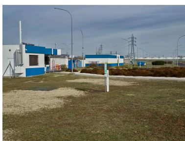
Le poste d'entrée nord et le local pour les deux-roues, vus en direction du nord. À l'arrière-plan, les entrepôts du site Michelin de Chantemerle. Phot. Christian Parisey IVR84_20226300394NUCA
