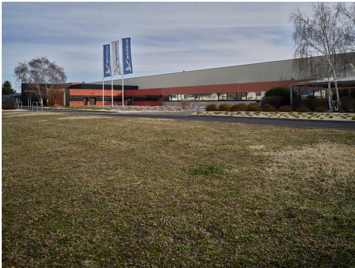
Les ateliers 560 (fabrication) et en avancée, le bâtiment du showroom.
