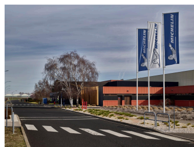
Le bâtiment du showroom, accolé à la façade ouest des ateliers 560. Phot. Christian Parisey IVR84_20226300393NUCA
