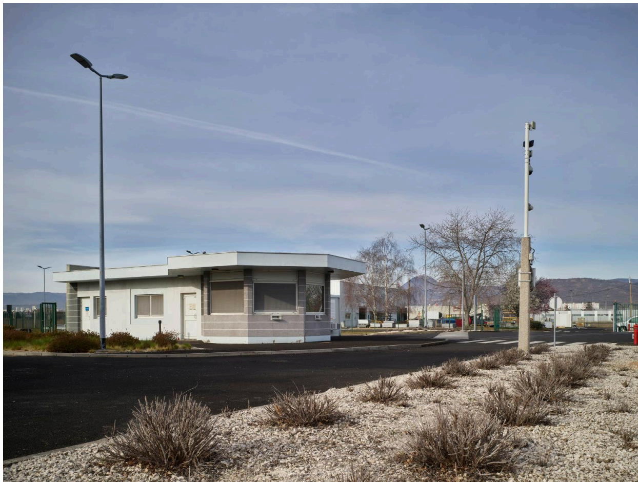
Poste de garde de l'entrée sud, vu depuis le nord-est.
