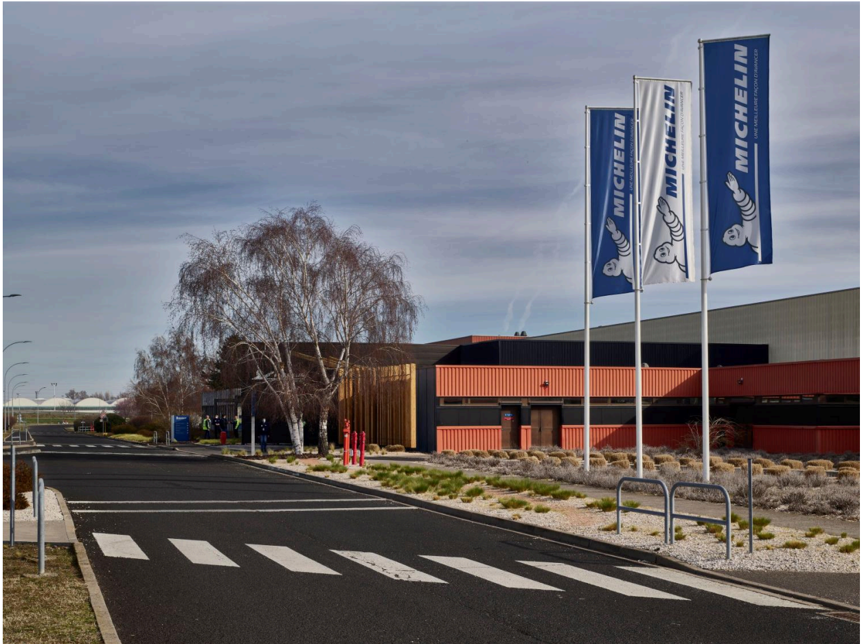
Le bâtiment du showroom, accolé à la façade ouest des ateliers 560.
