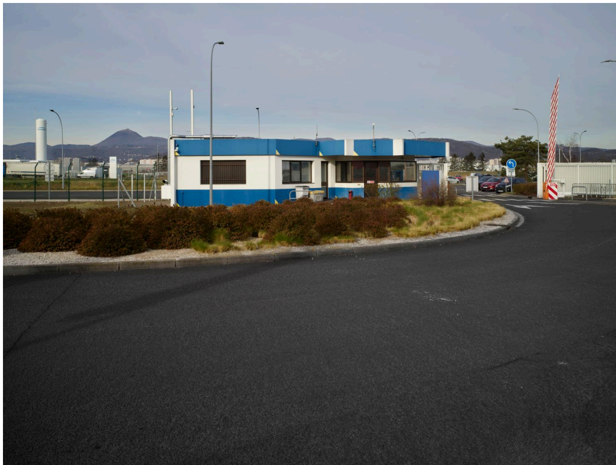
Poste de garde, entrée nord, depuis l'intérieur du site. À l'arrière-plan, le puy de Dôme.
