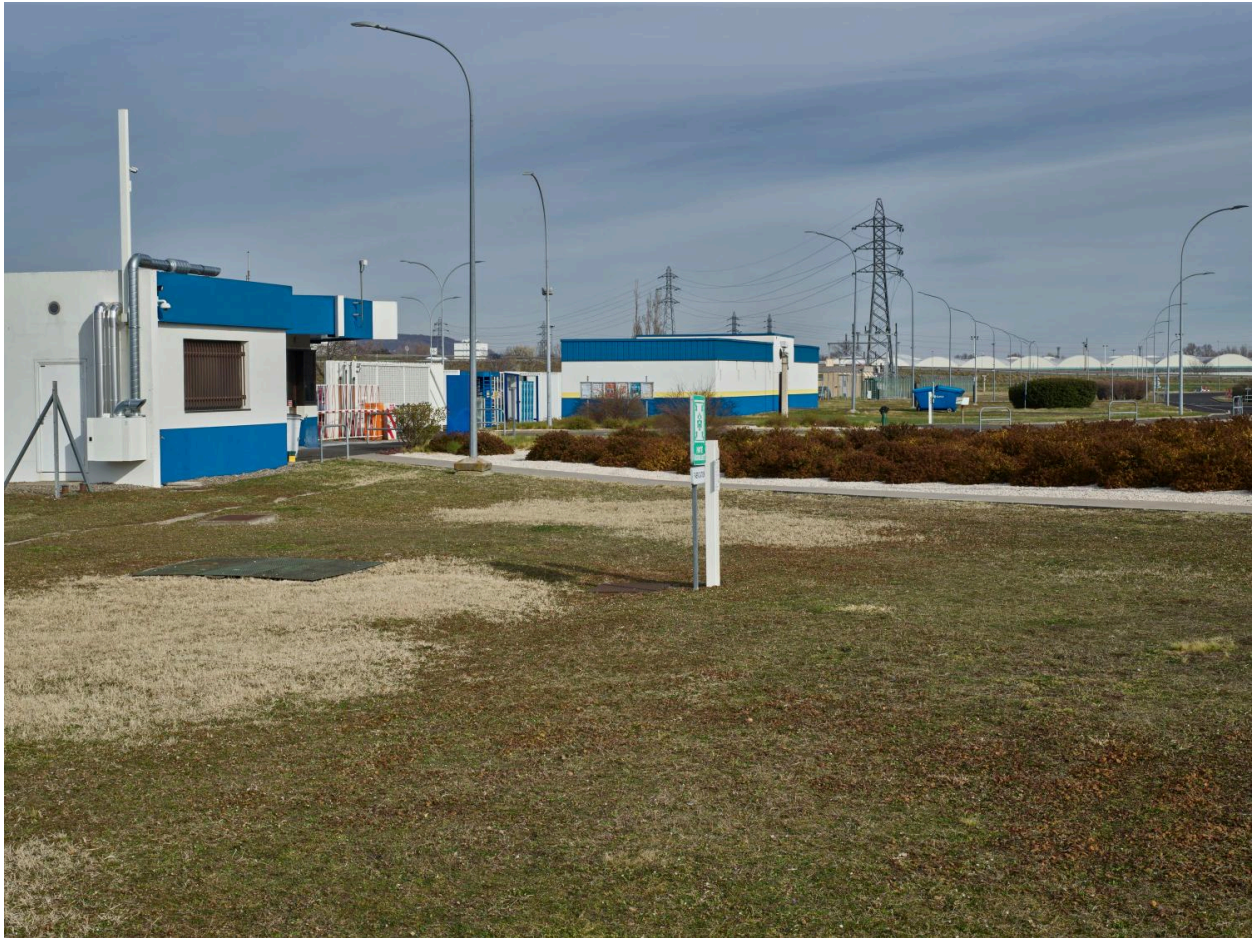
Le poste d'entrée nord et le local pour les deux-roues, vus en direction du nord. À l'arrière-plan, les entrepôts du site Michelin de Chantemerle.
