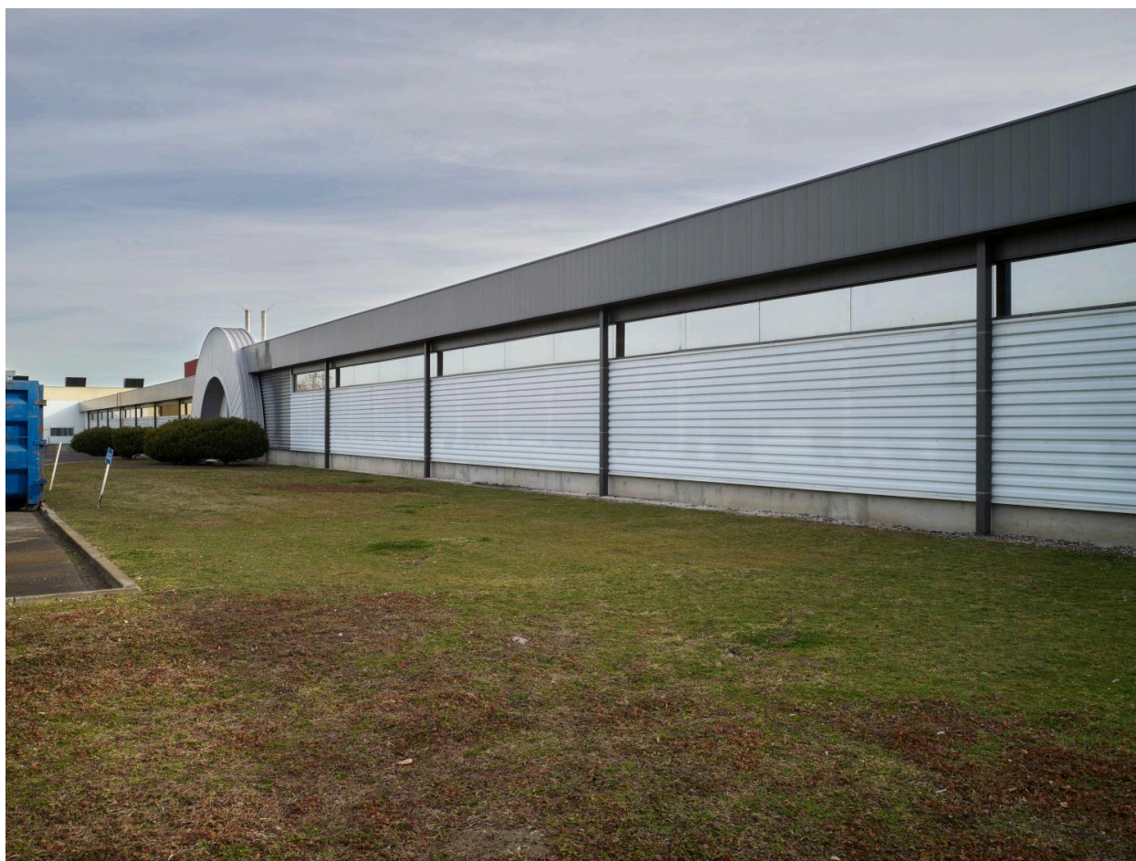
Le bâtiment de stockage 520, vu depuis le sud-ouest.
