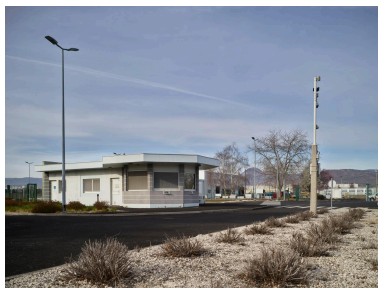
Poste de garde de l'entrée sud, vu depuis le nord-est. Phot. Christian Parisey IVR84_20226300388NUCA
