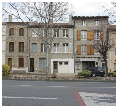
Vue générale (2e maison à partir de la gauche). Phot. Eric Dessert IVR82_20064200287NUCA
