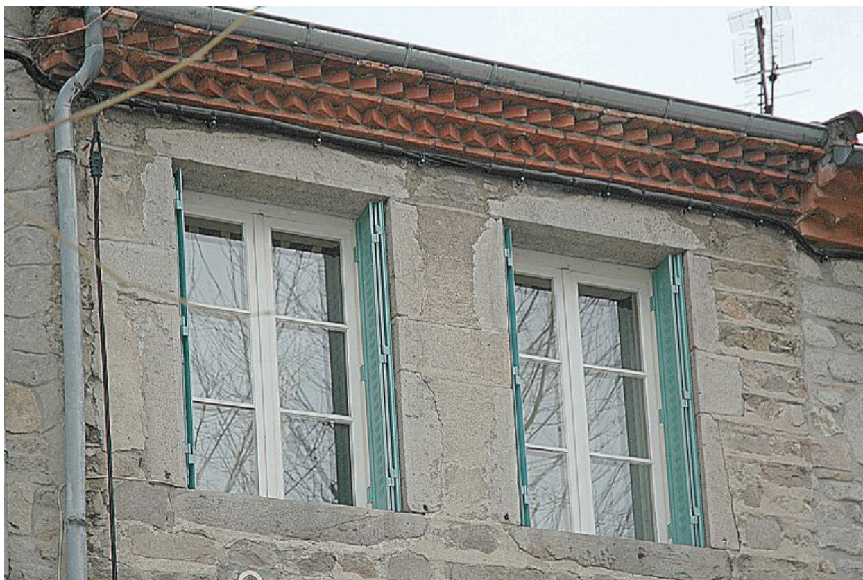
Détail : corniche en brique.
