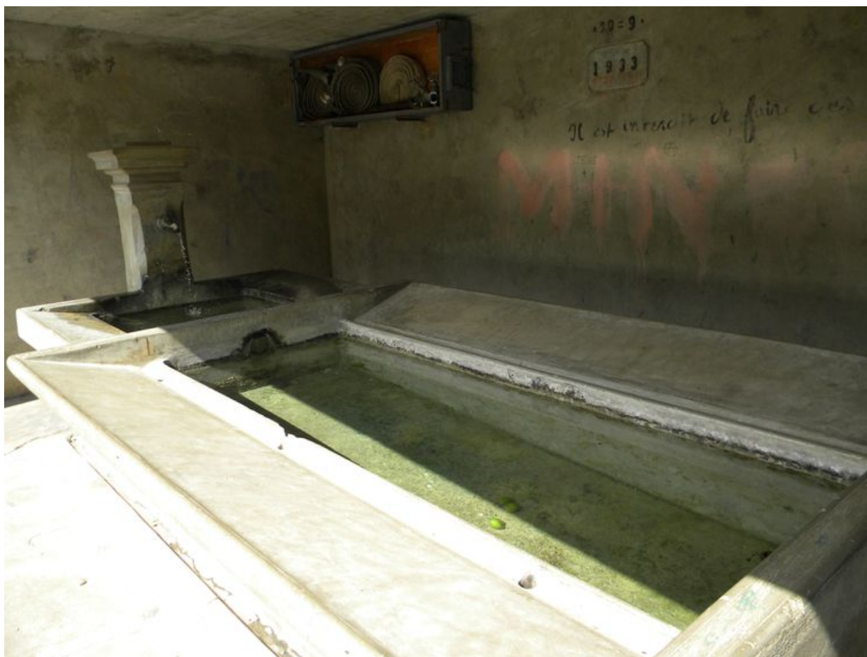
Vue d'ensemble de la fontaine-lavoir.
