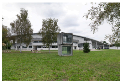
L'installation dans son environnement. Phot. Thierry Leroy IVR84_20203800441NUCAQ
