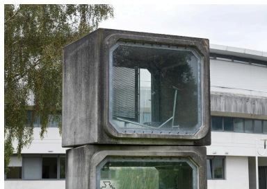
Détail sur le cube supérieur. Phot. Thierry Leroy IVR84_20203800442NUCAQ
