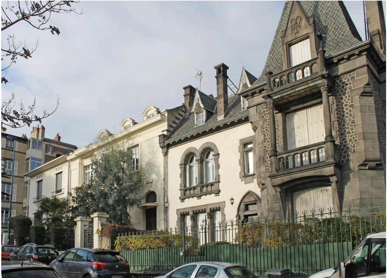
Clermont-Ferrand, la Maison B. dans le front bâti de la rue d'Amboise (avec les façades principales des maisons aux numéros 3 et 5).
