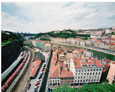
Vue d'ensemble nord des immeubles Mangini Phot. Eric Dessert IVR82_20046901212VE
