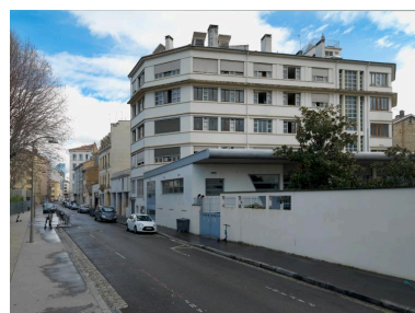
Vue d'ensemble depuis le sud-ouest Phot. Franck Trabouillet IVR84_20196900277NUCA
