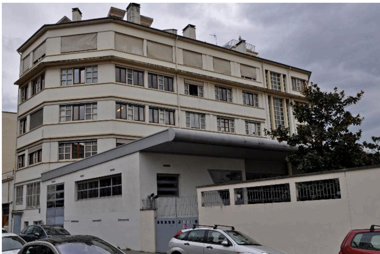
Vue d'ensemble depuis la rue Cluzan
