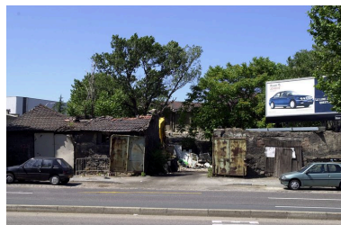
Vue générale depuis l'avenue Tony-Garnier Phot. Bernard Ducouret IVR82_20026901943NUCA
