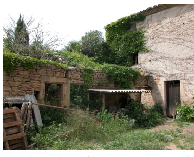
Vestiges de petites dépendances de la ferme : porcherie et poulailler, sur le côté ouest de la cour. Phot. Geneviève Jourdan IVR82_20092600460NUCA
