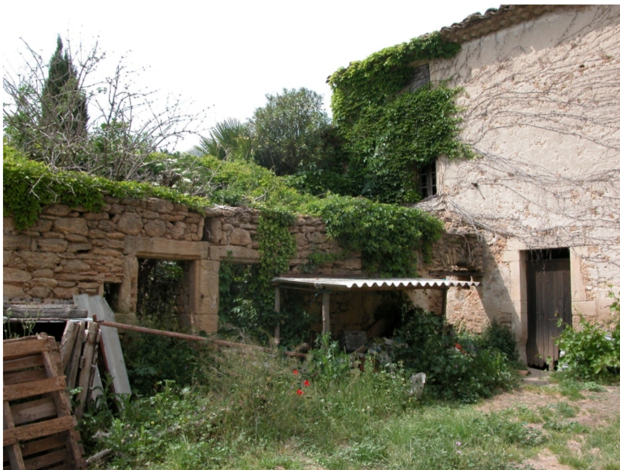
Vestiges de petites dépendances de la ferme : porcherie et poulailler, sur le côté ouest de la cour.
