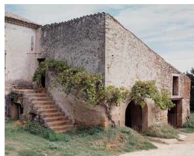
Vue depuis le sud-ouest de la dépendance accolée au logis. Phot. Alain Franchella IVR82_19972600351XA
