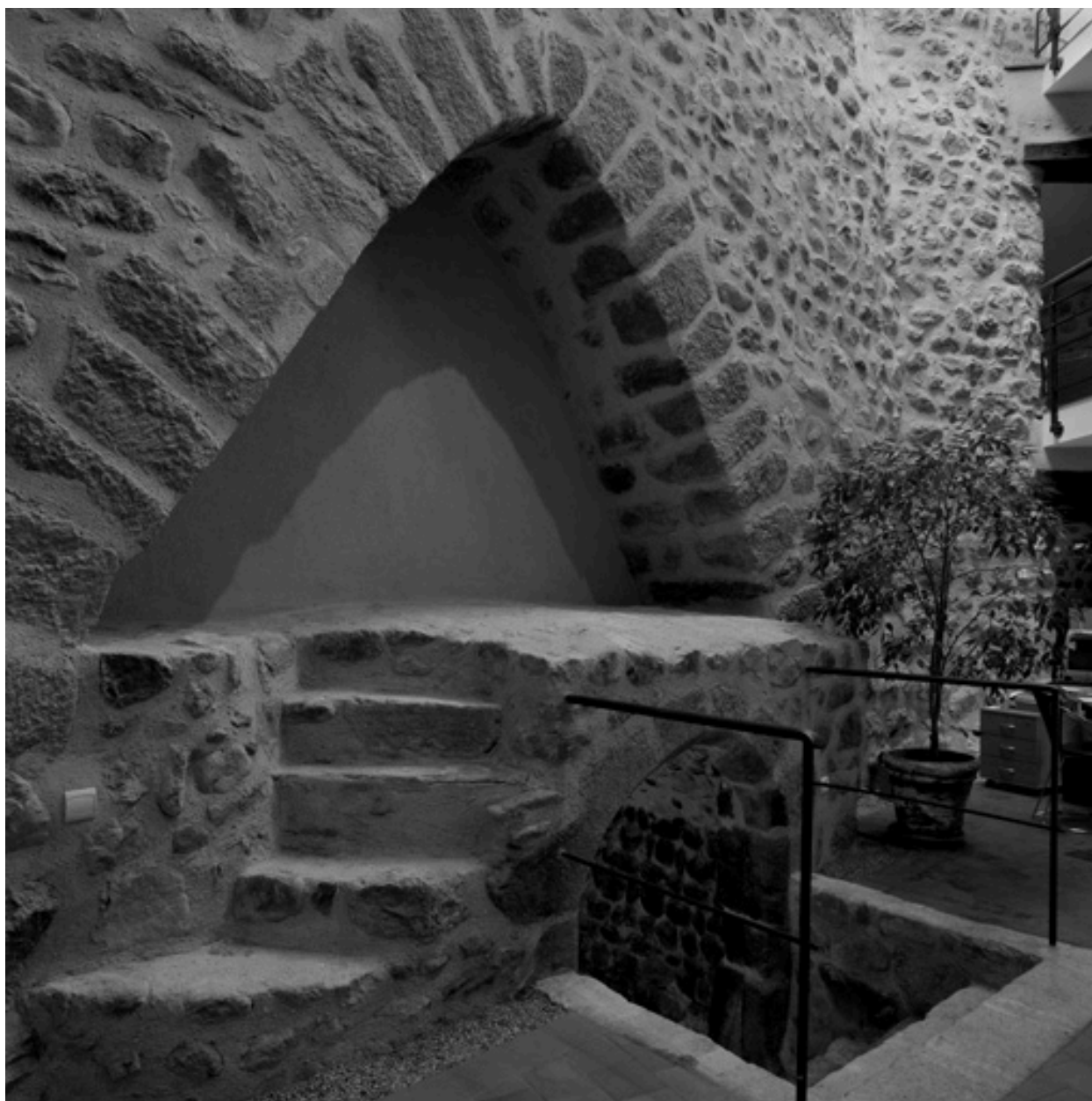
Vue intérieure du rez-de-chaussée du bâtiment adjacent à la tour : arcade du mur d'enceinte, avec entrée d'une cave édifiée au-dessous.
