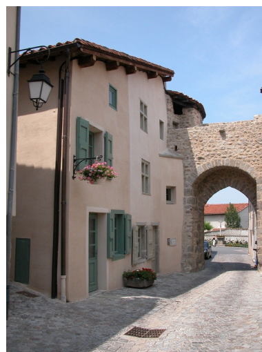
Vue générale depuis le sud (état en 2006). Phot. Thierry Monnet IVR82_20134200992NUCA
