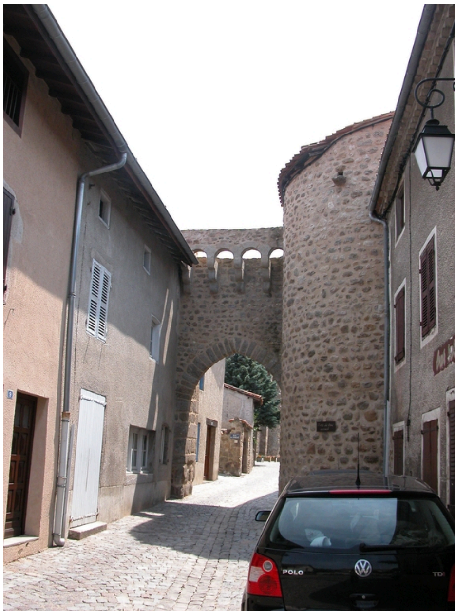
Vue générale depuis le nord (état en 2006).
