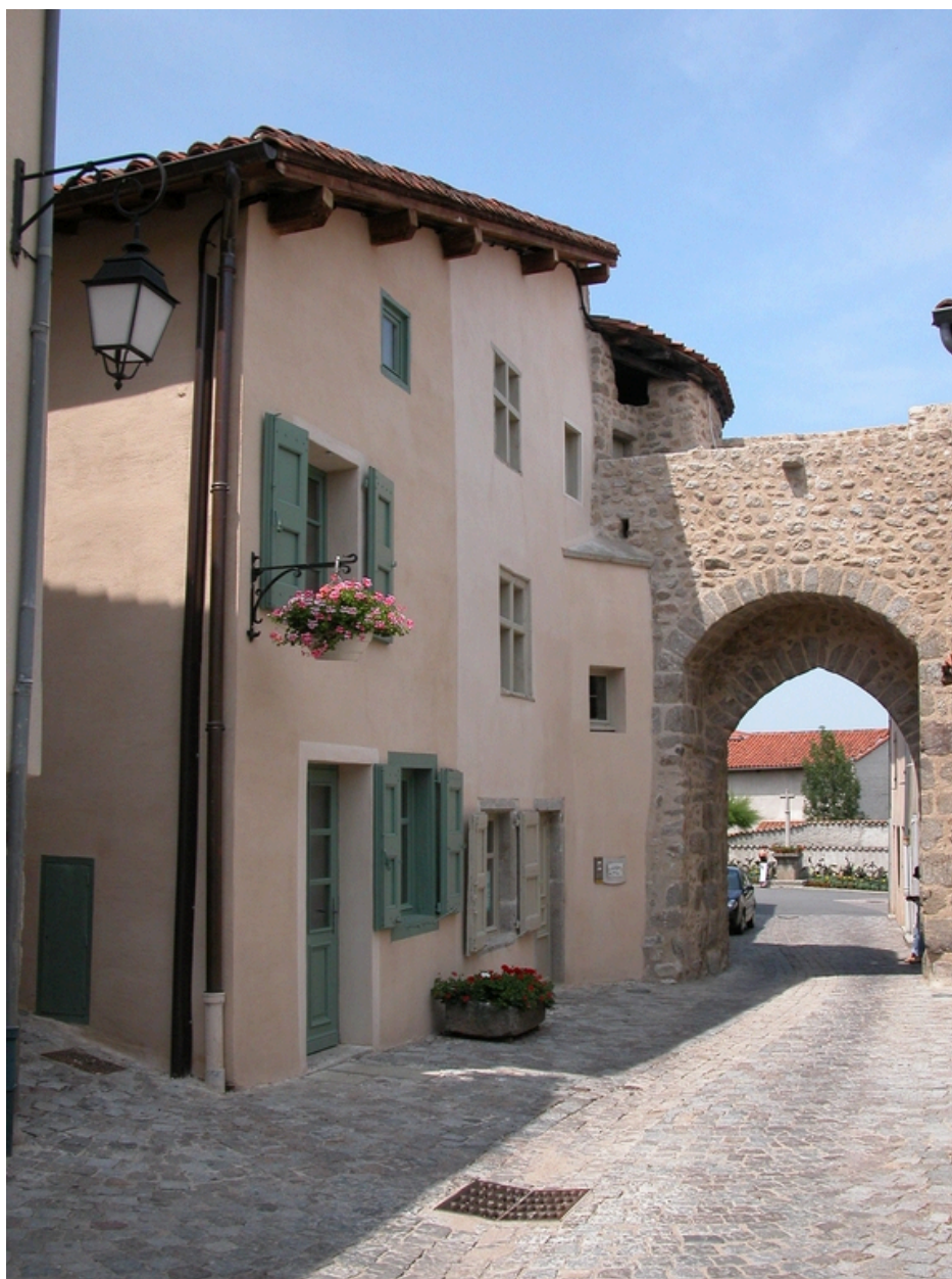
Vue générale depuis le sud (état en 2006).
