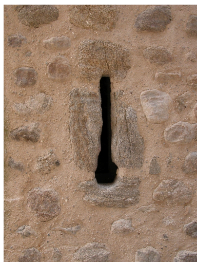
Détail d'une archère-canonnière. Phot. Thierry Monnet IVR82_20134200991NUCA
