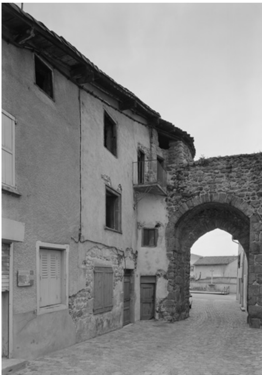
Vue générale depuis le sud (état en 2003).
