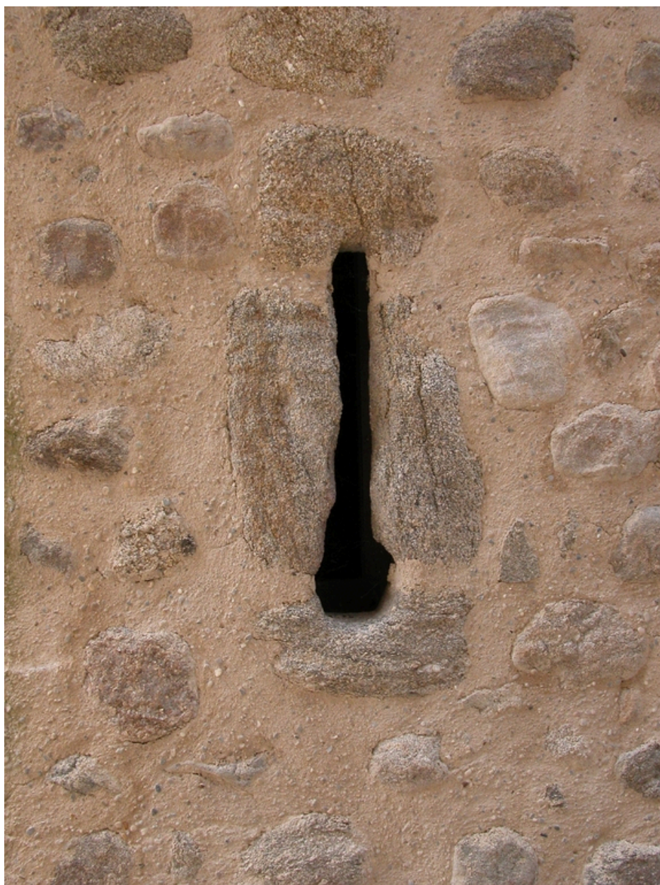
Détail d'une archère-canonnière.
