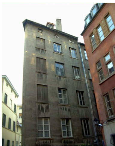
Elévation rue Ferrachat, vue des étages supérieurs Phot. Maryannick Chalabi IVR82_20006900171NUCA
