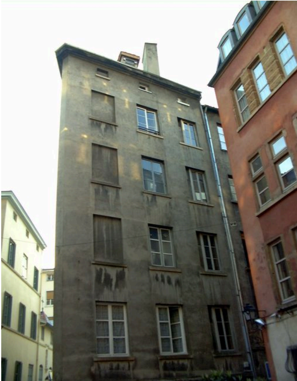
Elévation rue Ferrachat, vue des étages supérieurs
