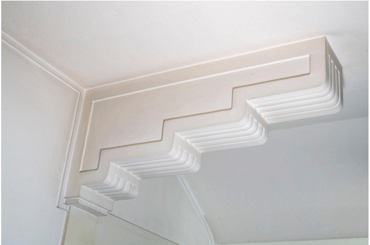
Rez-de-chaussée, cage de l'escalier sud : console moulurée
