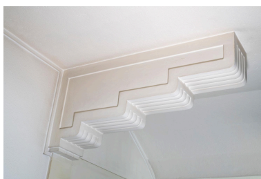
Rez-de-chaussée, cage de l'escalier sud : console moulurée Phot. Michel Pérès IVR84_20216900181NUCA
