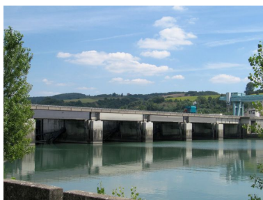
Vue générale du barrage et du pont routier, face aval (depuis la rive droite) Phot. I. Havard IVR82_20103800046NUCA
