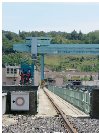
Passerelle, vue partielle : chaussée (depuis la rive droite) Phot. I. Havard IVR82_20103800045NUCA
