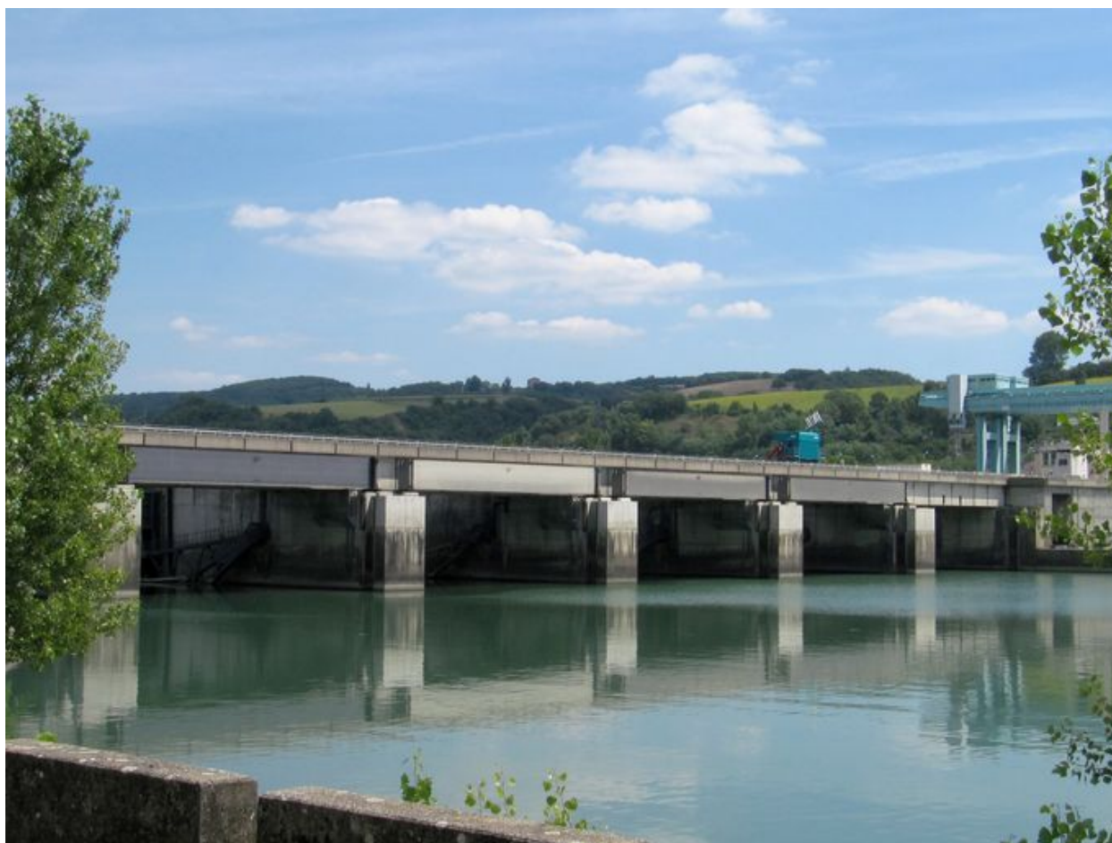
Vue générale du barrage et du pont routier, face aval (depuis la rive droite)
