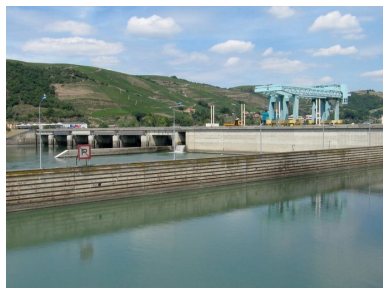
Vue générale avec l'écluse au premier plan, face aval (depuis la rive gauche)
