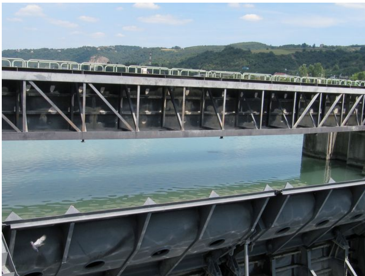
Passerelle, vue partielle : face aval
