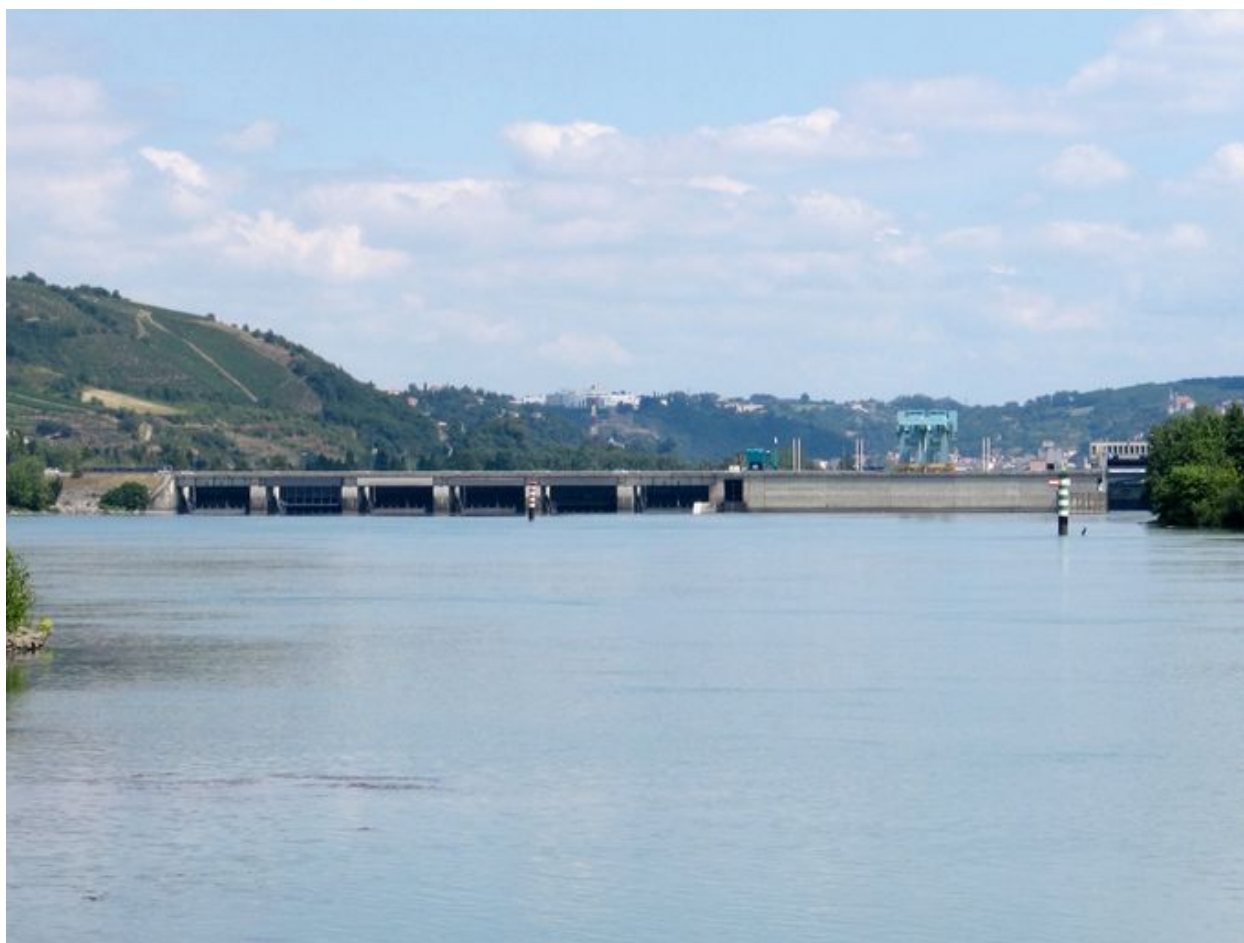
Vue générale, face aval (depuis le port d'Ampuis)
