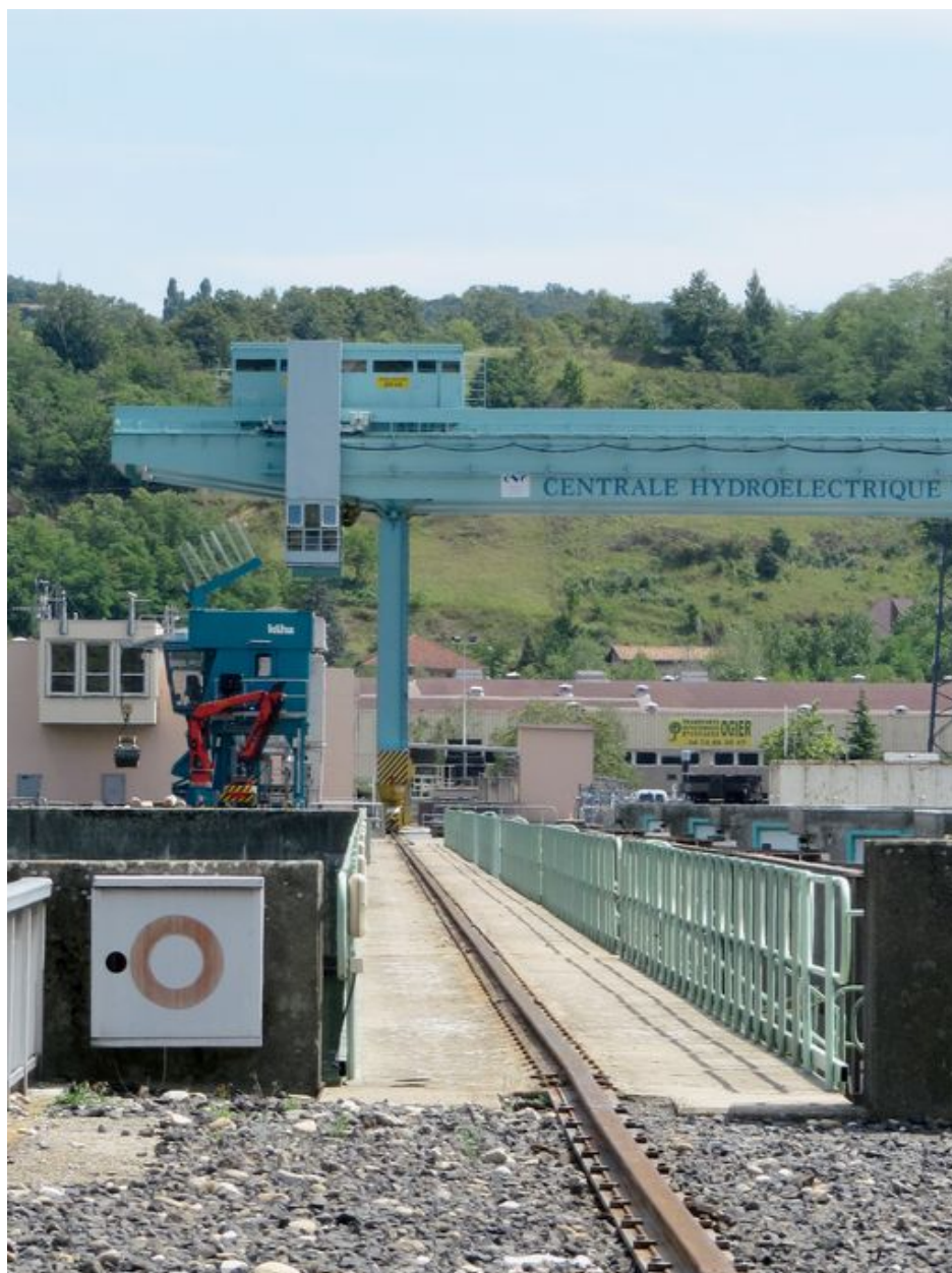
Passerelle, vue partielle : chaussée (depuis la rive droite)
