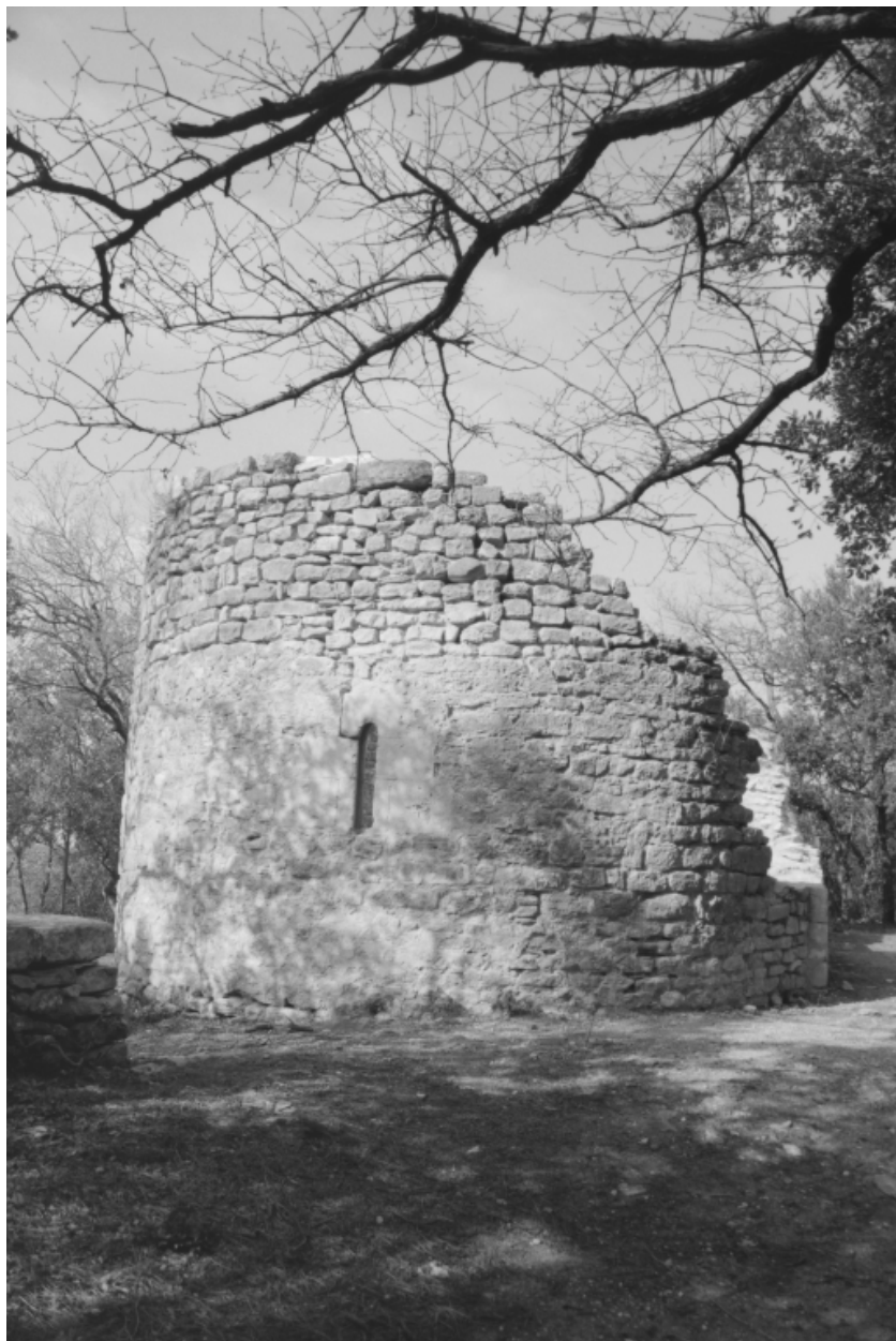
Vue d'ensemble du chevet, prise de l'est.
