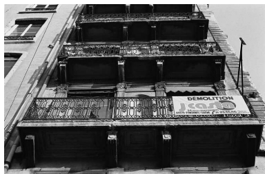
Façade sur le quai, balcons des niveaux 3 à 5 Phot. Jean-Marie Refflé IVR82_19796900055Z
