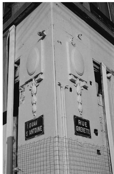
Devanture de boutique du rez- de-chaussée, détail du décor à l'angle du quai et de la rue Grenette Phot. Jean-Marie Refflé IVR82_19796900056Z
