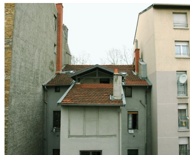
Haut de la cage d'escalier en pan de bois, vue depuis la cage d'escalier de l'immeuble en fond de cour à l'est Phot. Maryannick Chalabi IVR82_20066901387NUCA
