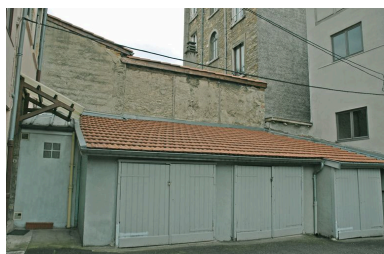
Garages situés le fond du côté sud de la cour, vue depuis l'angle nord-est Phot. Maryannick Chalabi IVR82_20066901386NUCA
