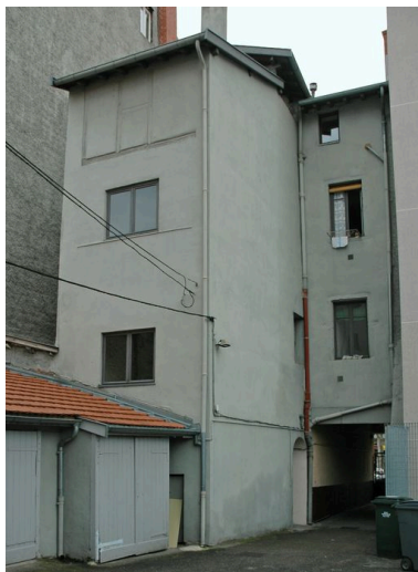
Façade est sur cour avec la cage d'escalier depuis le nord-est de la cour Phot. Maryannick Chalabi IVR82_20066901388NUCA
