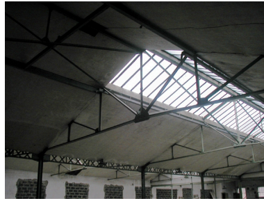
Détail lanterneau Phot. Catherine Bouffière IVR82_20036901964NUCA
