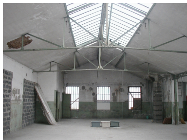
Charpente second niveau Phot. Catherine Bouffière IVR82_20036901972NUCA
