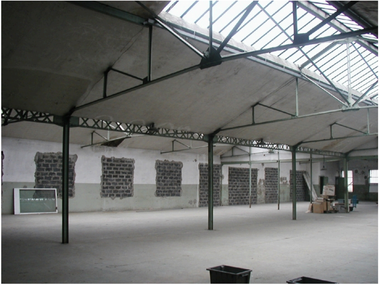
Vue d'ensemble du second niveau
