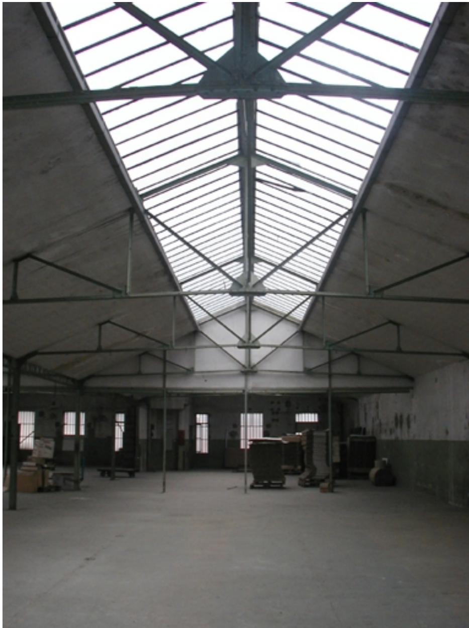
Eclairage zénithal : lanterneau sur le faitage
