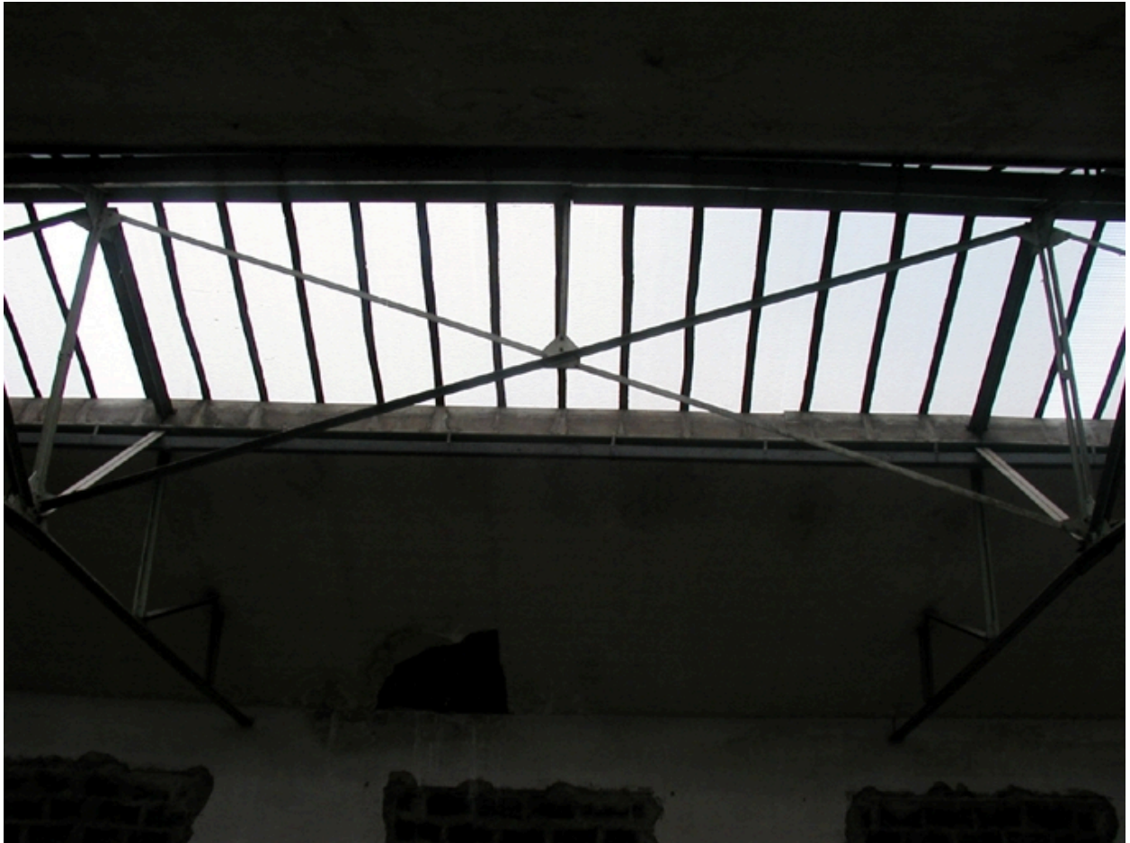
Lanterneau, second niveau
