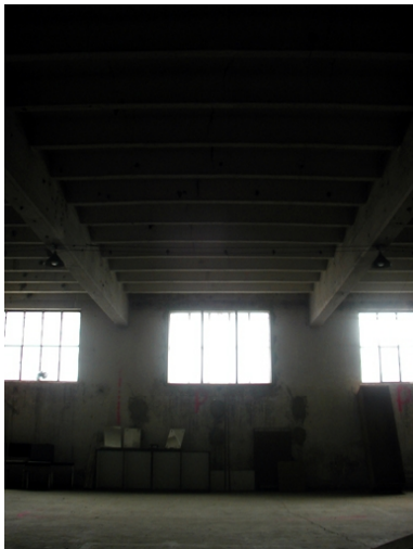
Vue du premier niveau Phot. Catherine Bouffière IVR82_20036901969NUCA
