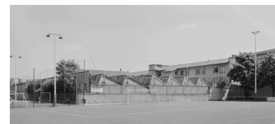
Vue arrière du site, partie ateliers en rez-de-chaussée Phot. Didier Gourbin IVR82_20066900089X
