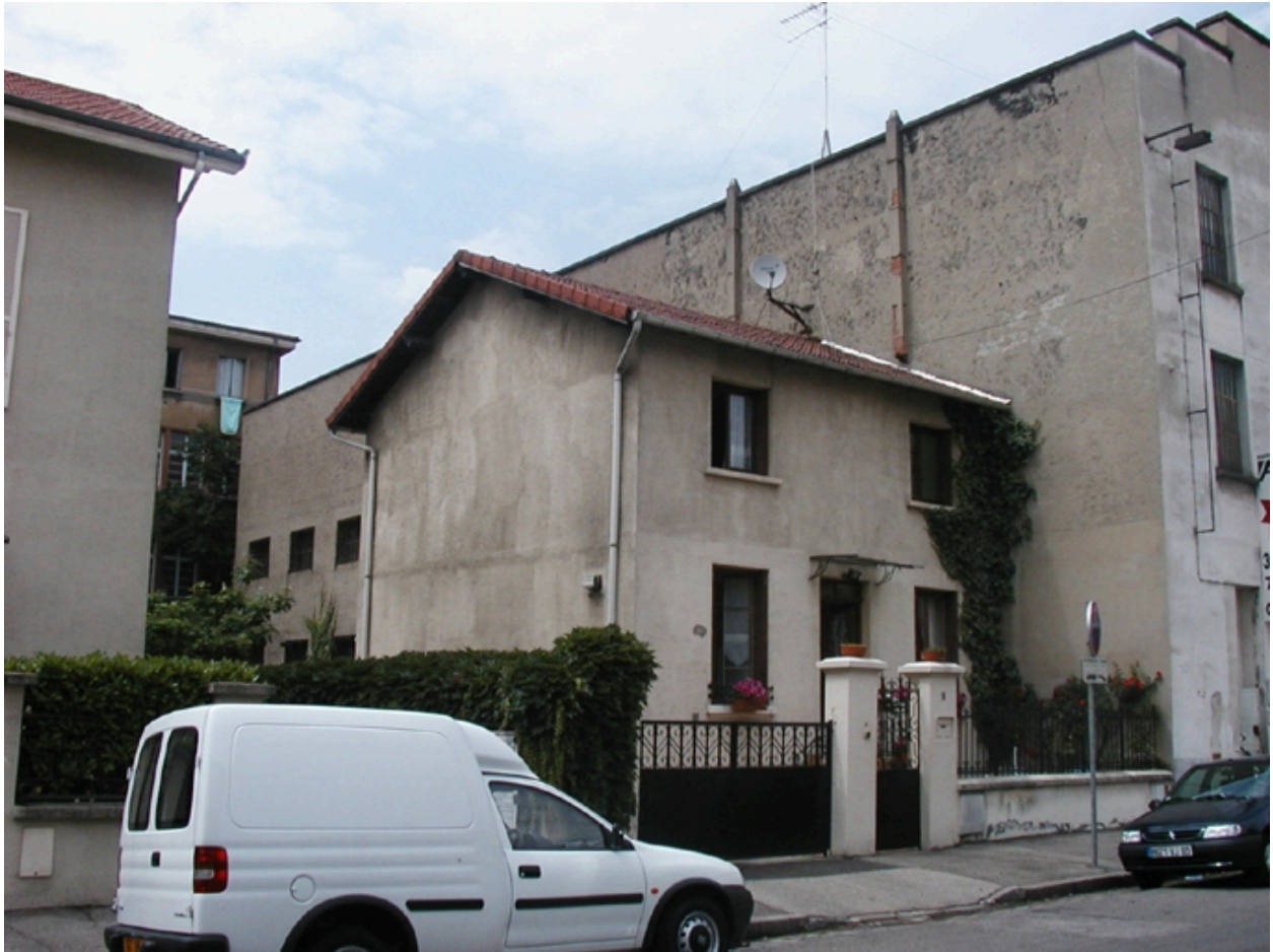
Vue sud, maison accolée
