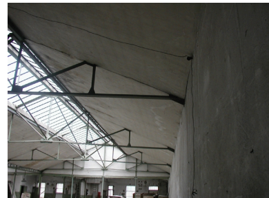
Détail charpente Phot. Catherine Bouffière IVR82_20036901968NUCA
