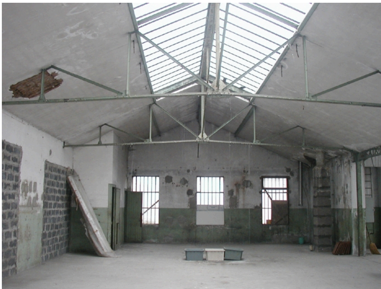
Charpente second niveau
