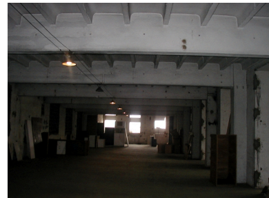
Vue du premier niveau, détail poutrelles béton Phot. Catherine Bouffière IVR82_20036901971NUCA
