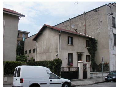
Vue sud, maison accolée Phot. Catherine Bouffière IVR82_20036901961NUCA
