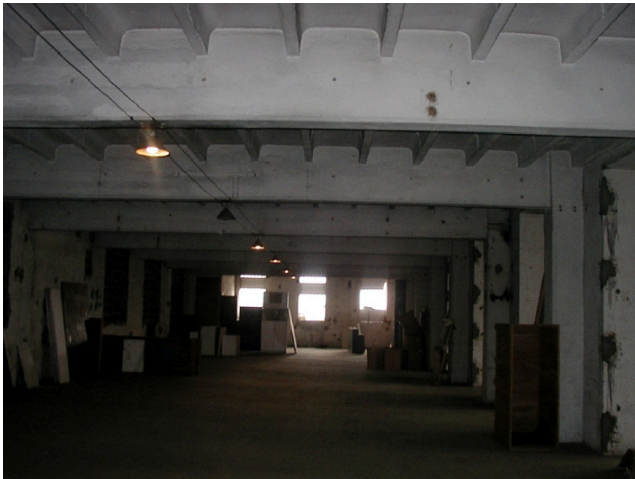
Vue du premier niveau, détail poutrelles béton
