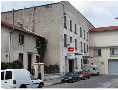
Vue sud-est Phot. Catherine Bouffière IVR82_20036901960NUCA
