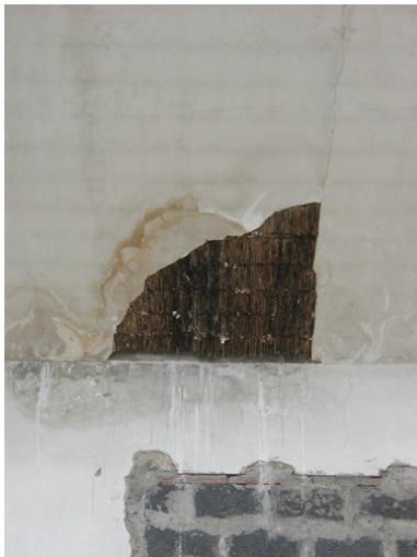
Détail matériel de construction Phot. Catherine Bouffière IVR82_20036901975NUCA
