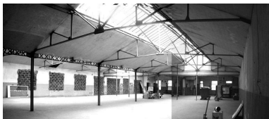
Vue d'ensemble du second niveau (montage photo) Phot. Catherine Bouffière IVR82_20036901966NUCA
