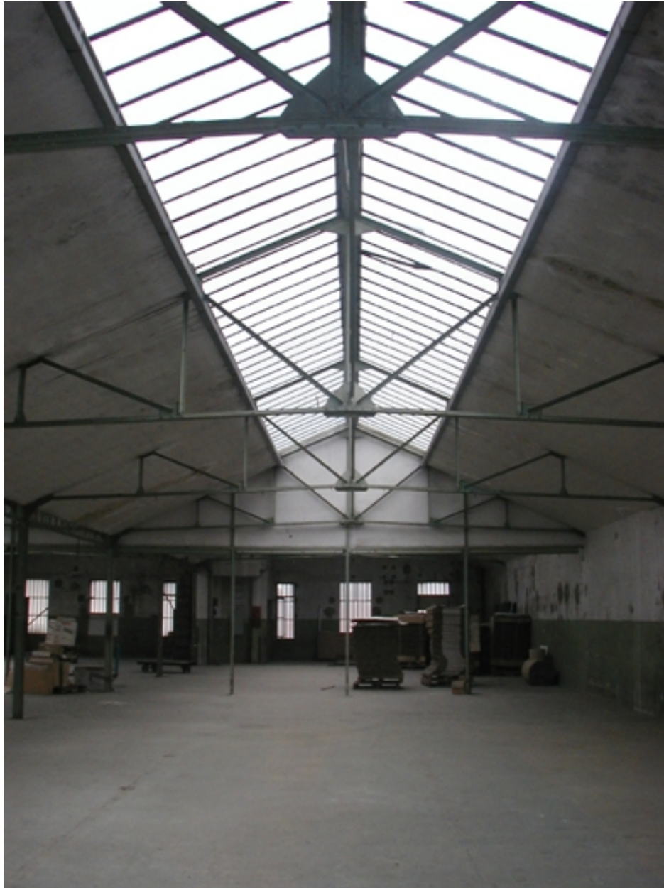
Eclairage zénithal : lanterneau sur le faitage
