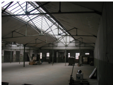
Vue d'ensemble second niveau (montage photo) Phot. Catherine Bouffière IVR82_20036901967NUCA
