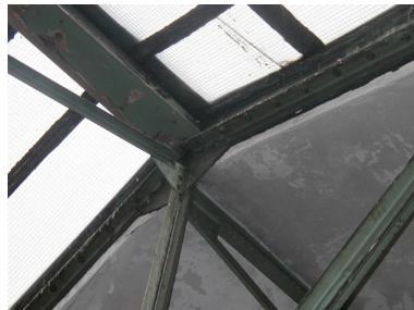
Détail faîtage Phot. Catherine Bouffière IVR82_20036901976NUCA
