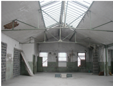
Charpente second niveau Phot. Catherine Bouffière IVR82_20036901972NUCA
