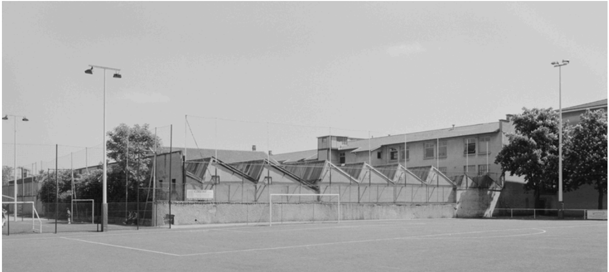
Vue arrière du site, partie ateliers en rez-de-chaussée
