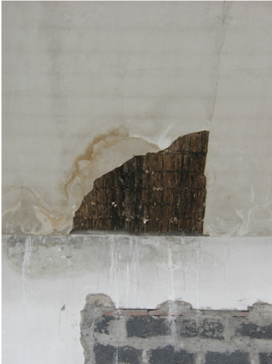
Détail matériel de construction
