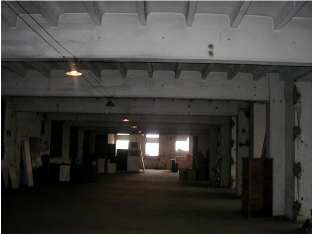
Vue du premier niveau, détail poutrelles béton
