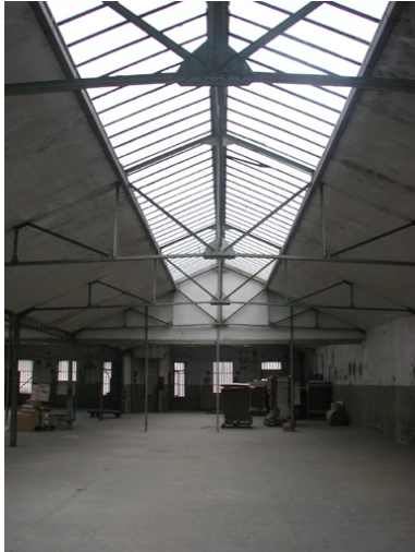
Eclairage zénithal : lanterneau sur le faîtage Phot. Catherine Bouffière IVR82_20036901963NUCA
