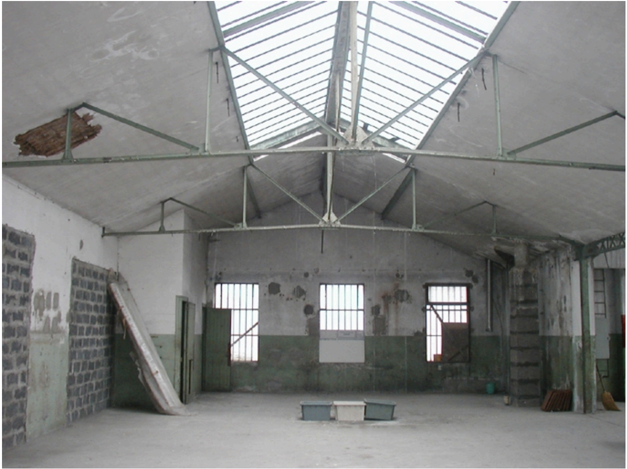
Charpente second niveau
