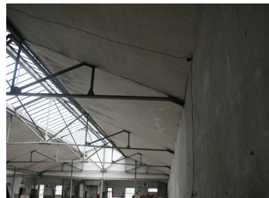
Détail charpente Phot. Catherine Bouffière IVR82_20036901968NUCA
