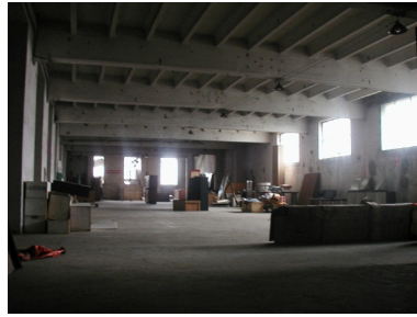
Vue d'ensemble du premier niveau Phot. Catherine Bouffière IVR82_20036901970NUCA
