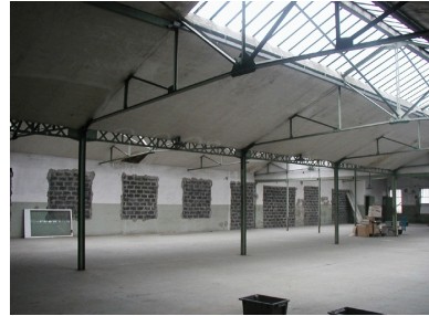
Vue d'ensemble du second niveau Phot. Catherine Bouffière IVR82_20036901965NUCA
