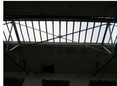
Lanterneau, second niveau Phot. Catherine Bouffière IVR82_20036901974NUCA
