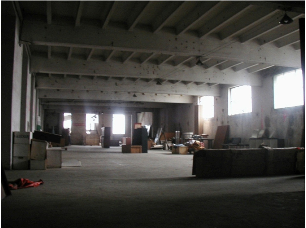
Vue d'ensemble du premier niveau
