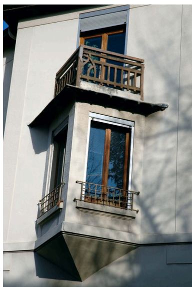
élévation sud : détail. Phot. Véronique Belle IVR82_20066900779NUCA
