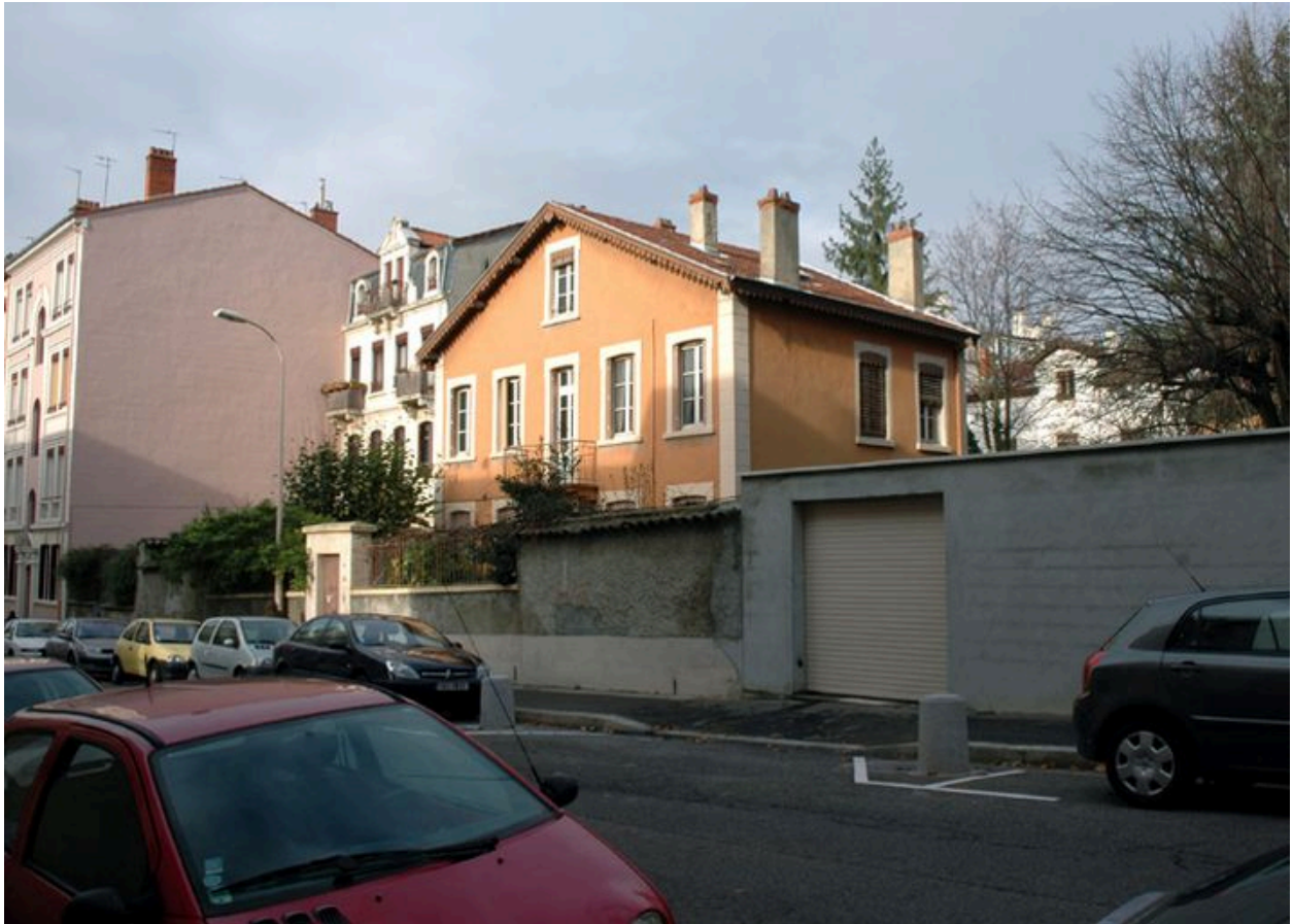
Bow-window et balcon, élévation sud
