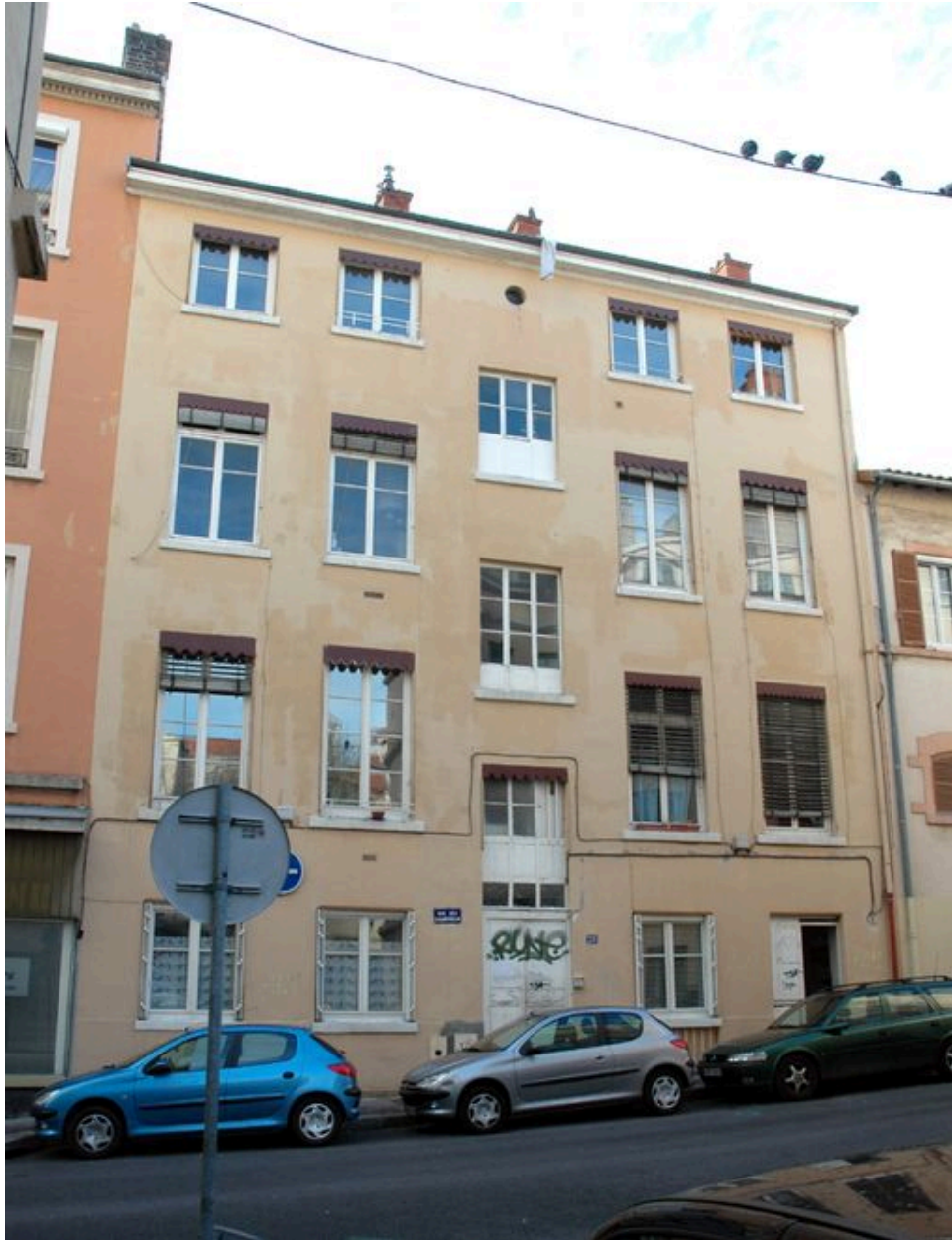
Vue de l'élévation sud
