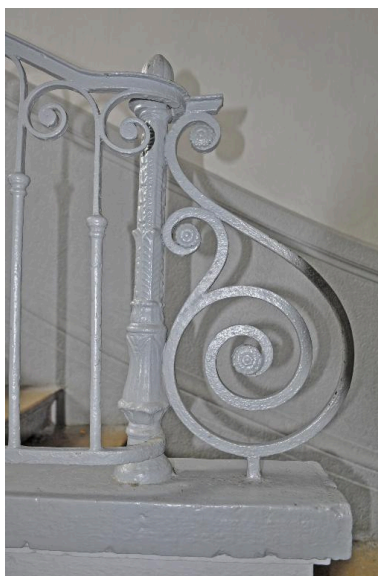
Détail du garde-corps de l'escalier Phot. Magali Delavenne IVR84_20166902232NUCA
