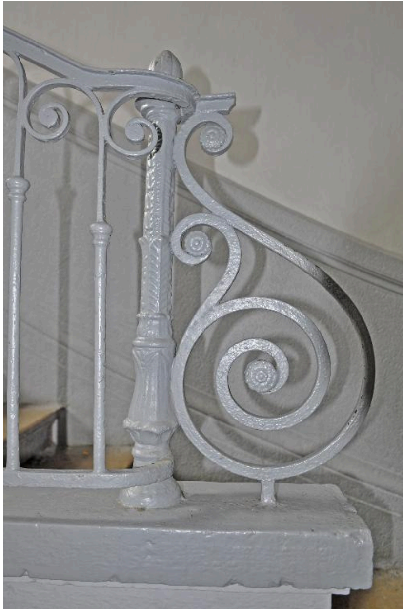
Détail du garde-corps de l'escalier
