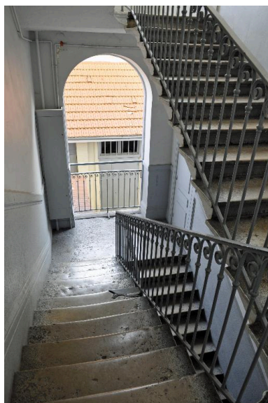
Vue intérieure : escalier à cage ouverte Phot. Magali Delavenne IVR84_20166902233NUCA
