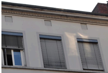
Elévation sur rue, détail du surcroît et corniche Phot. Magali Delavenne IVR84_20166902230NUCA
