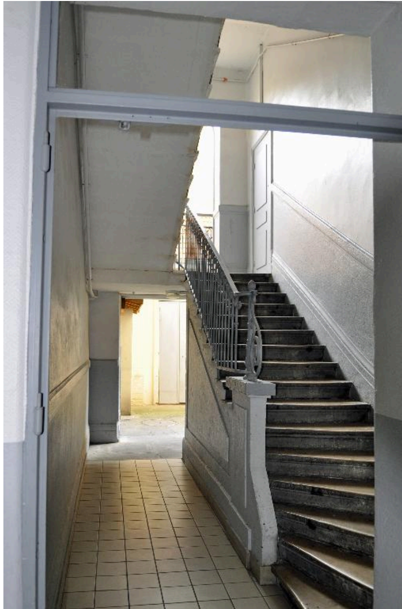
Vue intérieure : départ de l'escalier et accès à la cour
