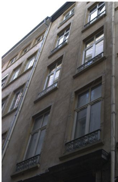
Façade sur rue, vue générale des étages Phot. Maryannick Chalabi IVR82_20036901009NUCA
