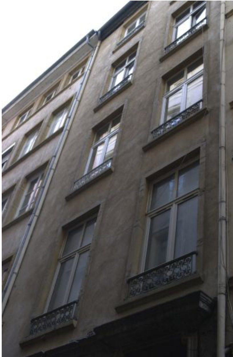
Façade sur rue, vue générale des étages
