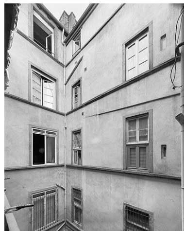
Cour, à gauche revers du bâtiment sur rue, à droite élévation du corps de liaison Phot. Didier Gourbin IVR82_20046905926V
