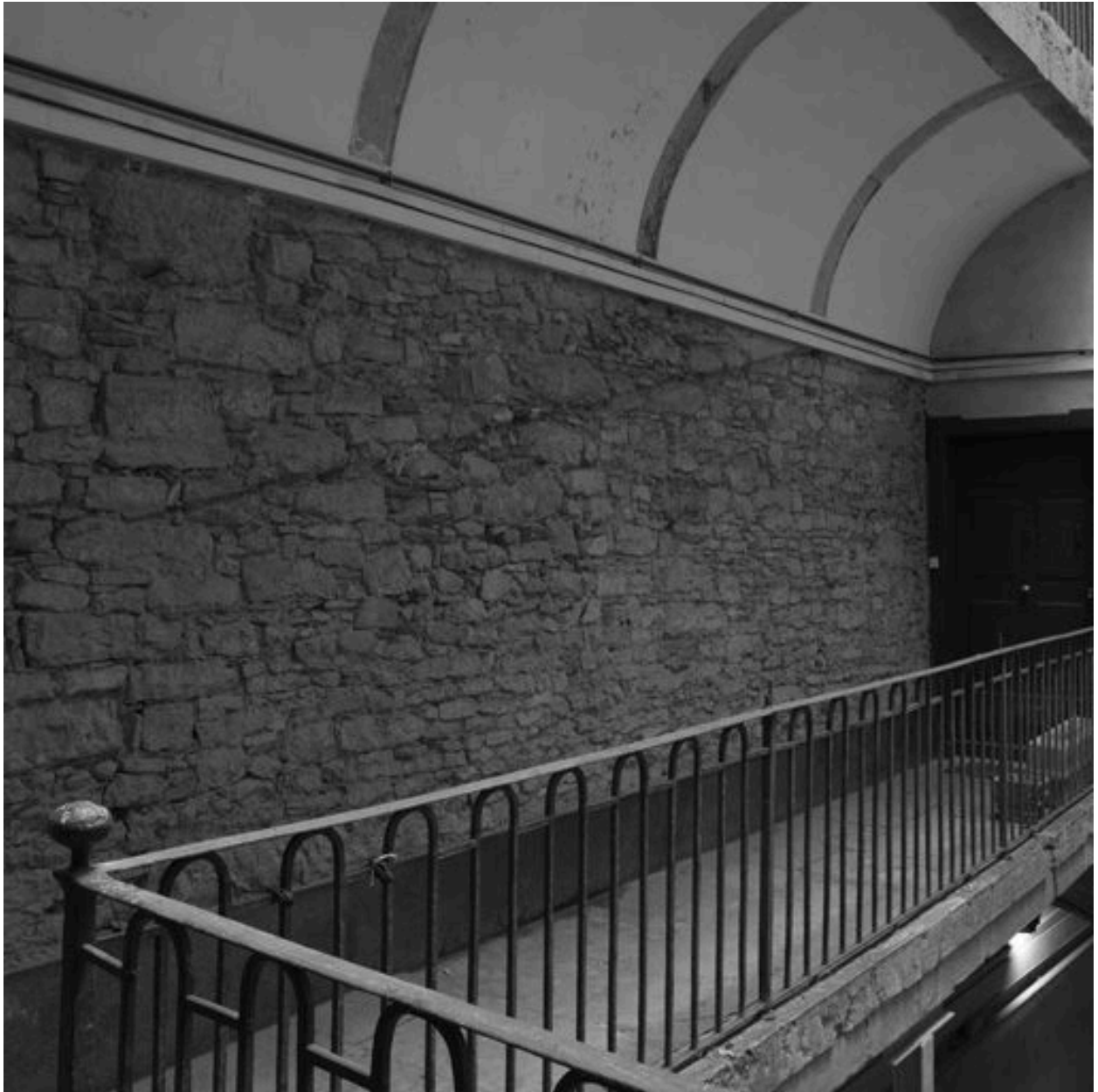
Coursière du 1er étage, vue en direction du 1er corps de bâtiment
