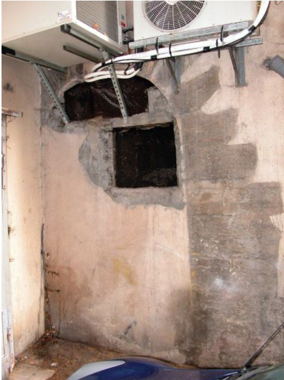
Façade impasse de la Pêcherie, détail de l'ancienne porte
