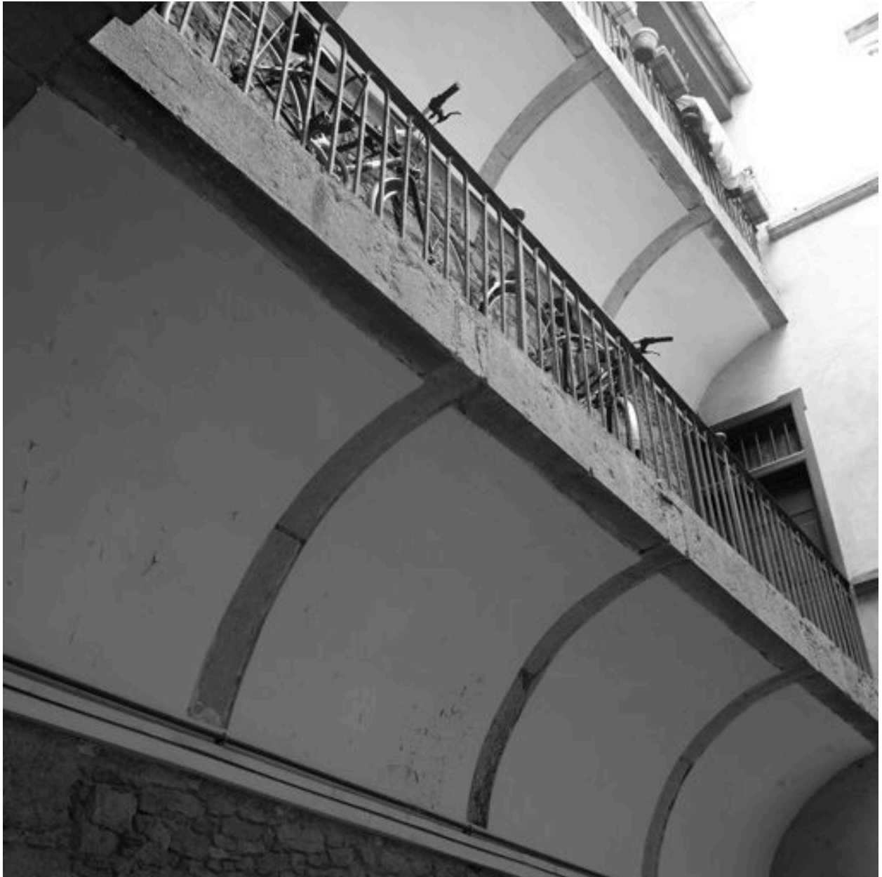
Vue par-dessous des voûtes supportant les coursières des 2e et 3e étages, prise en direction du 1er bâtiment
