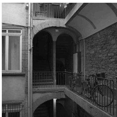
Escalier dans le corps arrière vu depuis la coursière du 2e étage Phot. Didier Gourbin
