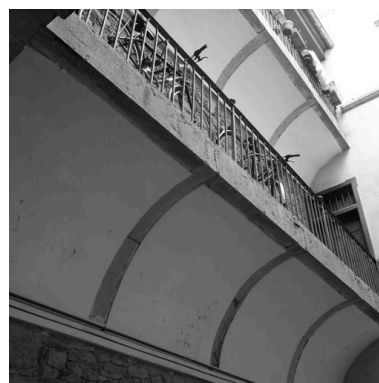
Vue par-dessous des voûtes supportant les coursières
