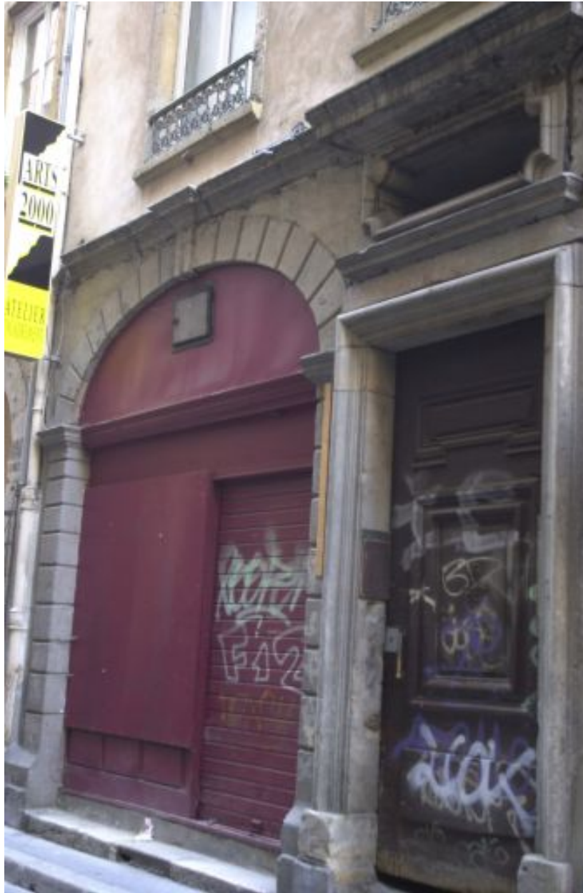
Façade sur rue, rez-de-chaussée
