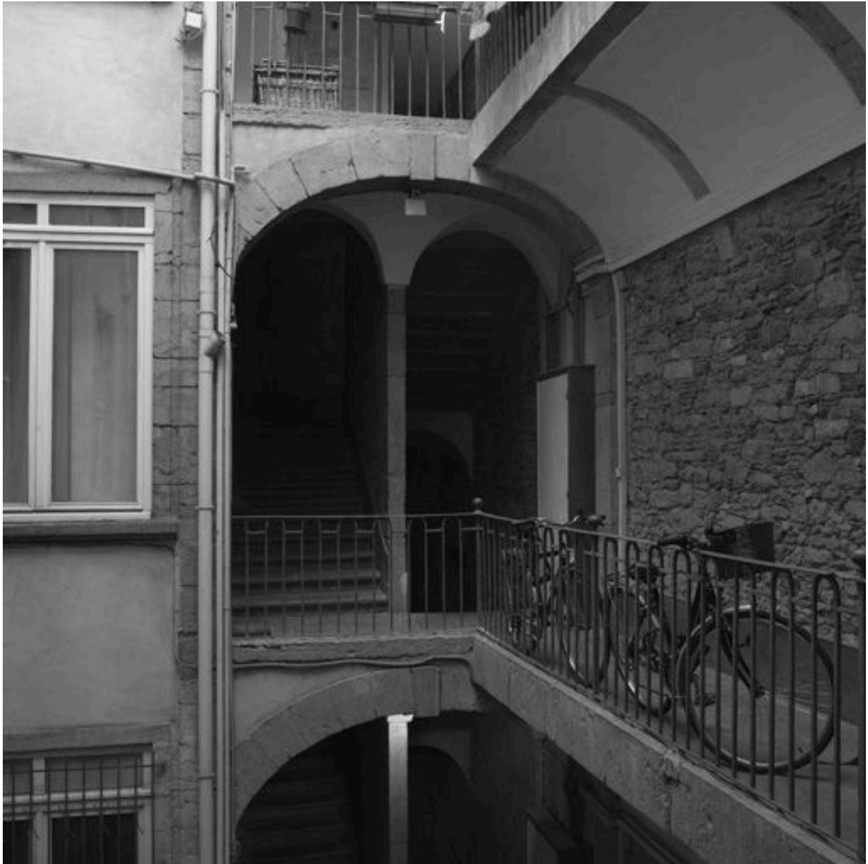
Escalier dans le corps arrière vu depuis la coursière du 2e étage
