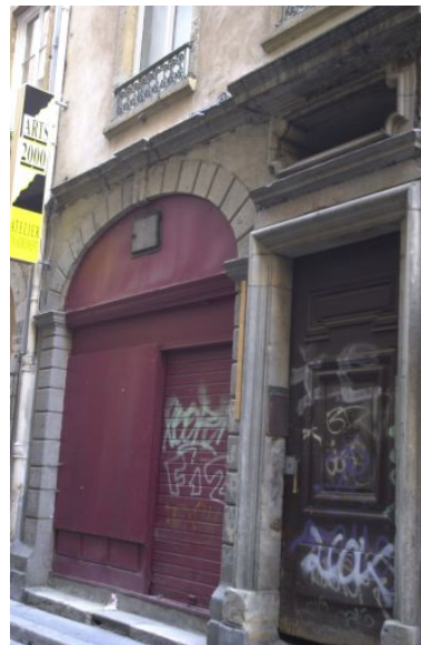
Façade sur rue, rez-de-chaussée Phot. Maryannick Chalabi IVR82_20036901010NUCA
