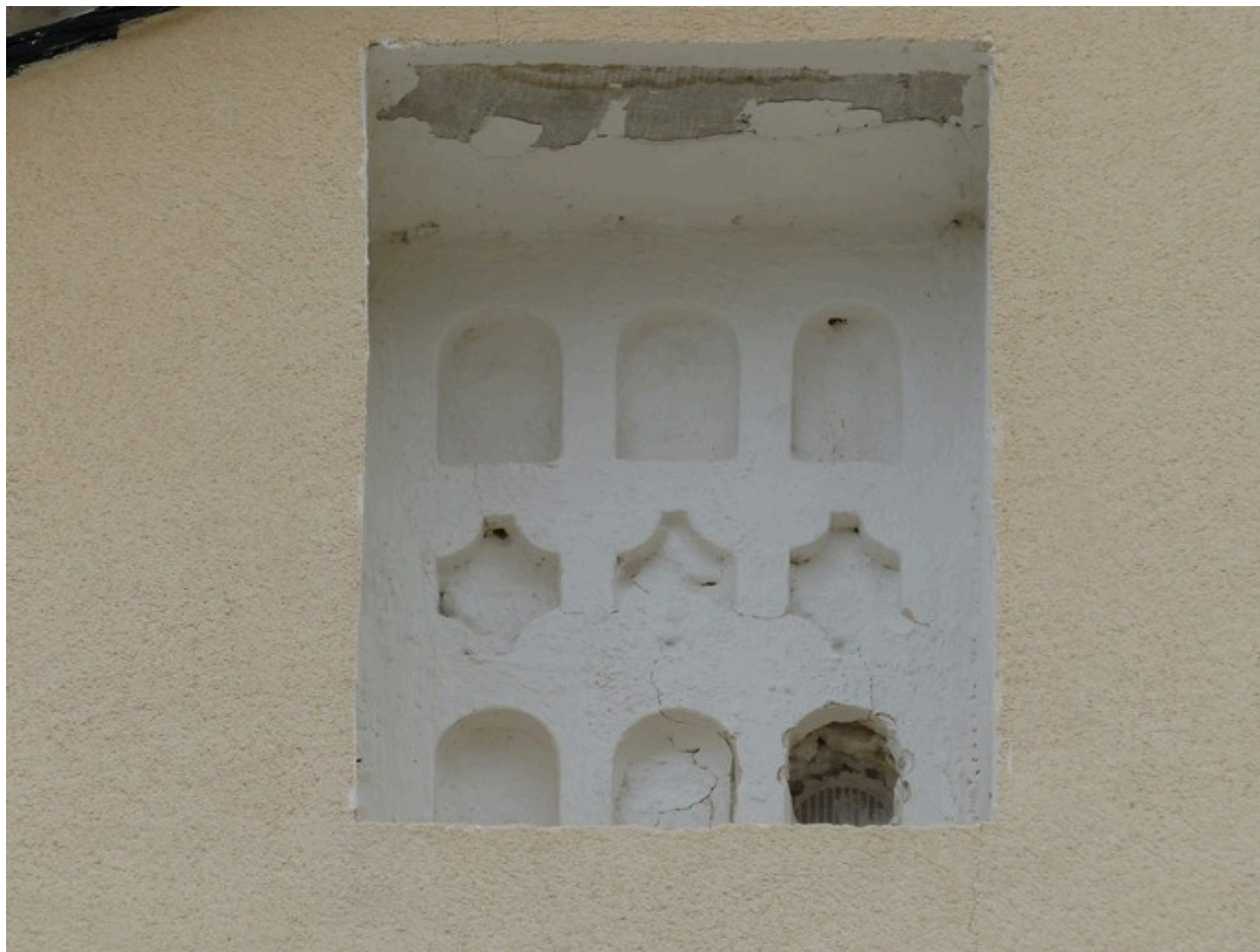
Pignon sud, baie du pigeonnier.
