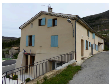
Vue d'ensemble prise du sud-est. Phot. Alexeï Laurent IVR84_20162600295NUCA
