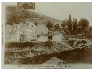
Vue partielle de la mairie, dans les années 1910. Vue prise du sud-ouest (carte postale, 1er quart 20e siècle). Phot. Alexeï Laurent, Autr. Marius Lesbros IVR84_20162600297NUCAB
