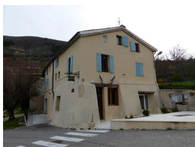
Vue d'ensemble prise du sud-ouest. Phot. Alexeï Laurent IVR84_20162600293NUCA
