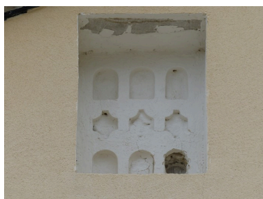
Pignon sud, baie du pigeonnier. Phot. Alexeï Laurent IVR84_20162600296NUCA
