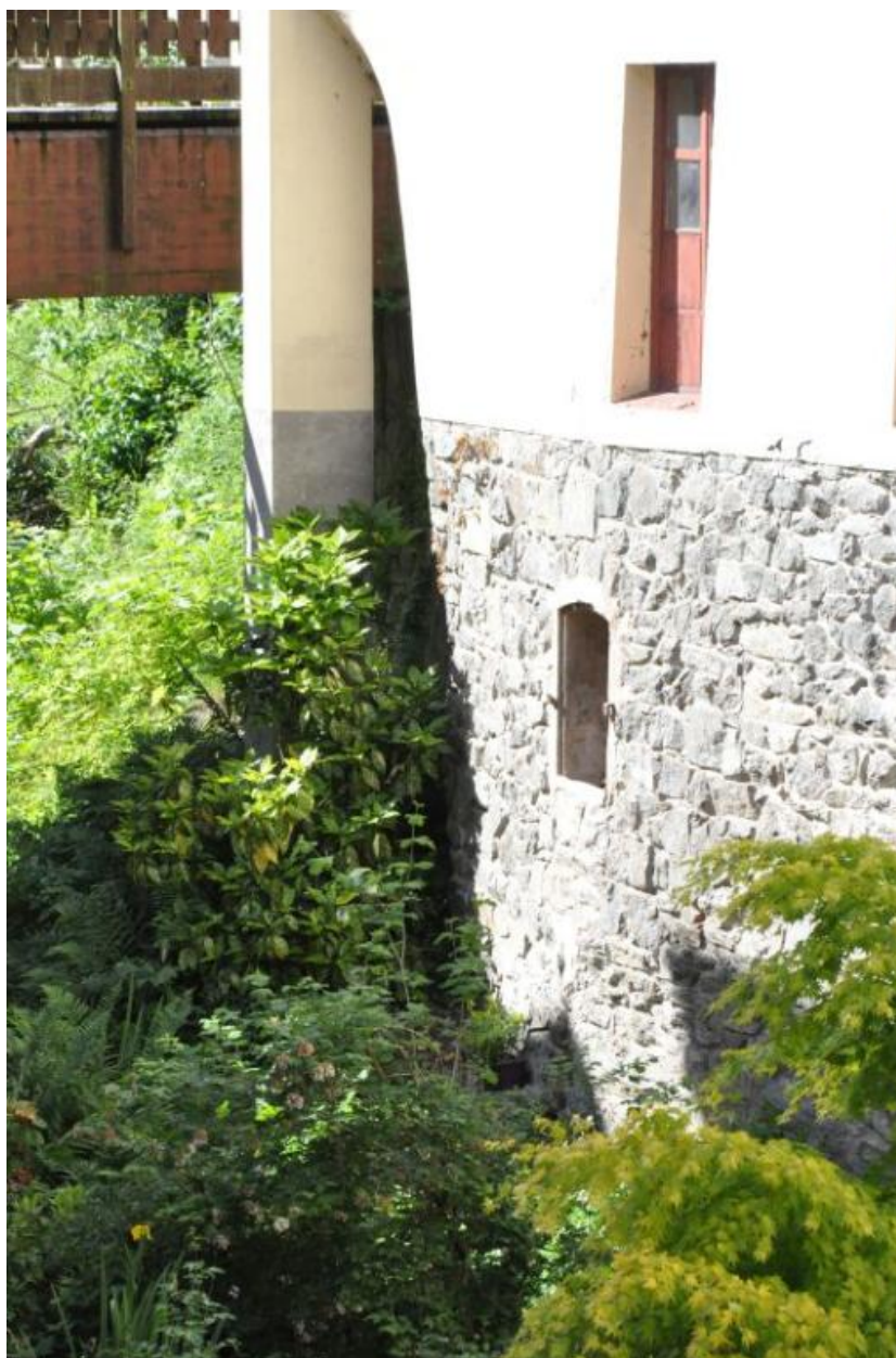
Détail de l'un des murs de maisons sous laquelle passe la bidière.
