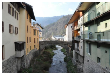
Vue de l'ancien pont de Beaufort franchissant le Doron. A gauche, des bâtiments sous lesquels passe la bidière. Phot. Odile Gaboriau IVR84_20187300080NUCA
