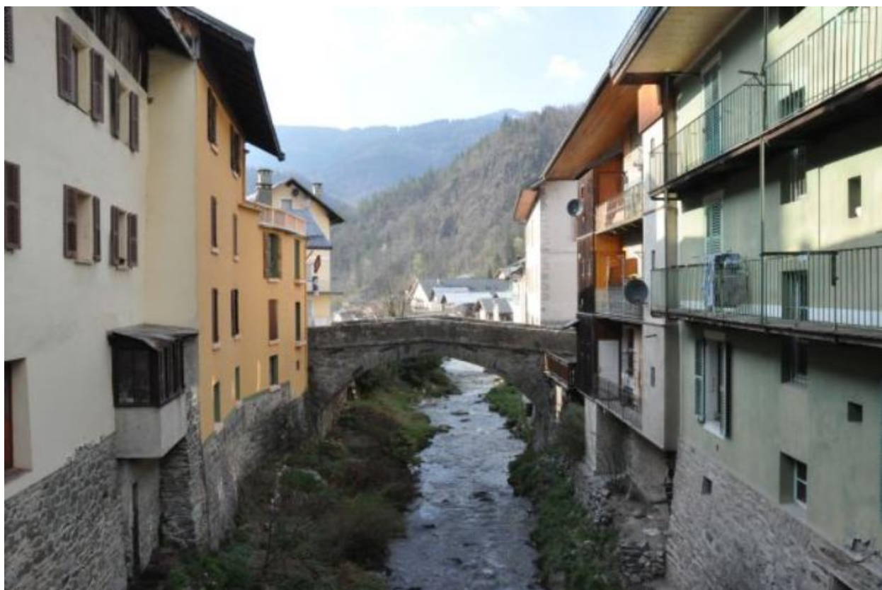
Vue de l'ancien pont de Beaufort franchissant le Doron. A gauche, des bâtiments sous lesquels passe la bidière.
