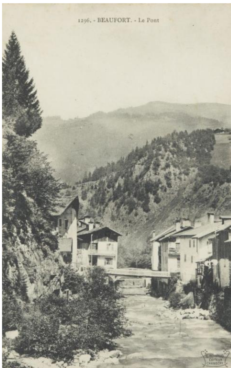
Vue de l'emplacement où se trouvait la prise d'eau de la bidière.
