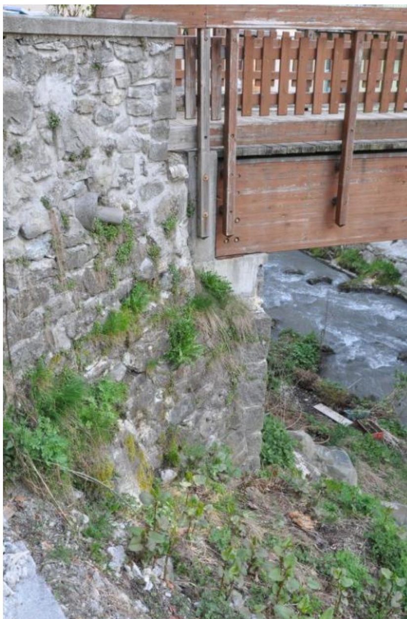
Détail de l'emplacement où se trouvait la prise d'eau de la bidière.
