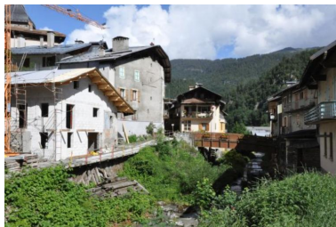
Vue de l'emplacement où se trouvait la prise d'eau de la bidière. Phot. Odile Gaboriau IVR84_20187300078NUCA
