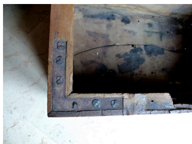
Détail de l'assemblage. Phot. Alexeï Laurent IVR84_20162601100NUCA
