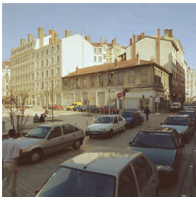
Vue générale Phot. Didier Gourbin IVR82_20086901452XE
