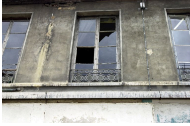
Détail d'une fenêtre et de son garde-corps Phot. Bernard Ducouret IVR82_20046902098NUCA
