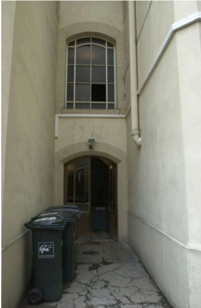
Elévation postérieure, rez-de-chaussée de la cage d'escalier
