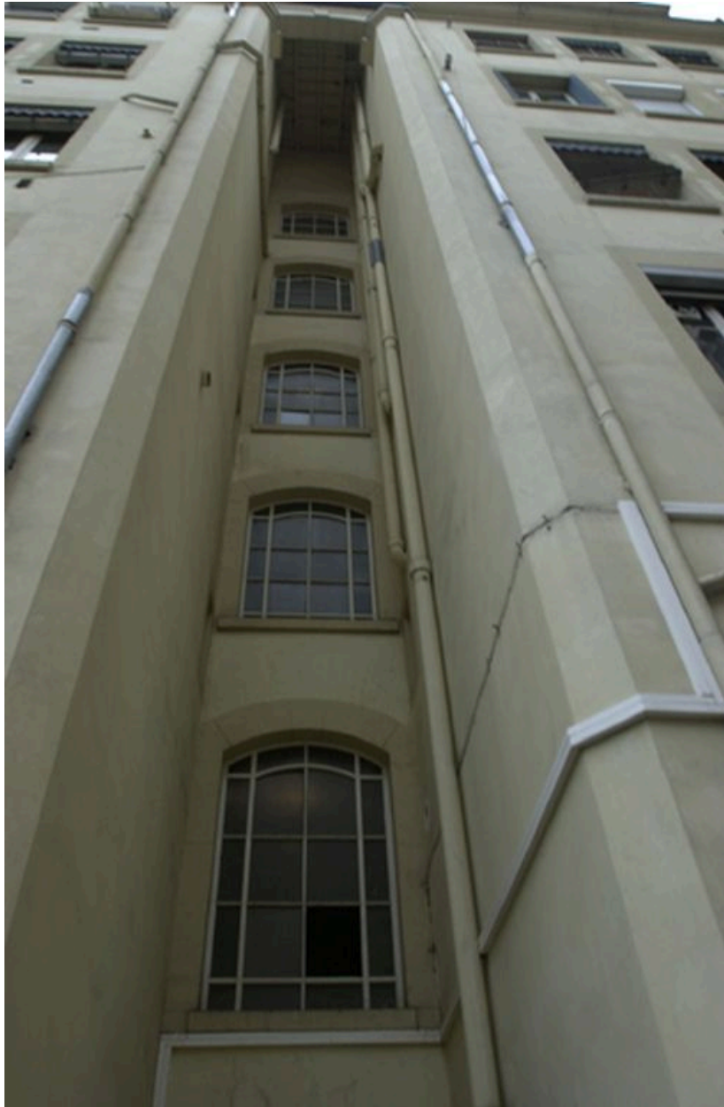
Elévation postérieure, étage de la cage d'escalier
