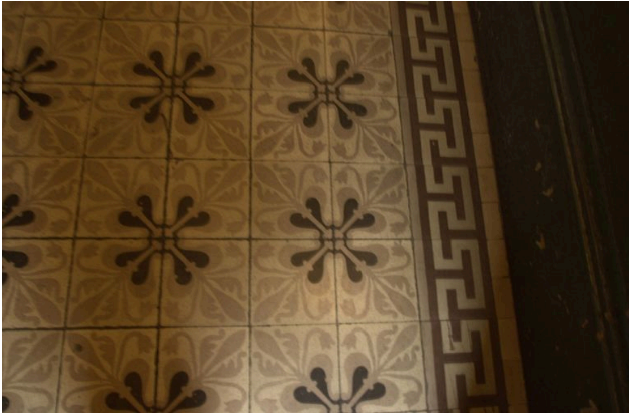
Carrelage du vestibule
