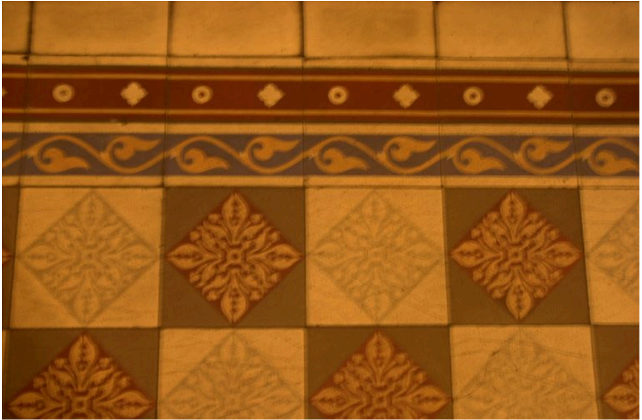
Carrelage du vestibule, cage d'escalier
