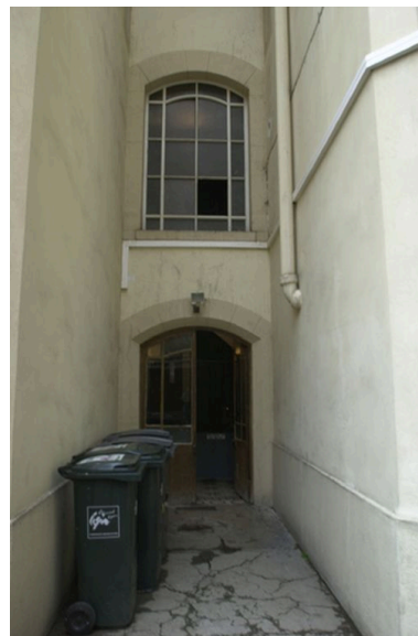
Elévation postérieure, rez-de-chaussée de la cage d'escalier Phot. Maryannick Chalabi IVR82_20046904351NUCA
