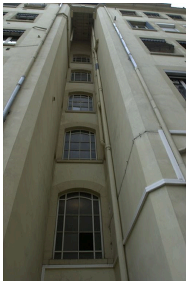
Elévation postérieure, étage de la cage d'escalier Phot. Maryannick Chalabi IVR82_20046904352NUCA
