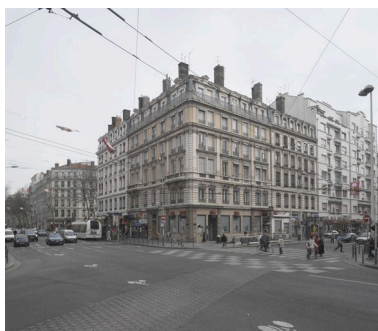
Vue générale depuis le nord-ouest Phot. Eric Dessert IVR82_20056900598NUCA
