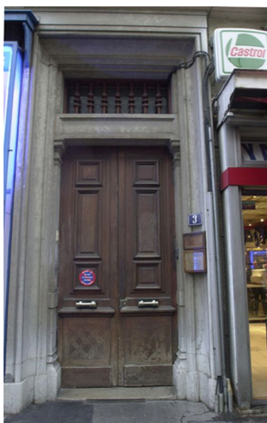
Porte d'entrée Phot. Maryannick Chalabi IVR82_20046904347NUCA
