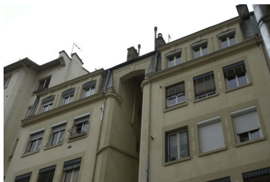
Elévation postérieure vue des étages supérieurs du 56, cours Gambetta Phot. Maryannick Chalabi IVR82_20046904355NUCA
