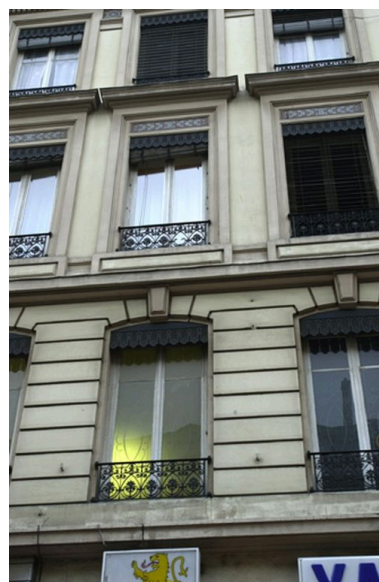
Détail du décor (fenêtres à carreaux de verre gravée, céramique) Phot. Maryannick Chalabi IVR82_20046904346NUCA
