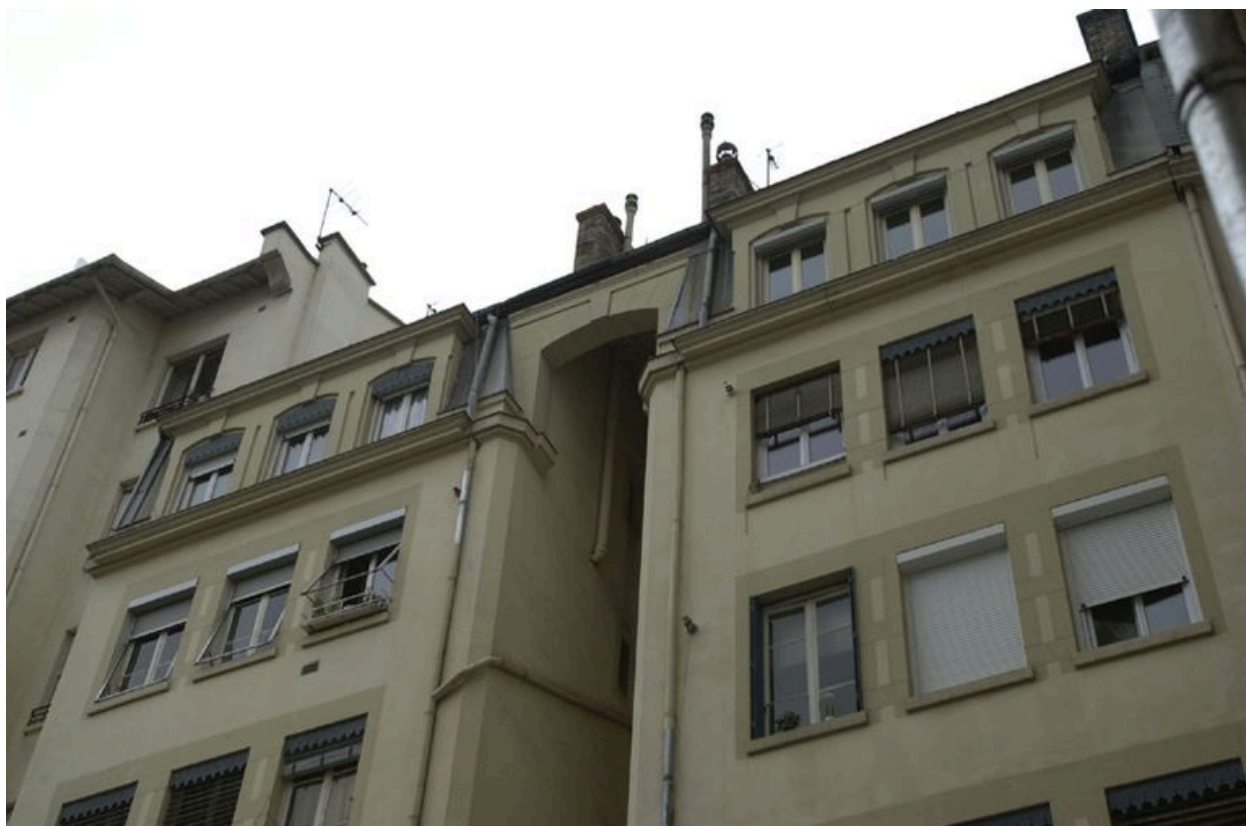
Elévation postérieure vue des étages supérieurs du 56, cours Gambetta
