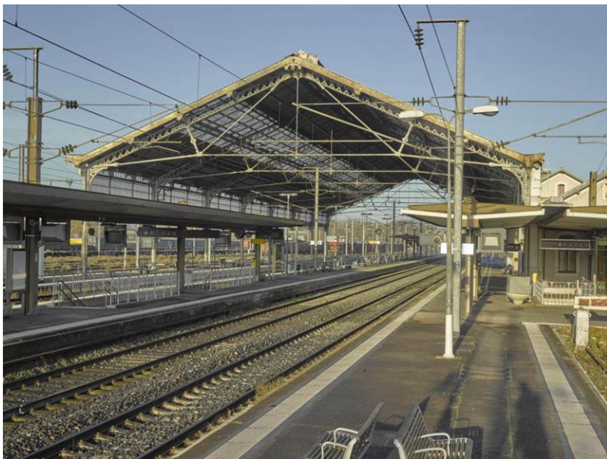
La grande halle à structure métallique (fermes de type "Polonceau") et ses verrières, protégeant les voies et les quais en gare de Saint-Germain-des-Fossés.
