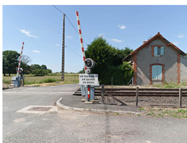
Maison de garde-barrière, au passage à niveau entre les Bruyères et les Nautes. Phot. Jean-Michel Périn IVR83_20150300020NUC4A
