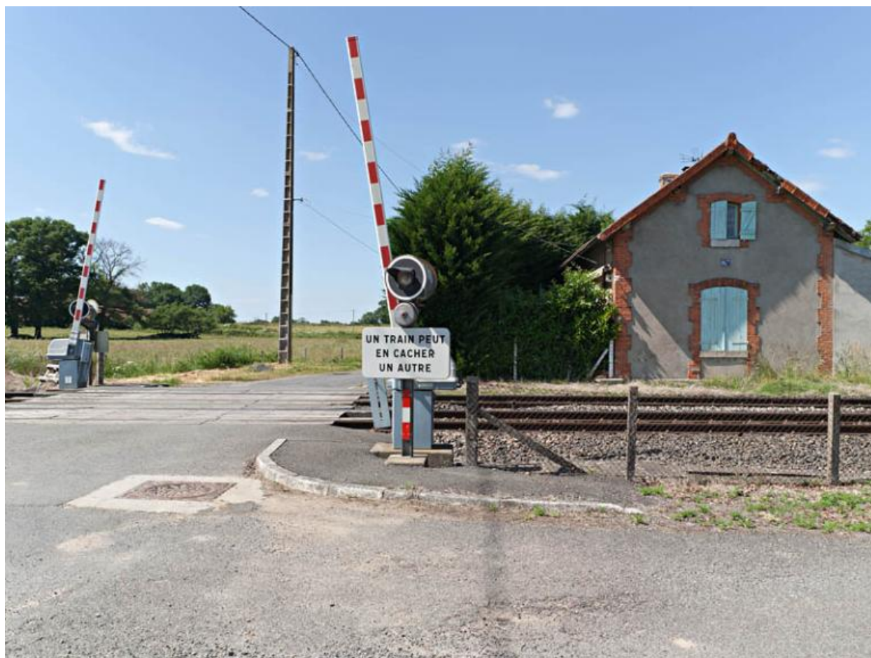
Maison de garde-barrière, au passage à niveau entre les Bruyères et les Nautes.
