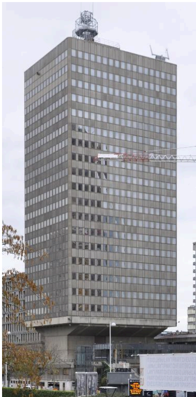
Vue prise depuis le nord-est Phot. Magali Delavenne IVR82_20156902723NUCA
