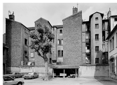
Elévation postérieure de l'immeuble sur cour Phot. Jean-Marie Refflé IVR82_20016901761P
