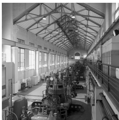
Vue d'ensemble nord Phot. Eric Dessert IVR82_20026904352X
