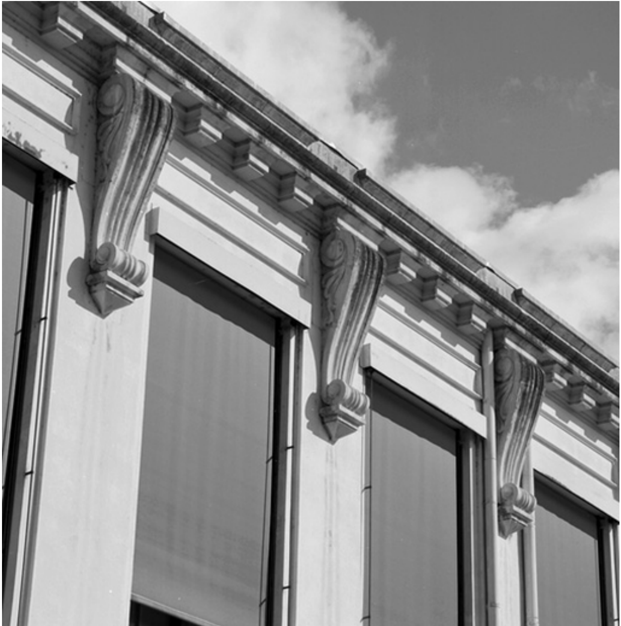
Décor façade aval
