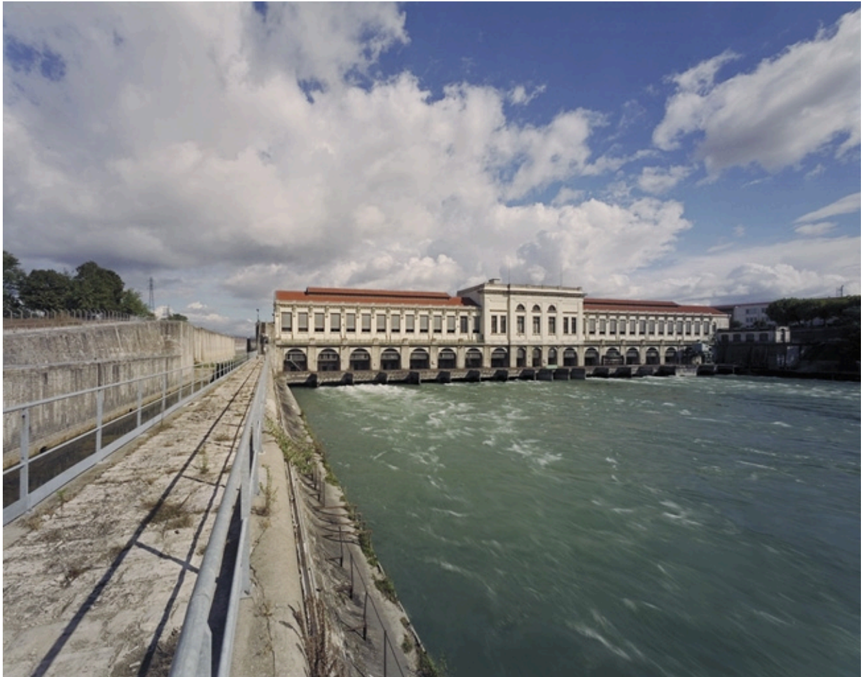
Vue générale, façade aval (est)
