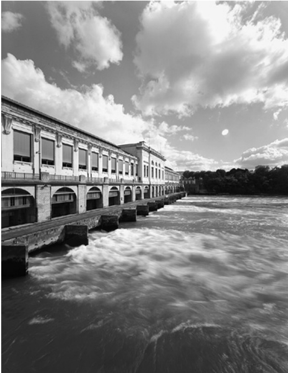
Façade aval arrière-becs
