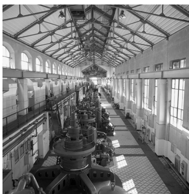
Vue d'ensemble salle des machines Phot. Eric Dessert IVR82_20026904353X
