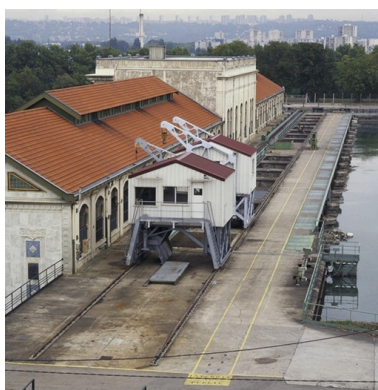
Dégrilleurs amont Phot. Eric Dessert IVR82_20026904329XE
