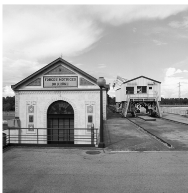
Façade sud Phot. Eric Dessert IVR82_20026904326X
