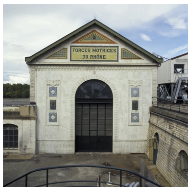
Façade sud, entrée de la salle des machines Phot. Eric Dessert IVR82_20026904331XE
