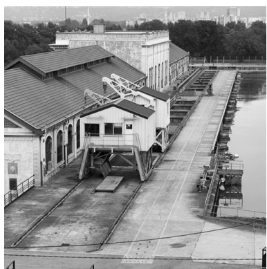
Vue des deux dégrilleurs amont Phot. Eric Dessert IVR82_20026904325X
