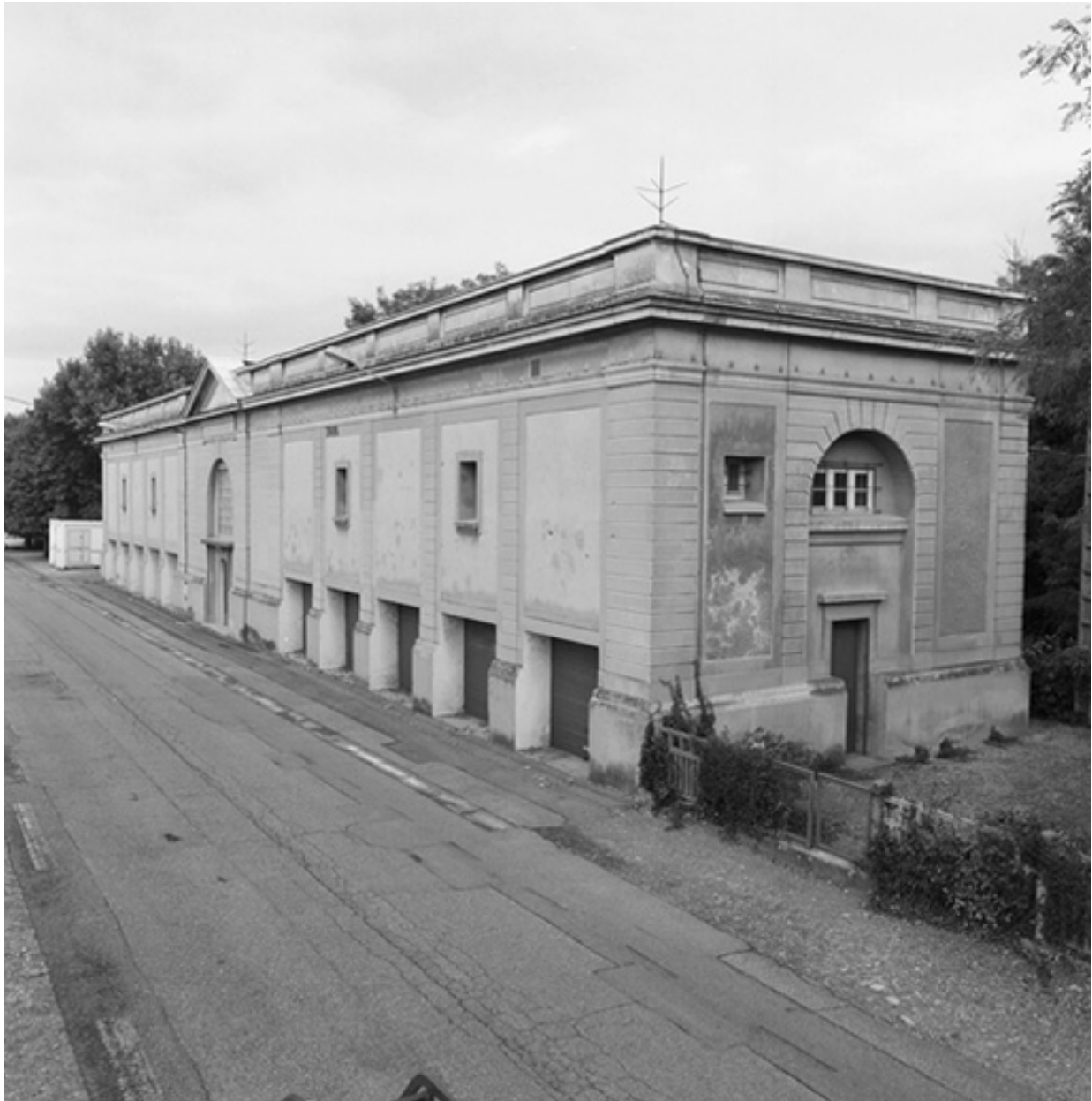
Ancienne sous-station du survolteur devenue le célibatorium
