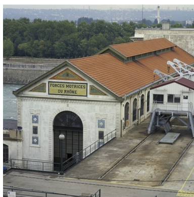
Vue sud : détail toit aérateur Phot. Eric Dessert IVR82_20026904328XE
