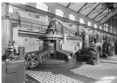
Turbine G5, constructeur : Théodore Bell et Cie Phot. Eric Dessert IVR82_20026904356P
