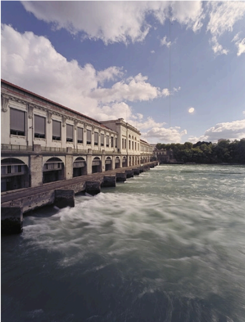
Vue sud-est façade aval, arrière-becs
