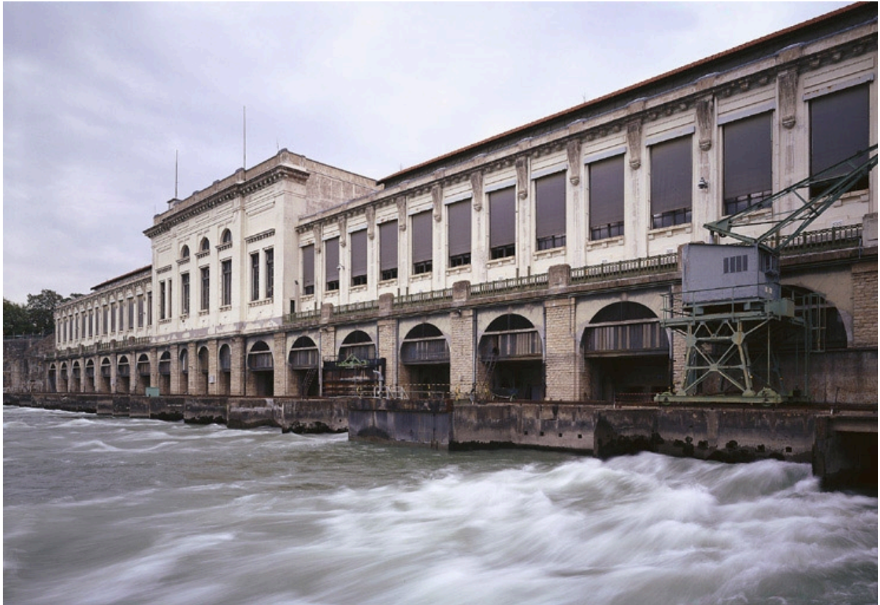
Vue générale, façade aval (est)
