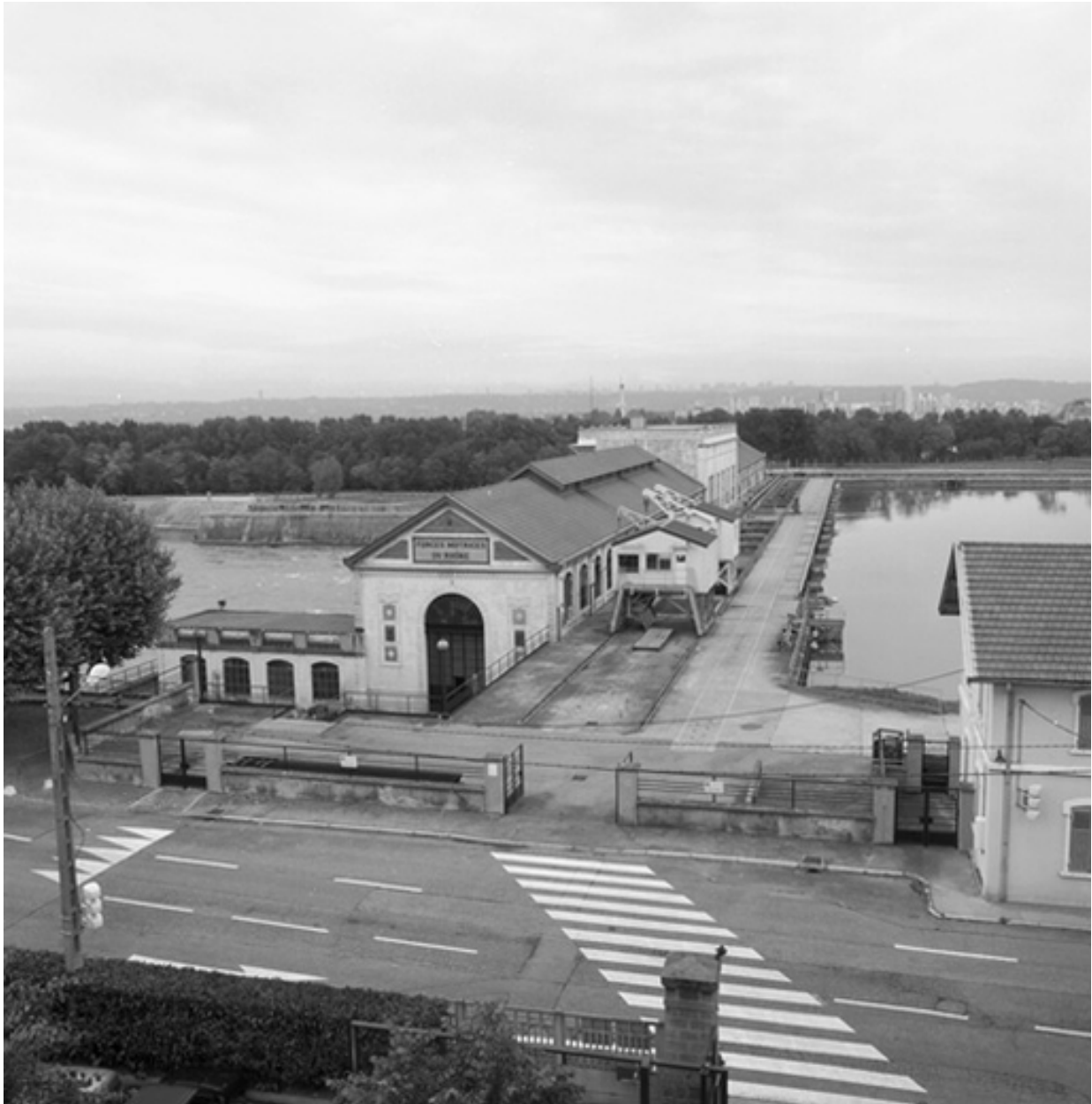
Vue d'ensemble sud-ouest
