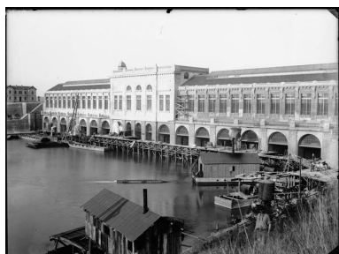
[Construction de la centrale de Cusset. Canal de Jonage et centrale hydroélectrique de Cusset]. 1897-1908. 1 fotogr. : plaque de verre, n. et b. (AD Rhône. 156 J 398, n°141) Phot. AD Rhône, Autr. auteur inconnu IVR82_20106902652NUCAB
