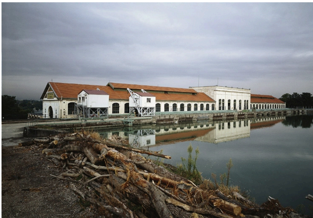
Façade amont (ouest)
