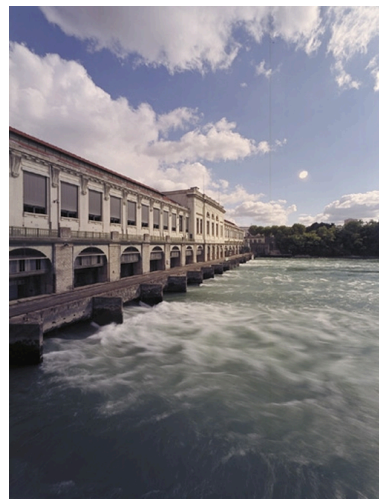
Vue sud-est façade aval, arrière-becs Phot. Eric Dessert IVR82_20026904312VE
