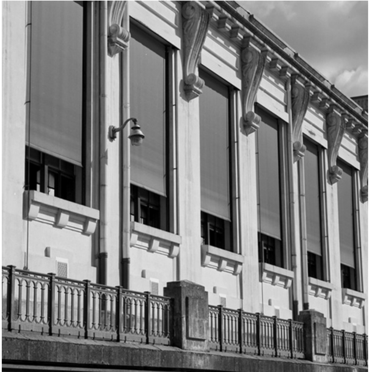
Détail façade aval
