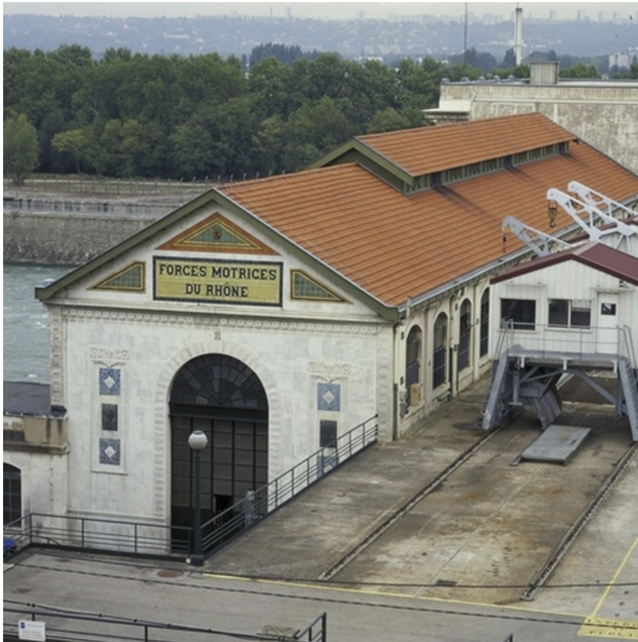
Vue sud : détail toit aérateur
