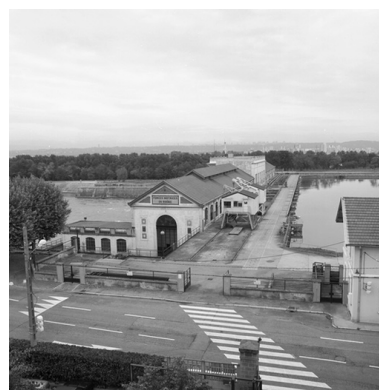
Vue d'ensemble sud-ouest Phot. Eric Dessert IVR82_20026904330X
