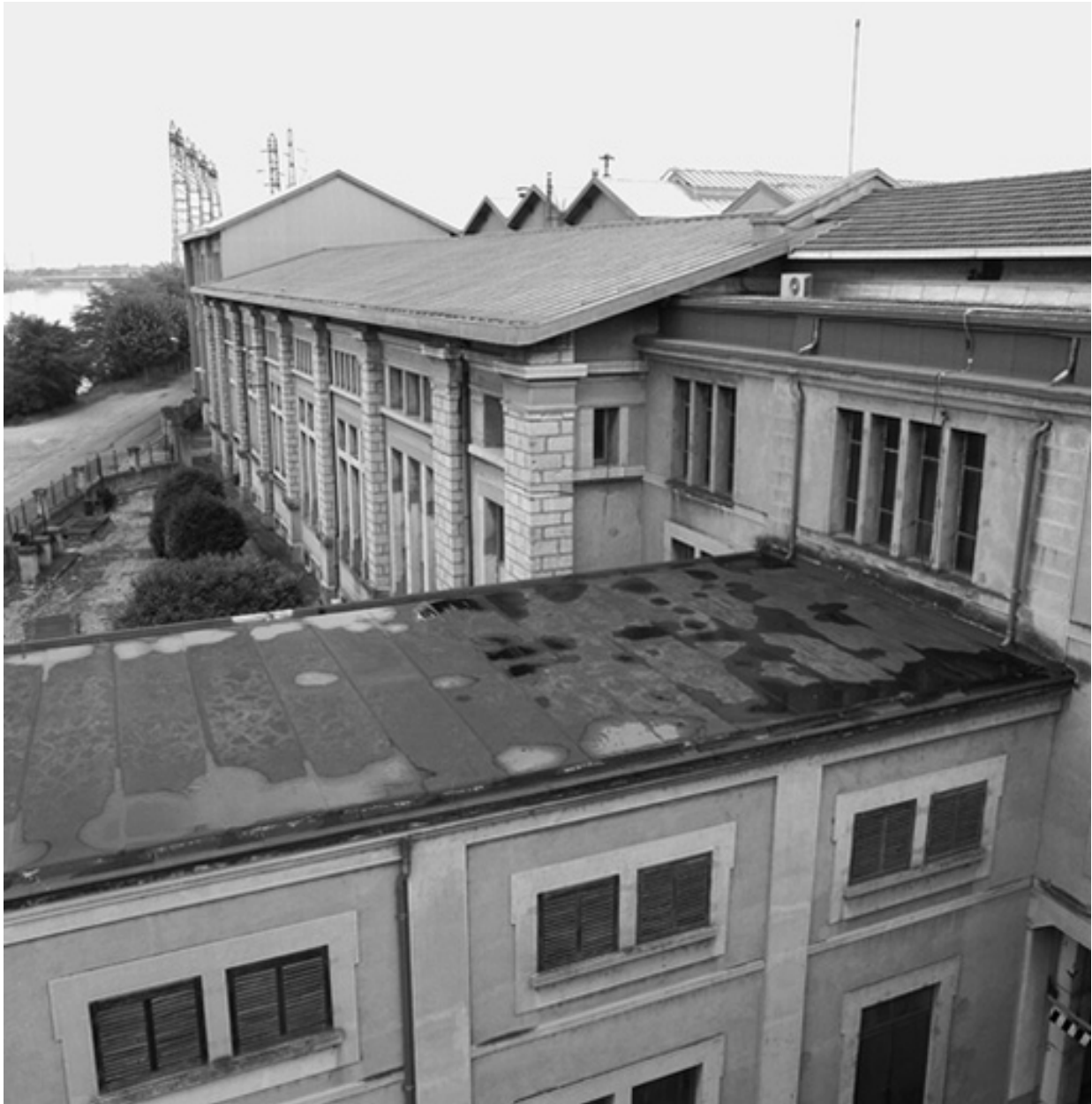
Centrale thermique, vue nord
