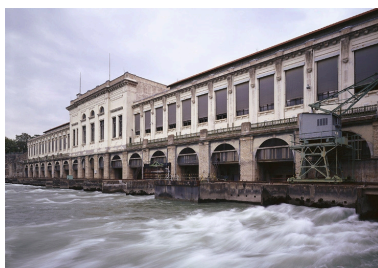
Vue générale, façade aval (est) Phot. Eric Dessert IVR82_20026904305PE
