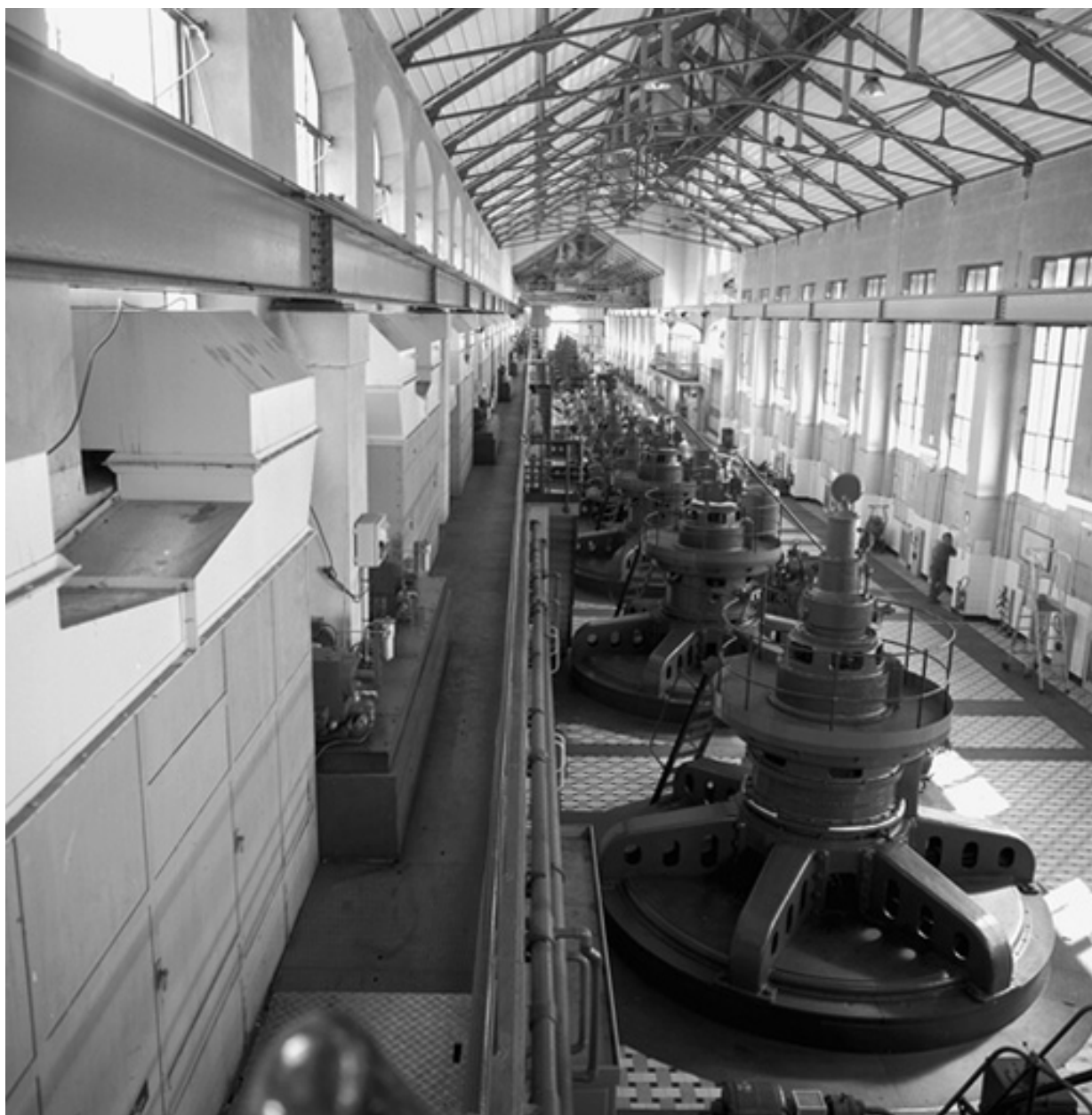
Vue d'ensemble sud-ouest
