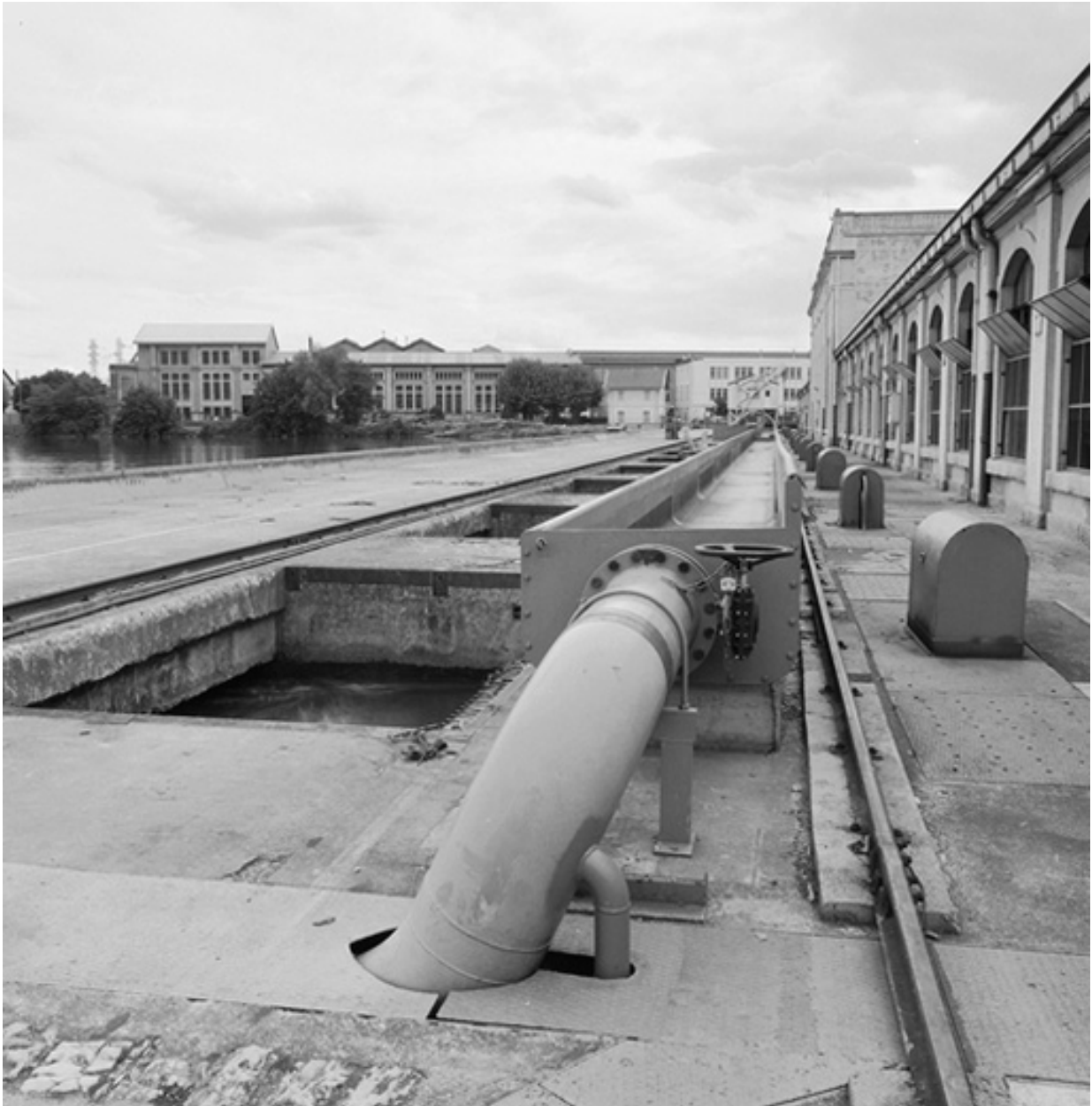
Détail façade amont
