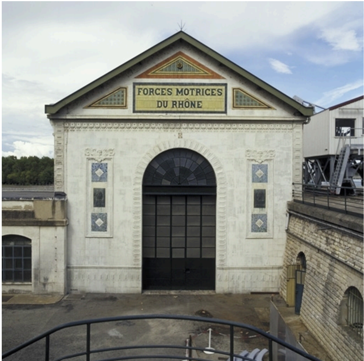
Façade sud, entrée de la salle des machines
