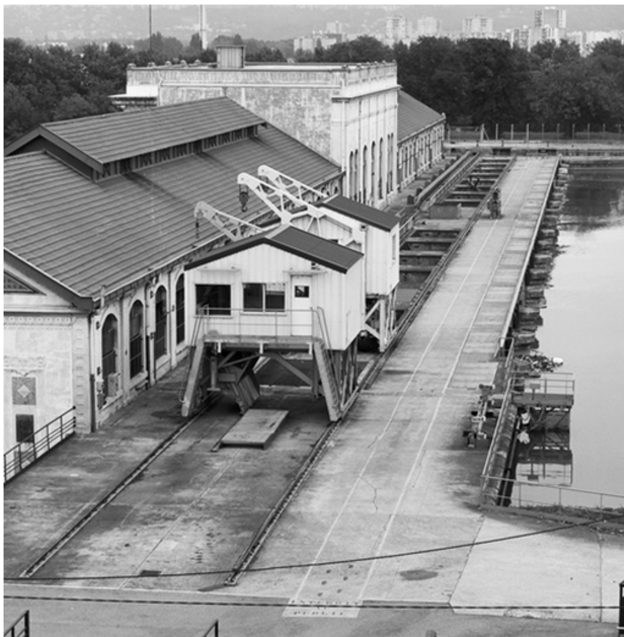
Vue des deux dégrilleurs amont
