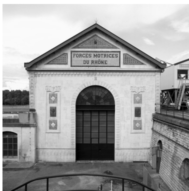
Façade sud Phot. Eric Dessert IVR82_20026904332X
