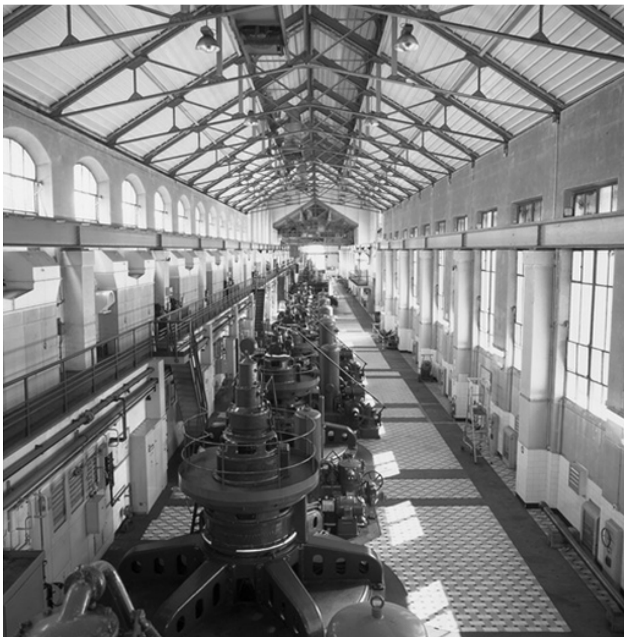
Vue d'ensemble sud de la salle des machines
