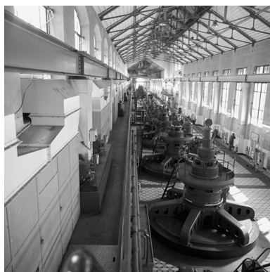
Vue d'ensemble sud-ouest Phot. Eric Dessert IVR82_20026904355X
