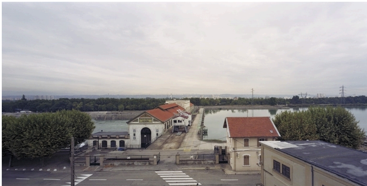
Vue d'ensemble sud-ouest
