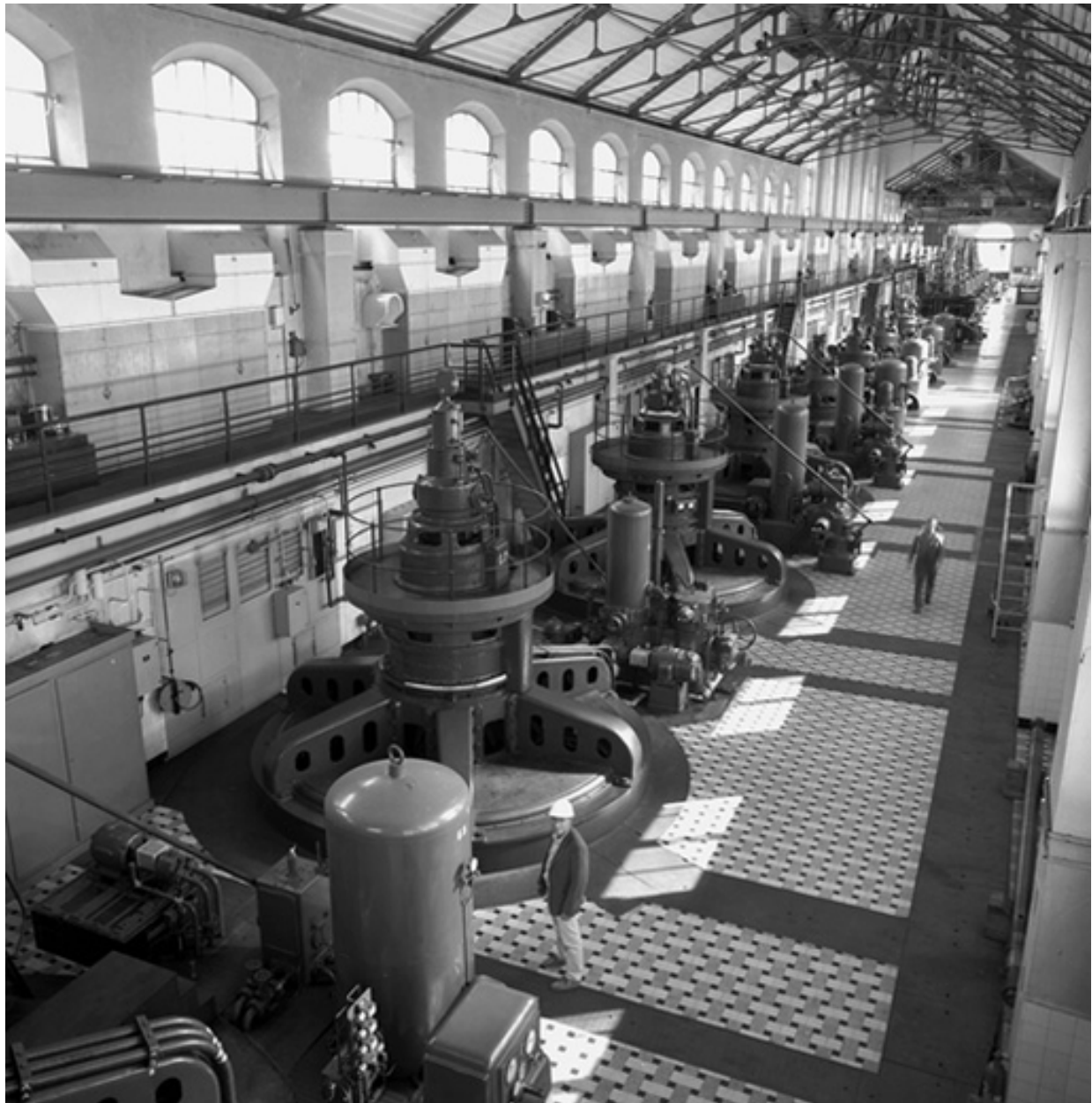
Vue d'ensemble sud-est
