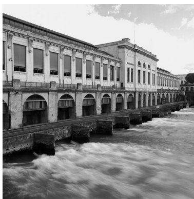
Détail façade aval Phot. Eric Dessert IVR82_20026904314X
