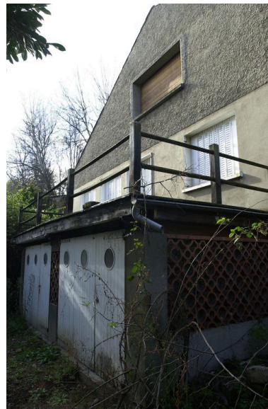
Maison située au bout de l'impasse à l'est sur la parcelle BW 19 Phot. Bernard Ducouret IVR82_20026901553NUCA
