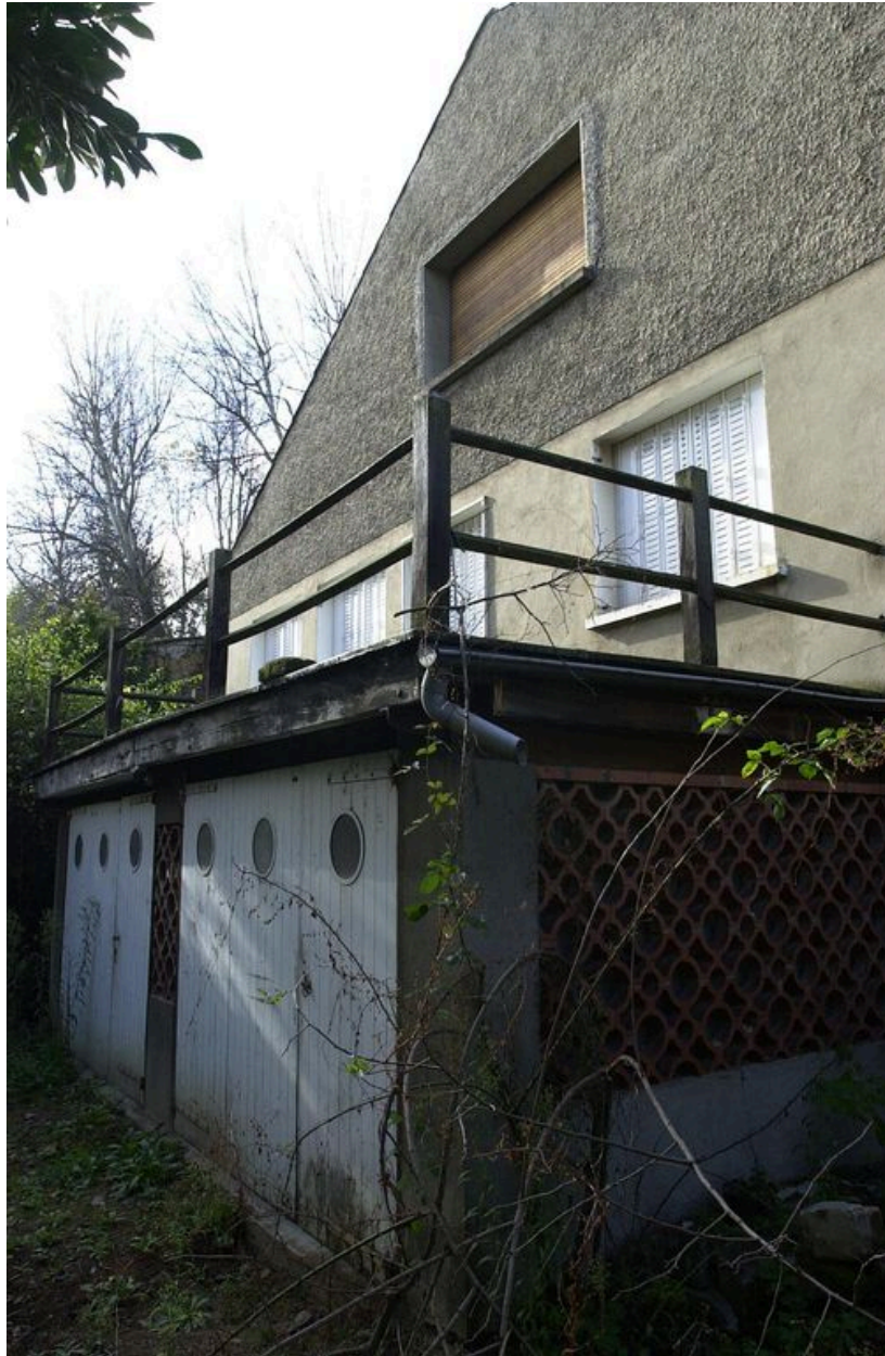
Maison située au bout de l'impasse à l'est sur la parcelle BW 19
