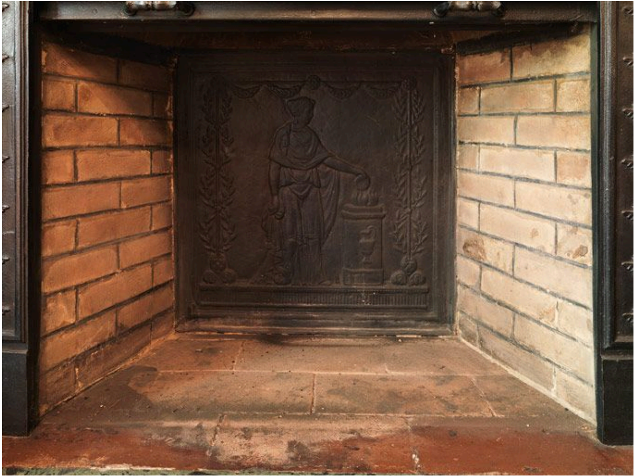
Détail de la plaque de cheminée de la salle du conseil.
