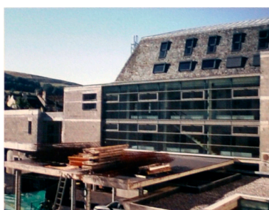
L'ancienne église en phase finale du chantier de reconstruction (Phot. Atelier d'architecture Jean-François Laurent) Phot. Atelier d'architecture Jean-François Laurent IVR84_20231500078NUCA
