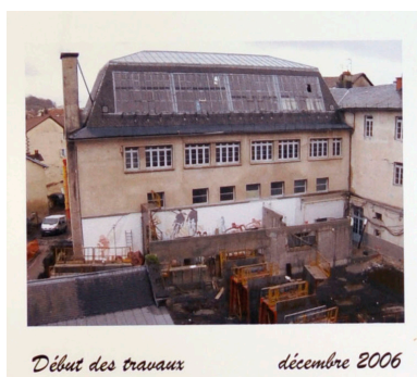
L'ancienne église en 2006, au début du chantier de reconstruction du collège, avec la salle de dessin au dernier niveau ( (Phot. Atelier d'architecture Jean-François Laurent) Phot. Atelier d'architecture Jean-François Laurent IVR84_20231500077NUCA
