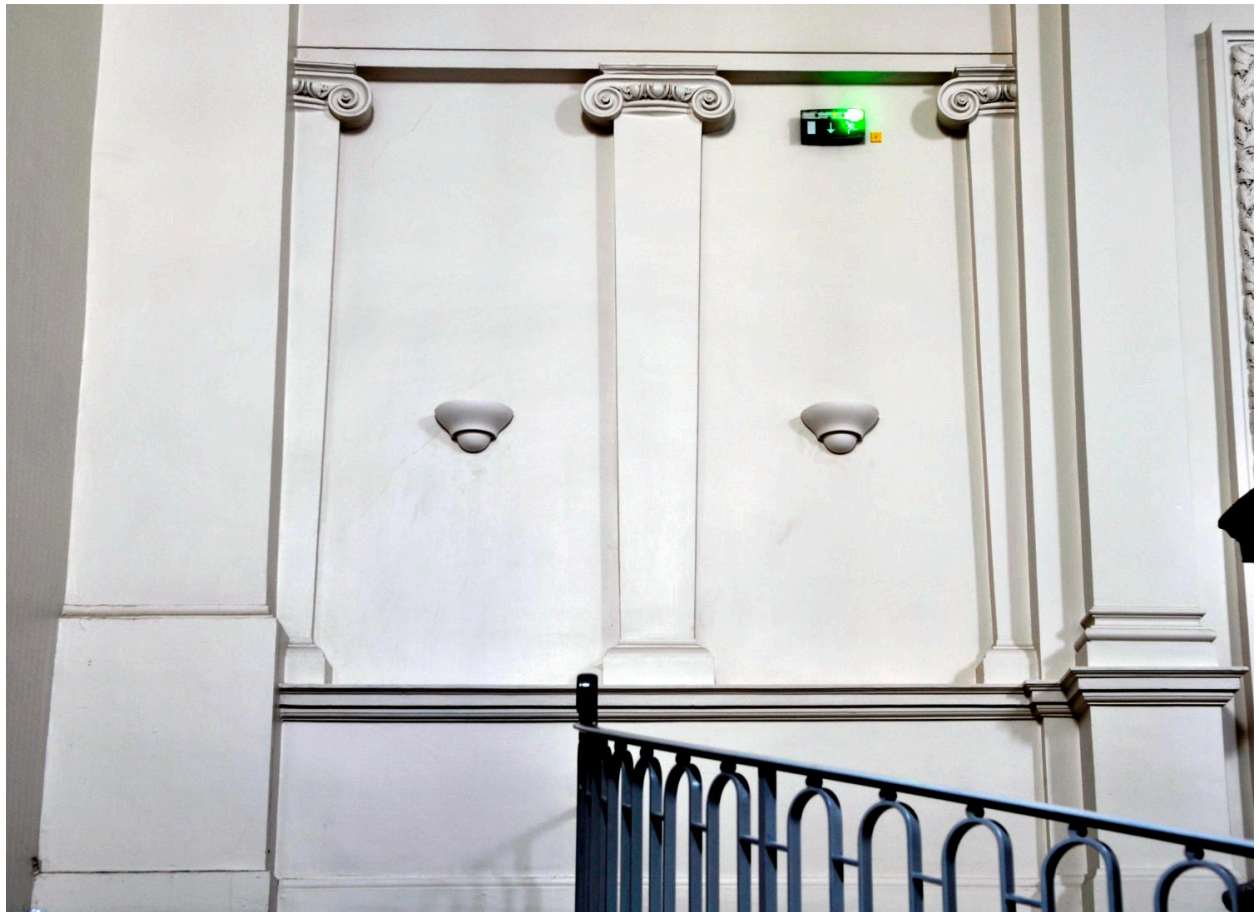
Vestibule, détail du décor d'architecture
