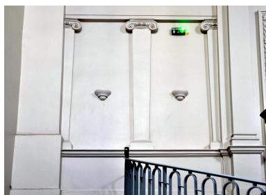
Vestibule, détail du décor d'architecture Phot. Catherine Guégan IVR84_20201500156NUCA
