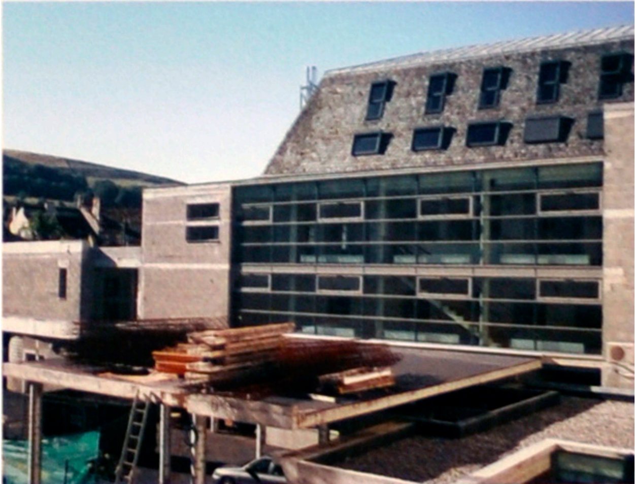
L'ancienne église en phase finale du chantier de restructuration (Phot. Atelier d'architecture Jean-François Laurent)
