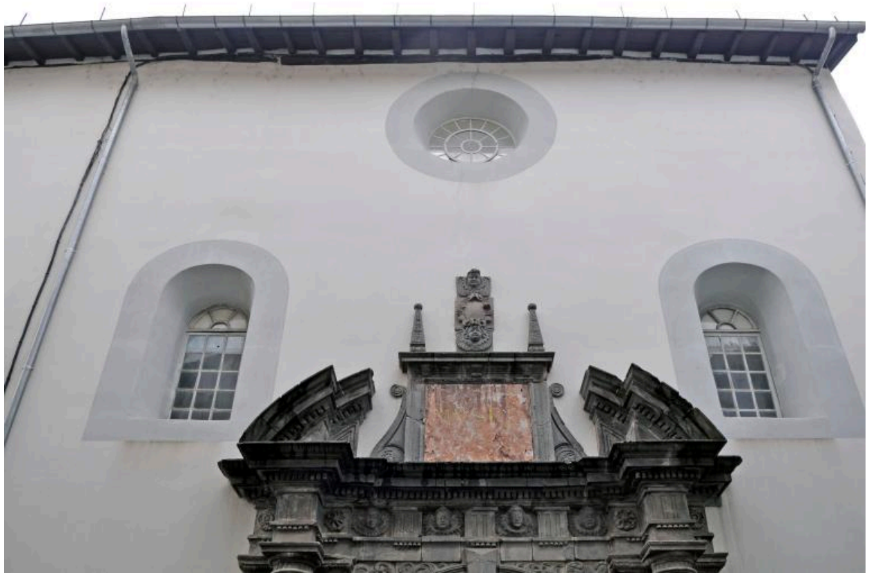
Façade, partie supérieure
