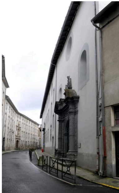
Façade, vue depuis le sud Phot. Catherine Guégan IVR84_20201500159NUCA
