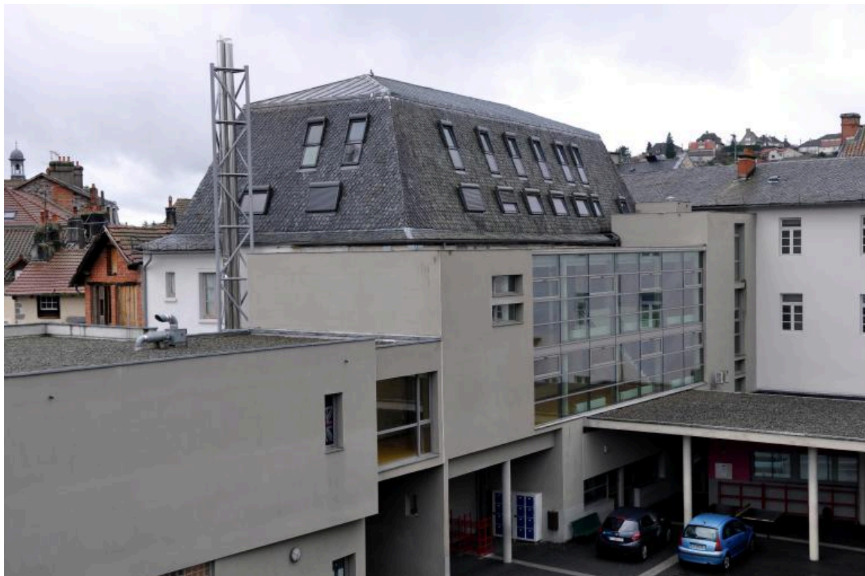
Ancienne église, actuel bâtiment B : vue d'ensemble depuis le nord-est
