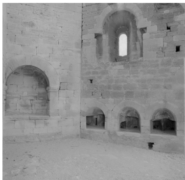
Bâtiment ouest, intérieur du mur sud-ouest. Fenêtre romane, meurtrières multiples et placard bas du mur bouclier à l'ouest. Phot. Alain Franchella IVR82_19992600256X
