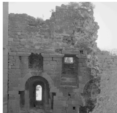
Bâtiment ouest, intérieur du mur sud-ouest. Fenêtre romane et autres ouvertures. Phot. Alain Franchella IVR82_19992600257X
