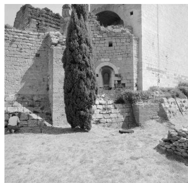
Mur-bouclier sud et fenêtre. Phot. Alain Franchella IVR82_19992600248X
