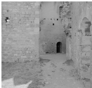
Bâtiment nord et porte d'entrée du donjon. Phot. Alain Franchella IVR82_19992600251X
