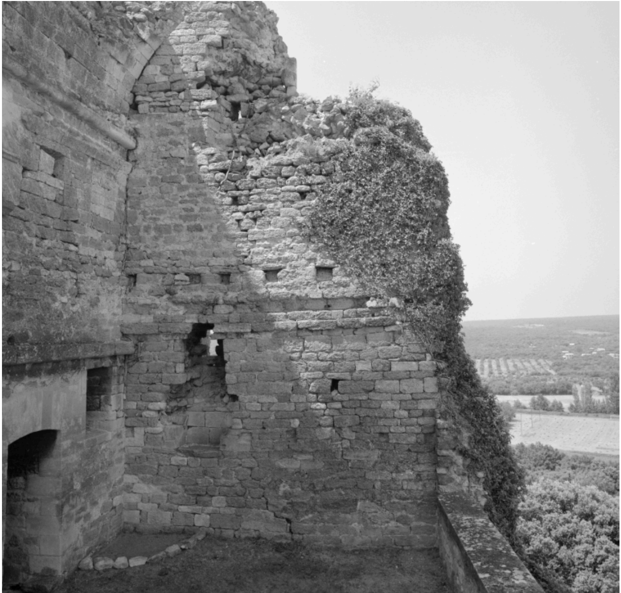
Bâtiment nord, intérieur du mur ouest et départ du mur nord.
