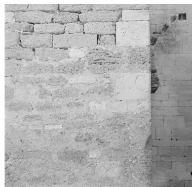
Détail des inscriptions 74 et S.C. sur des pierres changées au XIXe siècle sur le bâtiment nord. Phot. Alain Franchella IVR82_19992600255X
