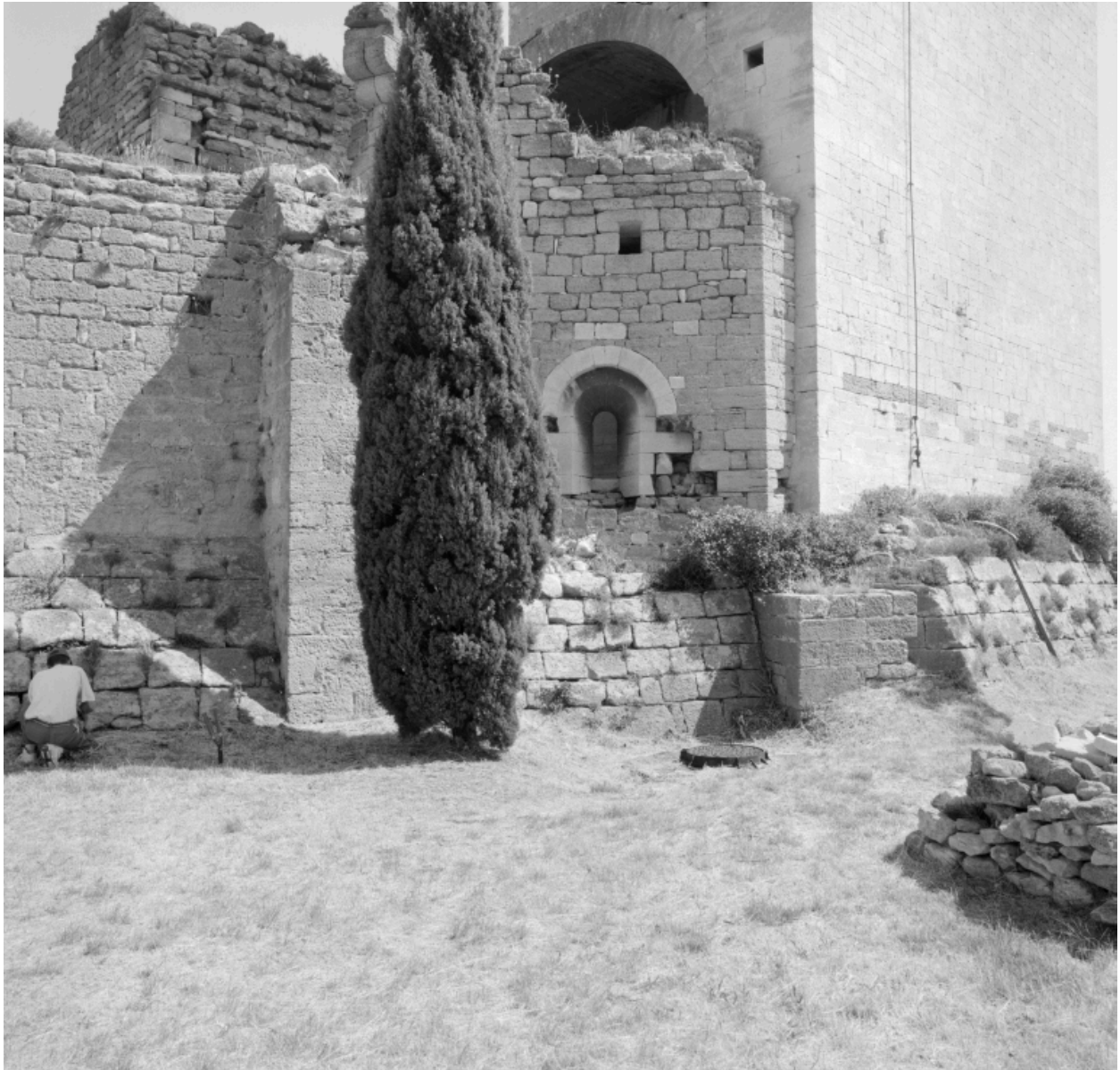
Mur-bouclier sud et fenêtre.
