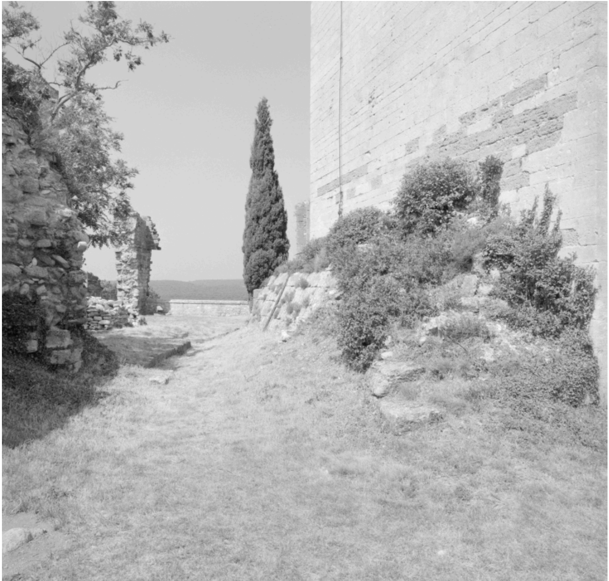
Elévation sud et vestiges de la chapelle castrale.
