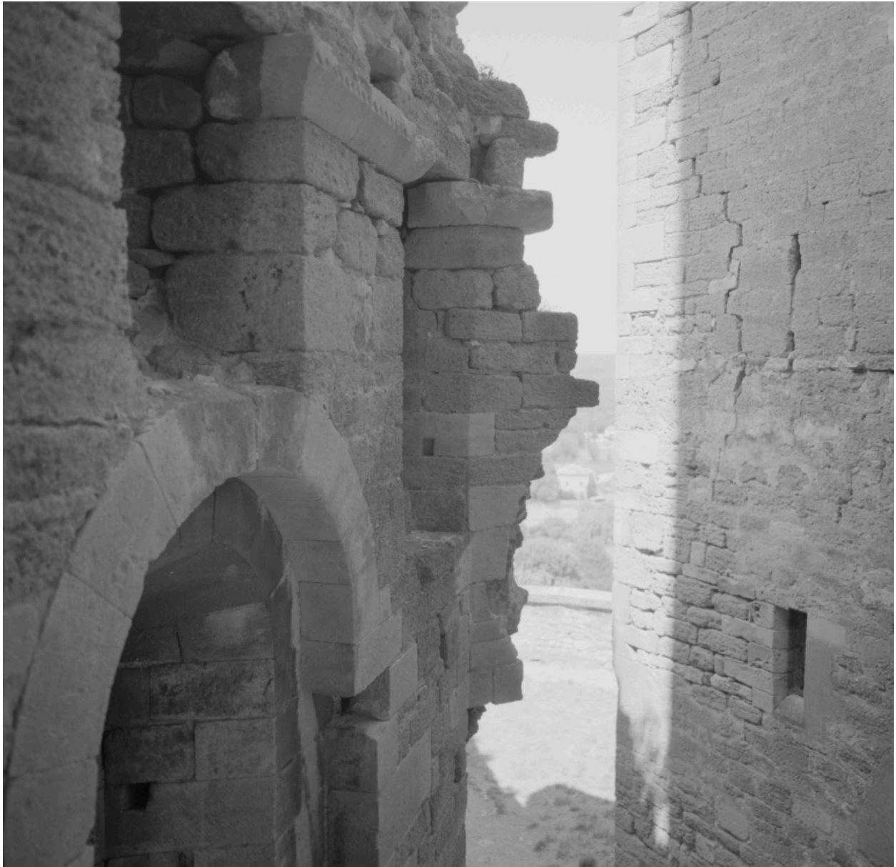
Bâtiment ouest, baies.
