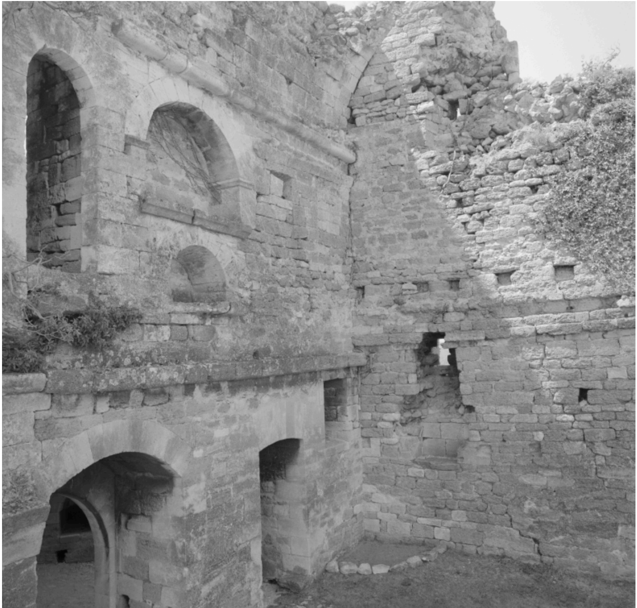
Bâtiment nord, intérieur du mur sud.
