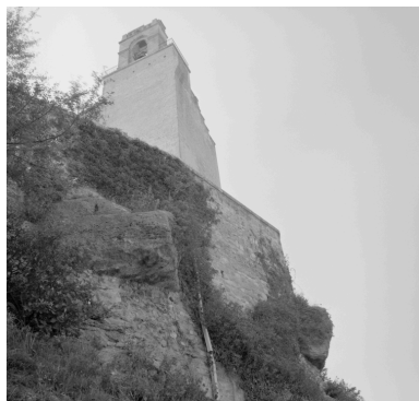
La tour et un mur de soutènement construits en 1895 pour consolider la plate-forme du plateau des Puits. Phot. Alain Franchella IVR82_19992600290X
