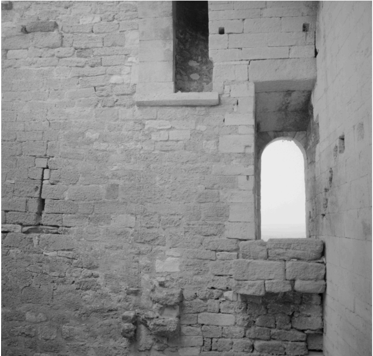
Bâtiment ouest. Porte haute nord et porte au 1er étage.
