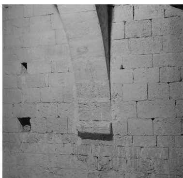
Détail de l'appareil à l'intérieur du donjon et départ d'un arc. Phot. Alain Franchella IVR82_19992600271X
