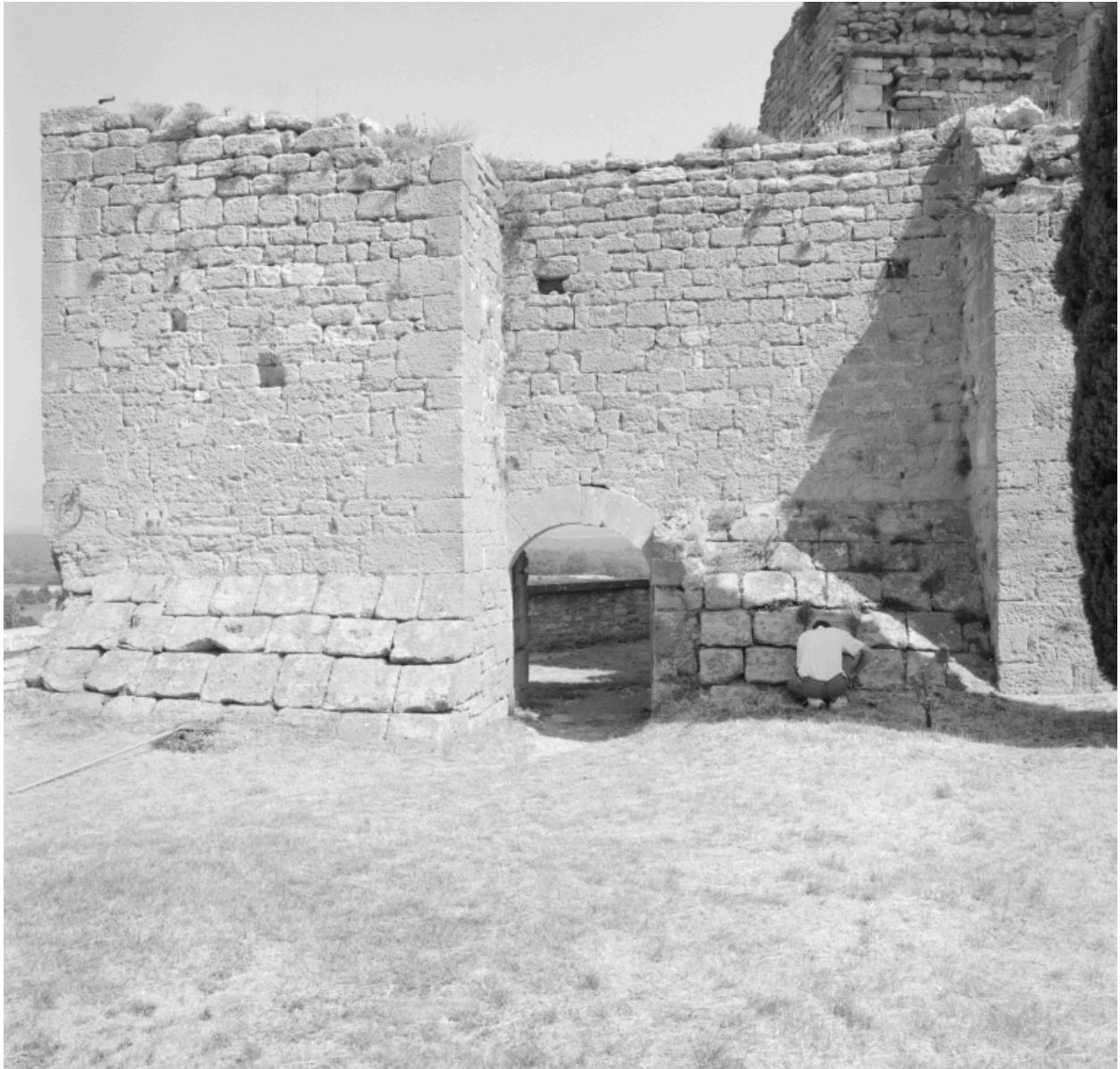
Mur-bouclier sud percé d'une porte.
