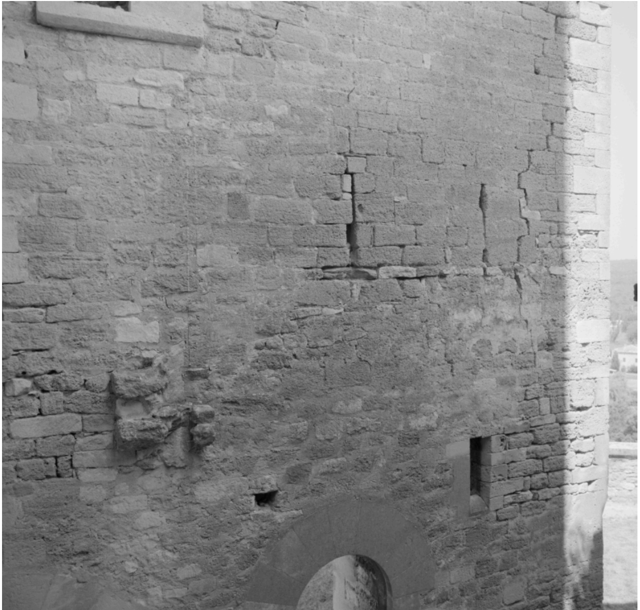
Bâtiment ouest, parties hautes du mur nord.
