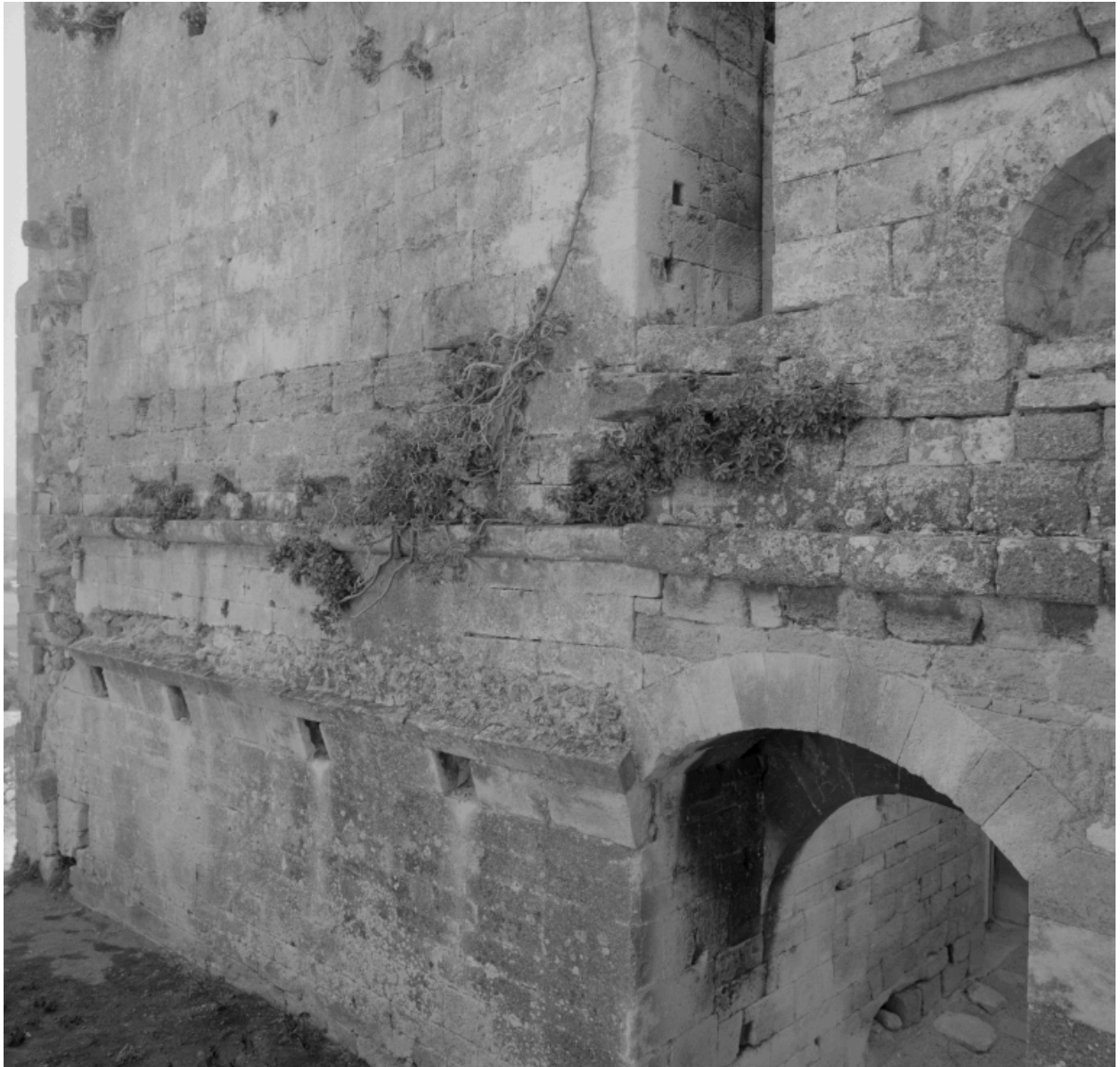
Bâtiment nord, intérieur du mur sud, parties hautes.
