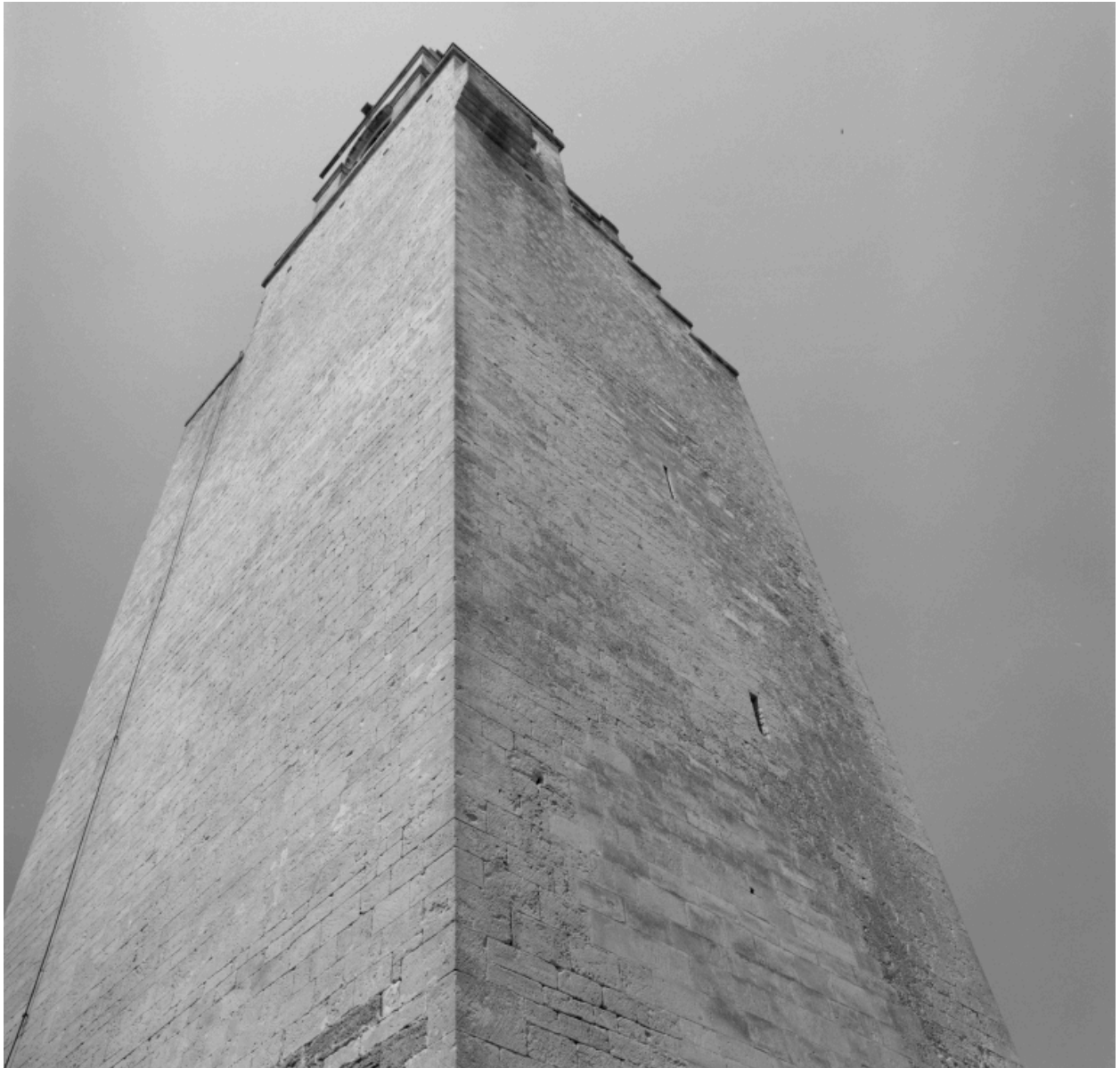
Elévation de la tour depuis le sud-ouest.
