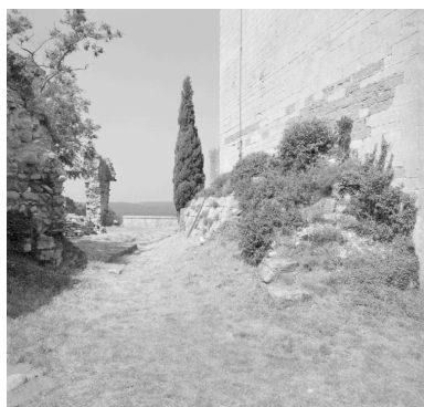
Elévation sud et vestiges de la chapelle castrale. Phot. Alain Franchella IVR82_19992600253X
