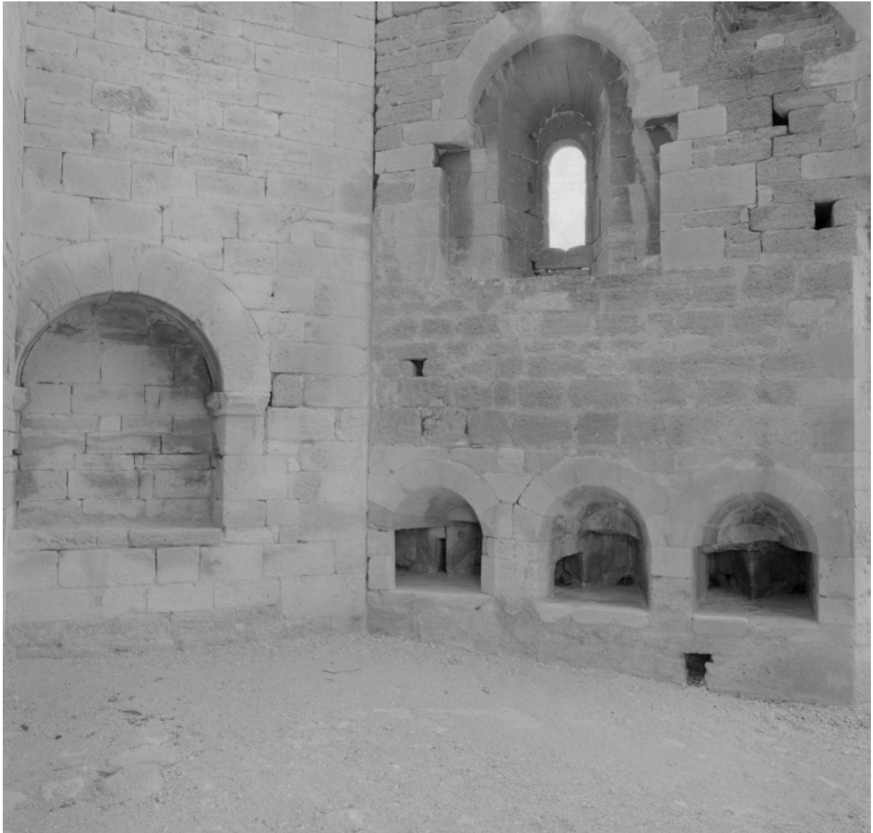
Bâtiment ouest, intérieur du mur sud-ouest. Fenêtre romane, meurtrières multiples et placard bas du mur bouclier à l'ouest.
