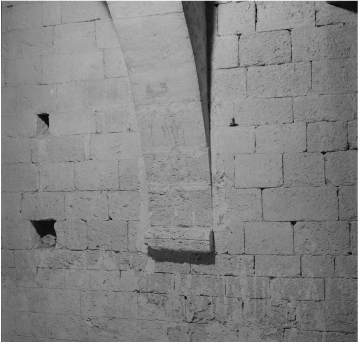
Détail de l'appareil à l'intérieur du donjon et départ d'un arc.
