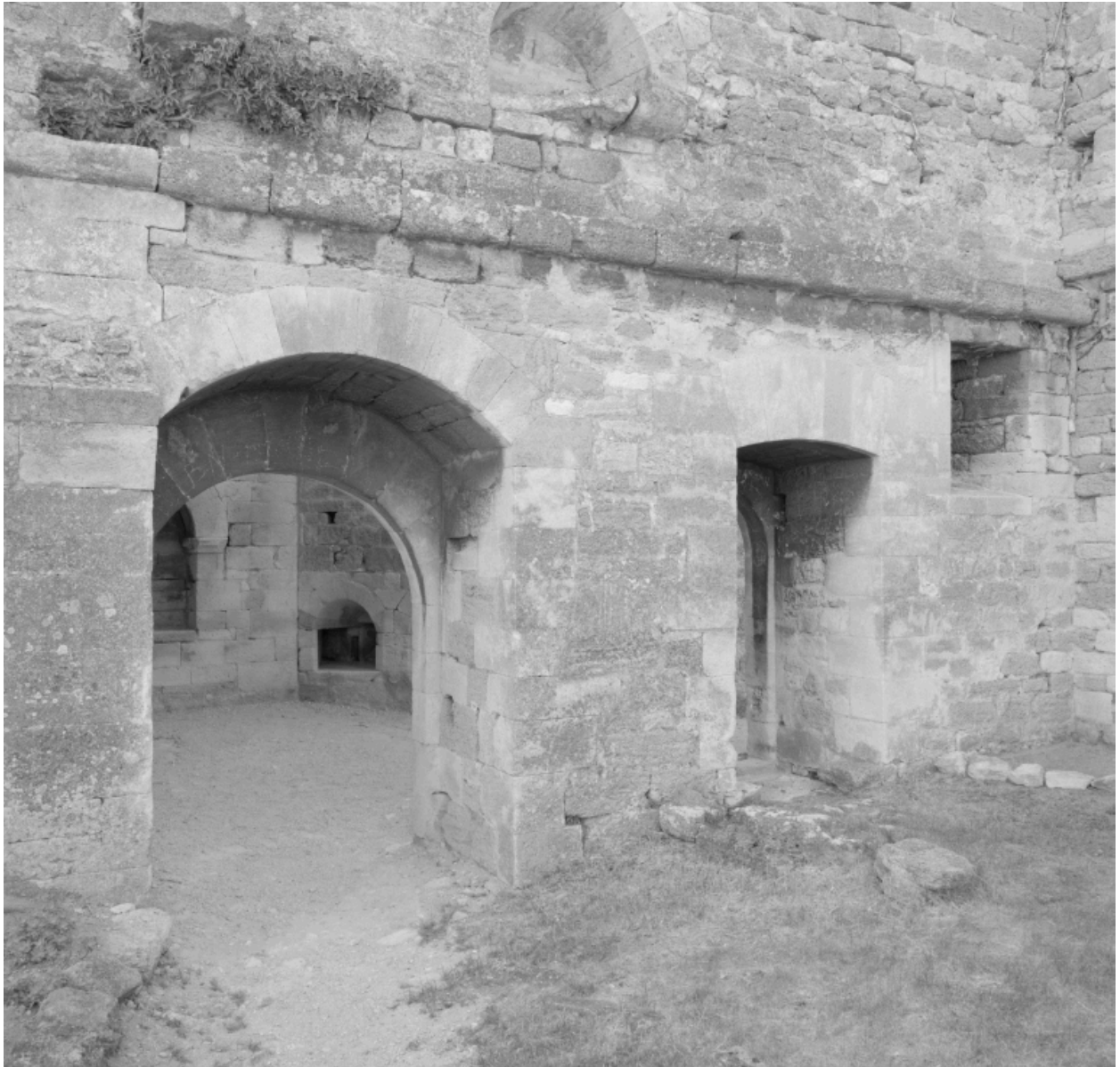
Bâtiment nord, intérieur du mur sud, parties basses.
