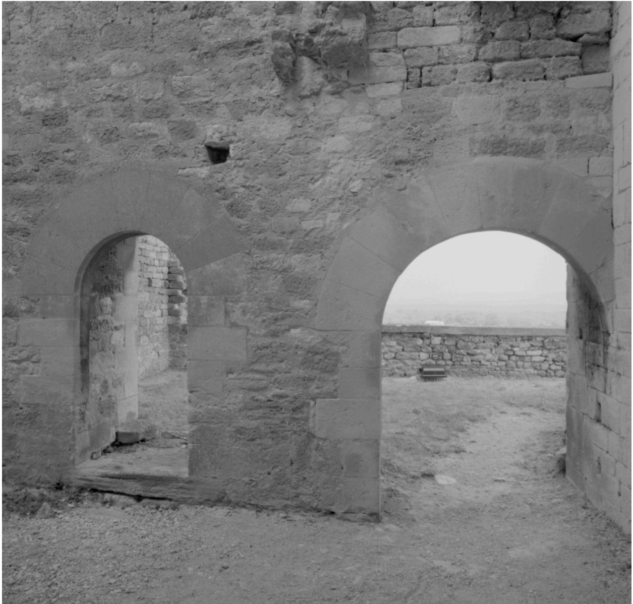
Bâtiment ouest, portes du mur nord.
