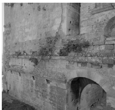
Bâtiment nord, intérieur du mur sud, parties hautes. Phot. Alain Franchella IVR82_19992600268X
