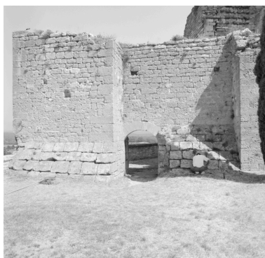
Mur-bouclier sud percé d'une porte. Phot. Alain Franchella IVR82_19992600249X
