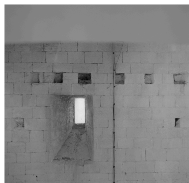
Détail de l'appareil à l'intérieur du donjon, une baie et des trous de boulins. Phot. Alain Franchella IVR82_19992600272X
