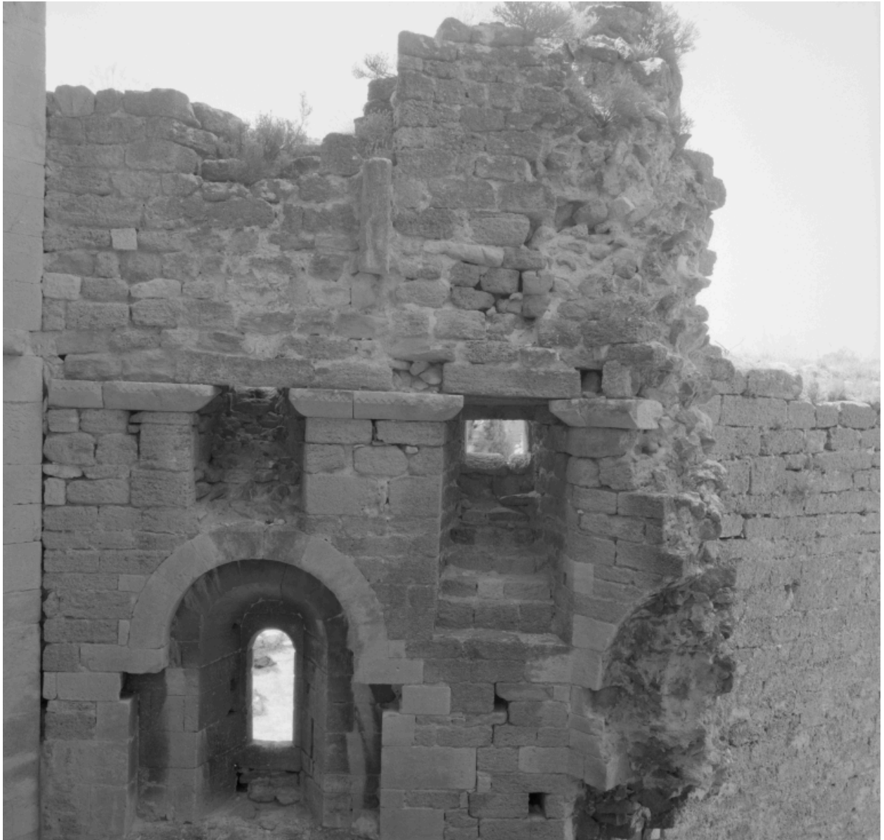
Bâtiment ouest, intérieur du mur sud-ouest. Fenêtre romane et autres ouvertures.
