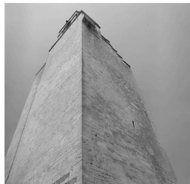
Elévation de la tour depuis le sud-ouest. Phot. Alain Franchella IVR82_19992600270X
