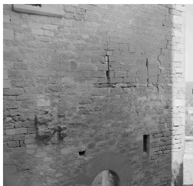
Bâtiment ouest, parties hautes du mur nord. Phot. Alain Franchella IVR82_19992600261X
