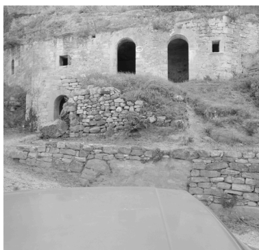
Les murs de soutènement construits en 1895 pour consolider la plate-forme du plateau des Puys.
